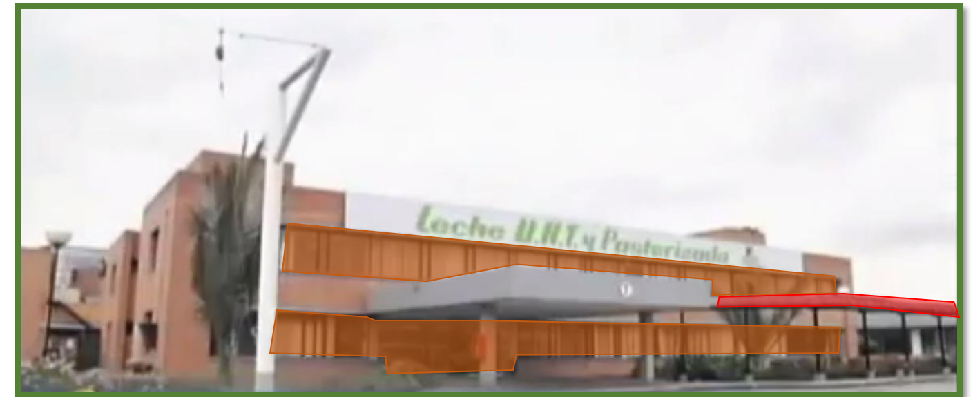
Cubierta de policarbonato ■ Ventanas con acristalamiento de vidrio ■
