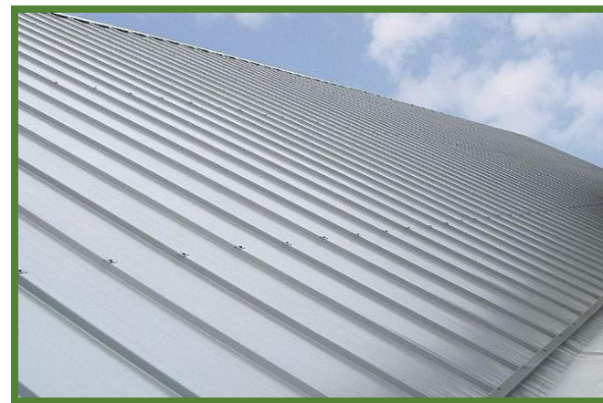
Imagen 55: techo de lámina de acero galvanizado recubierto con zinc extraída de página web http://www.preguntaleasherwin.cl/wp-
