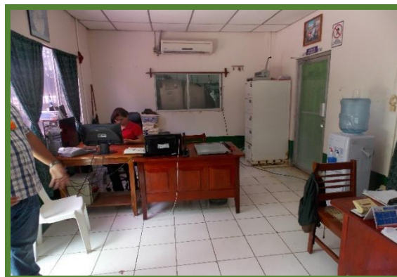
Imagen 38: Piso de cerámica y puertas de aluminio y vidrio, foto obtenida en la primera visita de campo.
