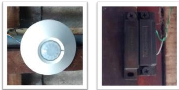
*Fig. 42: Sensor infrarrojo de movimiento y contacto magnético*
