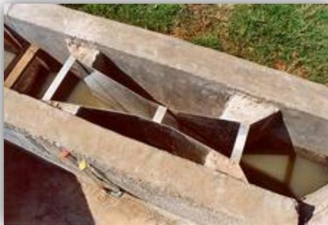
FIGURA 5.- Medidor Parshall
