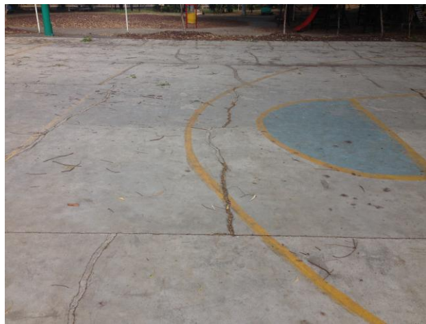
Losa de concreto cancha de basquetbol y voleibol fotografía tomada por: Bladimir Melendez
