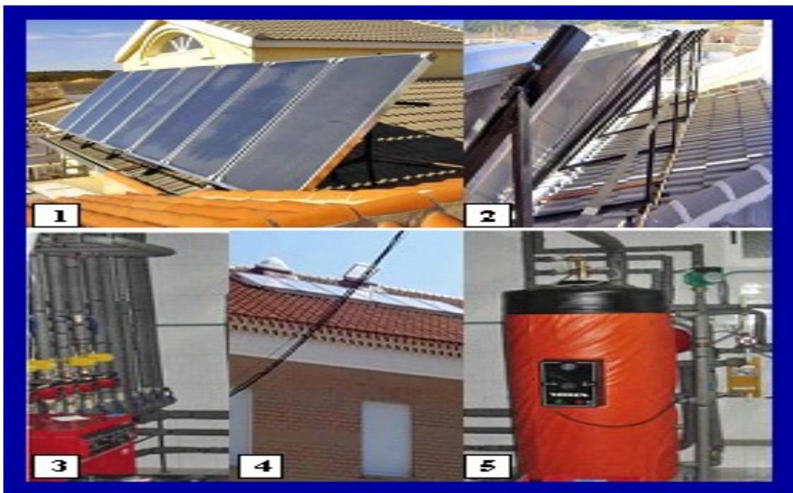
Instalación del sistema térmico solar de tipo forzado: **1.** Colocación de paneles solares en el techo, **2.** uso de soporte metálico para colectores, **3.** Acondicionamiento de tubería de distribución, **3.** Soldaduras y conexión, **4.** Tanque de almacenamiento aislado.
