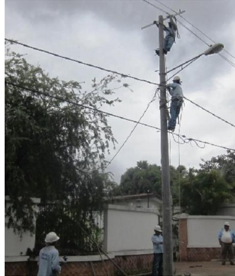
**Imagen 7.** Liniero A y B realizando trabajo en altura SEL, S.A
