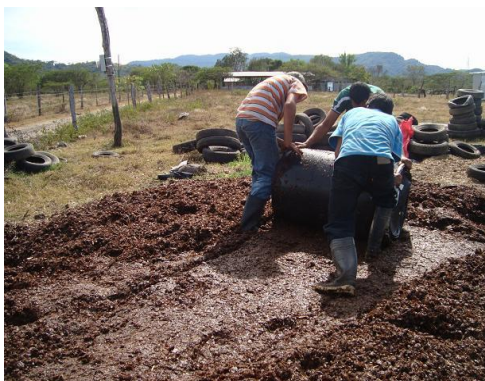
Figura 3. Compactación de pulpa de café con un barril
