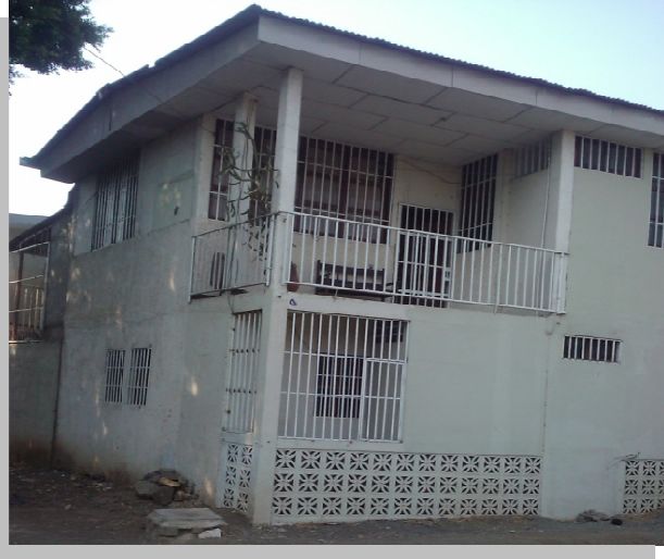
Foto 7: Vivienda en Buen Estado. Fuente: González- Polanco 2013
