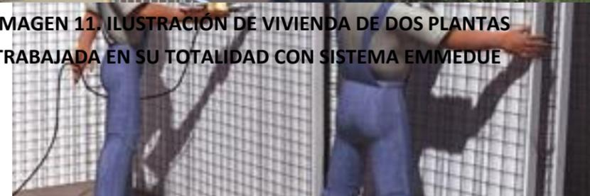
**IMAGEN 12. MONTAJE DE PANELES PARA PARED DE SISTEMA**
