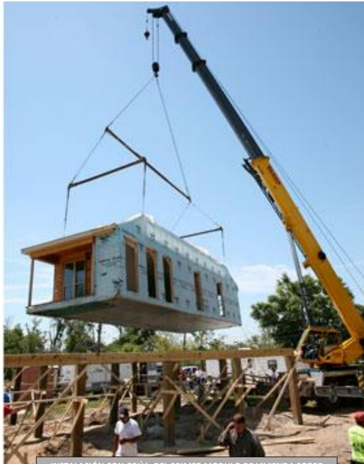
INSTALACIÓN CON GRÚA DEL PRIMER MÓDULO DE VIVIENDA SOBRE ESTRUCTURA DE PILOTES
