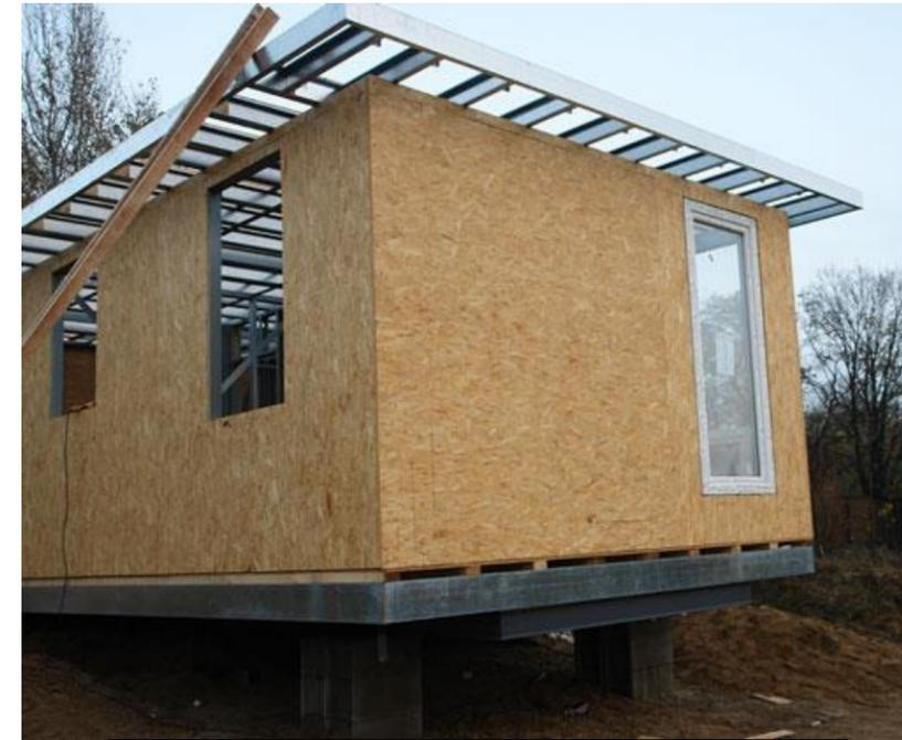
IMAGEN 18. PANELES OSB INSTALADOS PARA FUNCIONAR COMO REVESTIMIENTO EXTERIOR
