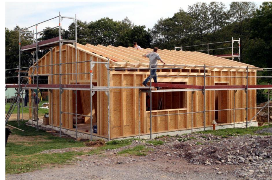
IMAGEN 19 PANELES OSB INSTALADOS PARA FUNCIONAR COMO REVESTIMIENTO INTERIOR ESTA VEZ EN UNA VIVIENDA CON SISTEMA WOOD FRAME
