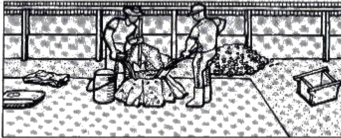
**Figura 14. Dosificación de la arena y cemento**
