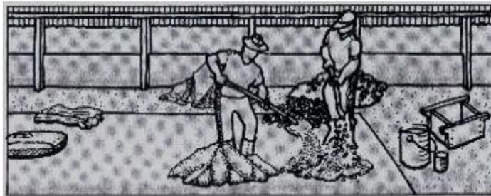
Figura 18. Adición del agua a la mezcla
