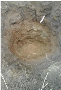
Foto No. 5. Calicata de 1.5mts de profundidad estación 0+000
