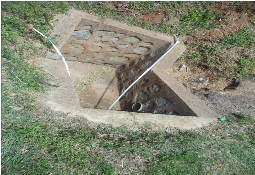
Ilustración II-10: Drenaje transversal del tramo en estudio
