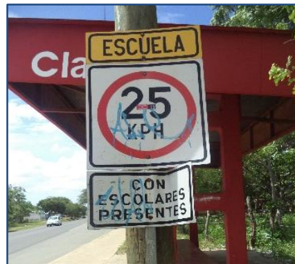
Señalización doblada y manchada Est. 42+487
