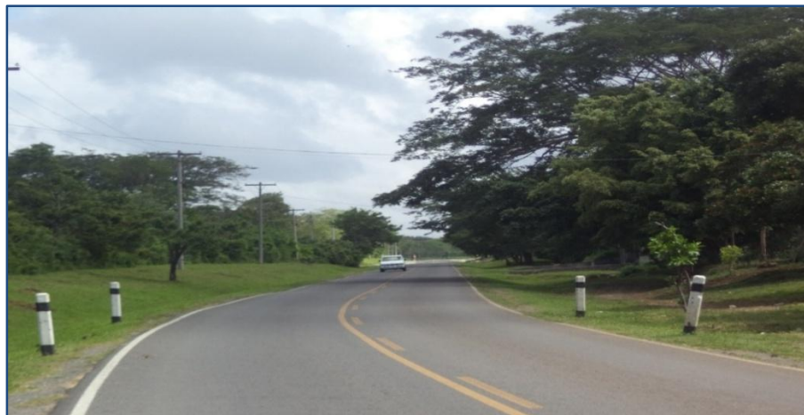
Ilustración II-8: Calzada del tramo Diriamba – La Boquita (Est. 45+600)
