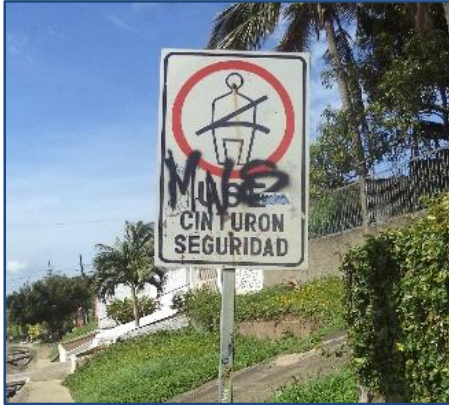
Señalización manchada Est. 42+629
