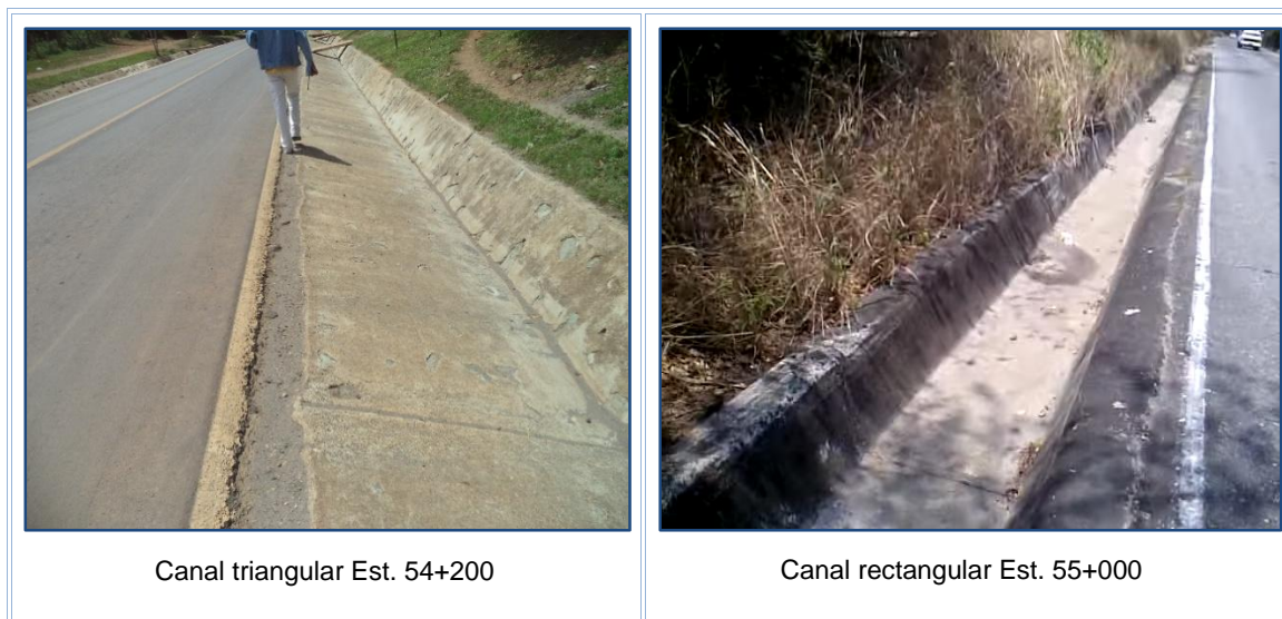
Ilustración II-9: Drenaje horizontal del tramo en estudio
