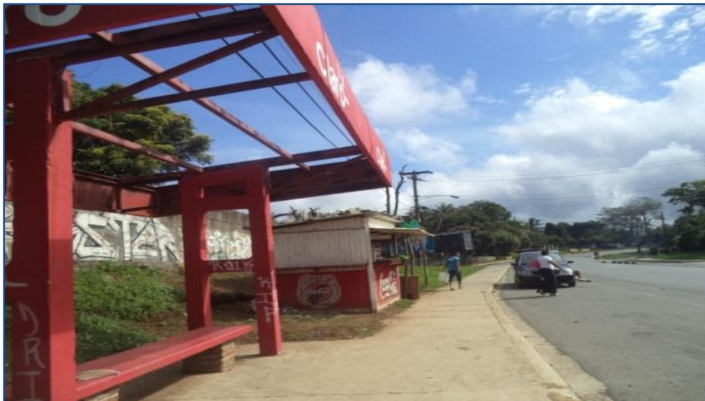
Ilustración II-12: Bahía de bus sin techo San Gregorio (Est. 41+750)
