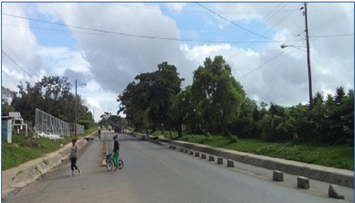
Ilustración II-11: Ciclo vía en ambas bandas del tramo en estudio (Est. 43+100)
