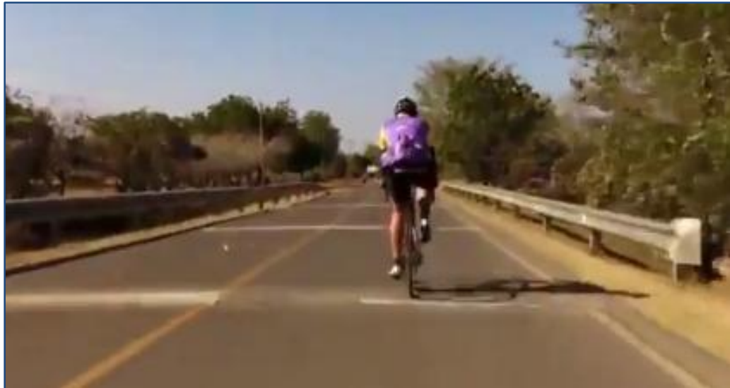
Ilustración II-4: Defensas metálicas en buen estado (Est. 59+200)
