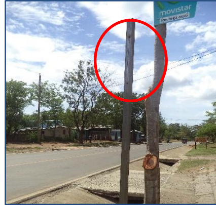
Poste sin señalización Est. 44+234
