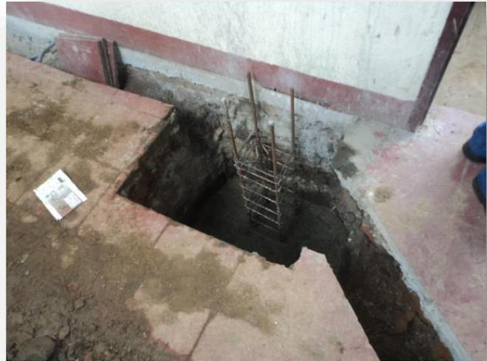
**Imagen 64.** Instalación estructura de soporte de entrepiso
