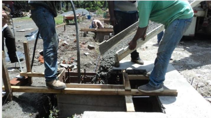
**Imagen 40.** Compactación de material selecto para colocar concreto nuevo
