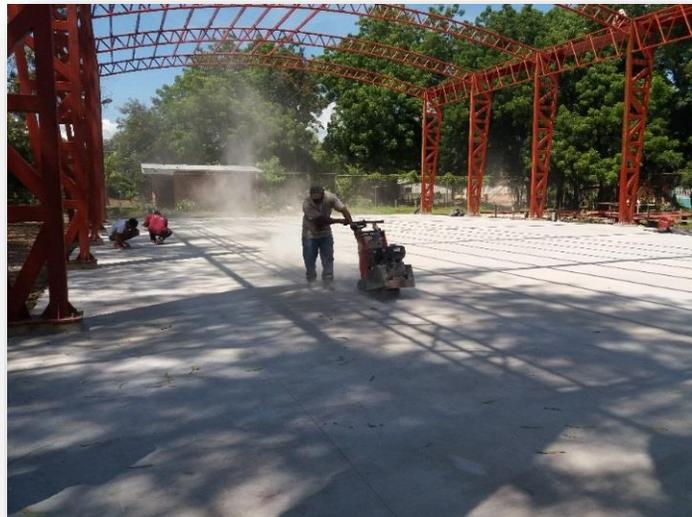
**Imagen 44.** Acabado en losa con herramienta "helicóptero" para pulido de superficie en fino integral
