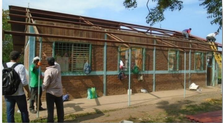
**Imagen 28.**Instalación de cubierta de techo nueva troquelada color rojo E-25
