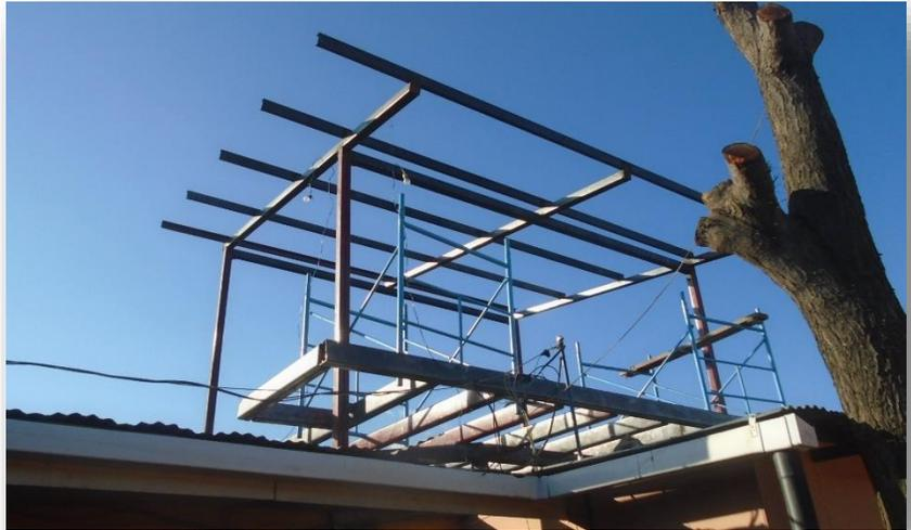
**Imagen 66.** Instalacion de estructura de cielo falso en 1er nivel
