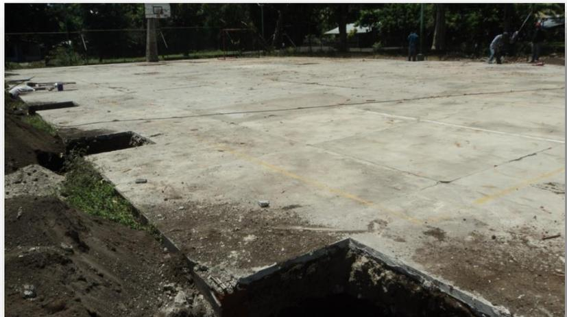
**Imagen 38.** Demolición de losa existente
