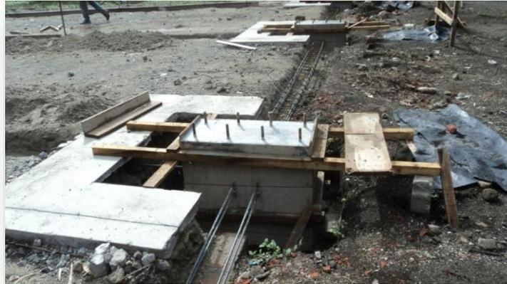
**Imagen 43.** Corte de losa de concreto nuevo y aplicación de sikaflex
