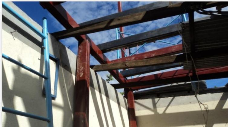
**Imagen 65.** Instalacion de estructura de paredes de 2do nivel y estructura de techo
