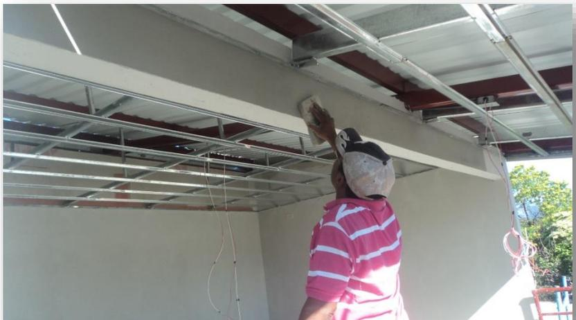
**Imagen 68.** Instalacion de estructura de cielo falso en 2do nivel
