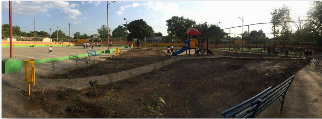
Ilustración 43: Foto. Construcción Parque Cacique Agateyte en el Municipio de El Viejo. Recuperado de: Fuente propia
