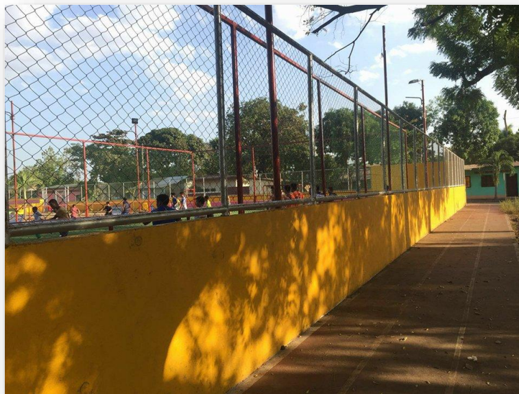
Ilustración 44: Foto. Construcción Parque Cacique Agateyte en el Municipio de El Viejo. Recuperado de: Fuente propia
