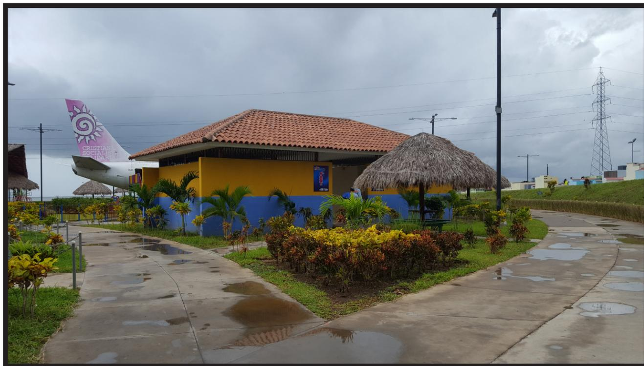
Servicios sanitarios; Diseño simple pero funcional, se utilizó el sistema constructivo de Covintec y cubierta de teja lo que crea una armonía con su entorno.
