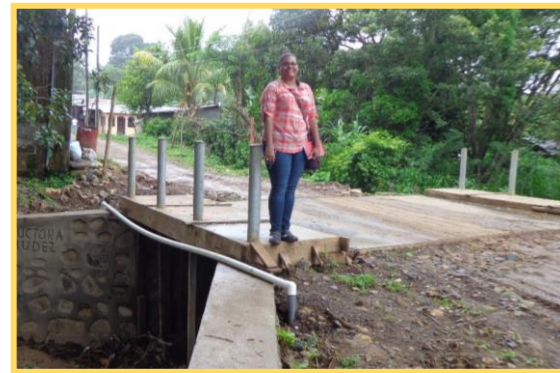
Foto Nº 29: Cajas Puente. “Drenaje Pluvial”
