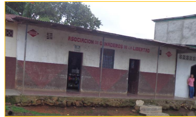
Foto N°41: Vivienda con Sist. Constructivo de Adobe. “Tipologías Constructivas” Equipo de trabajo Mendoza-Tijerino
