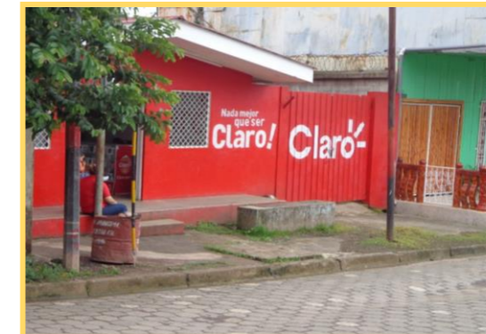
Foto N° 35: Instalaciones de Empresa de Telefonía Móvil y Fija Claro. “Telecomunicaciones” Equipo de Trabajo Mendoza - Tijerino.
