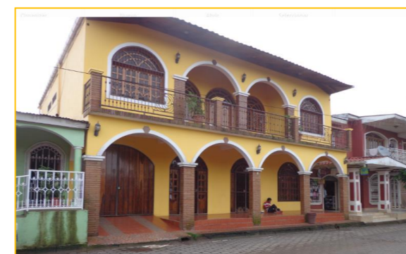
Foto N°38: Vivienda Mampostería. "Tipologías Constructivas" Equipo de trabajo Mendoza-Tijerino
