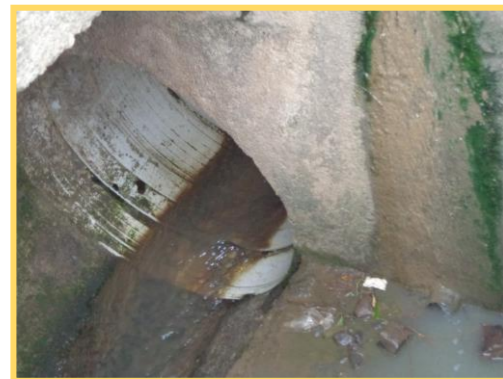
Foto Nº 30: Acueductos Instalados en la ciudad. “Drenaje Pluvial”
