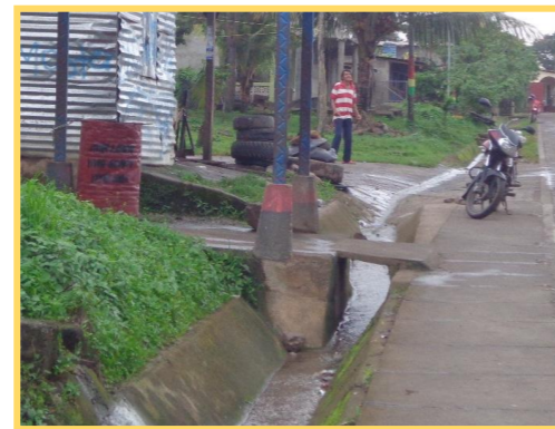
Foto Nº 31: Cunetas. “Drenaje Pluvial”
