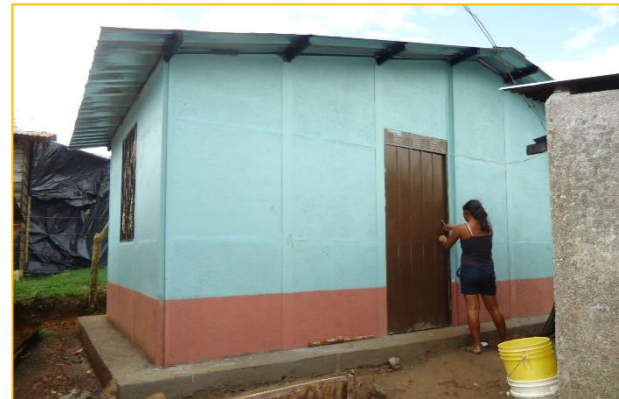
Foto N°40: Vivienda de Sistema Prefabricado. “Tipologías Constructivas” Equipo de trabajo Mendoza-Tijerino
