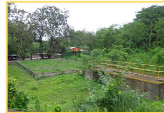
Foto N° 28: Sumidero Viviendas B2Gold “Alcantarillado Sanitario” Equipo de Trabajo Mendoza - Tijerino.
