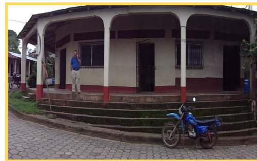
Foto N° 37: Centro de Informática. “Telecomunicaciones” Equipo de Trabajo Mendoza - Tijerino.
