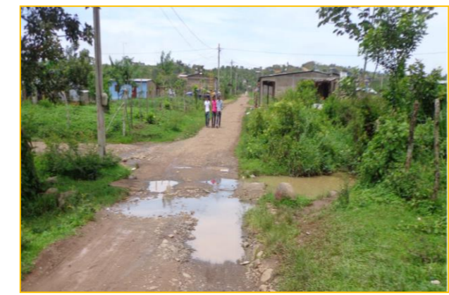
Foto N°49: Inundación por falta de drenaje Pluvial /B° Miguel Merel. “Déficit por Mala Ubicación” Equipo de trabajo Mendoza-Tijerino
