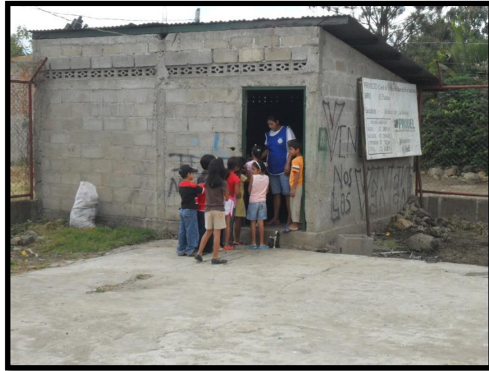
Fotografía 3 Cocina del centro comunitario.
