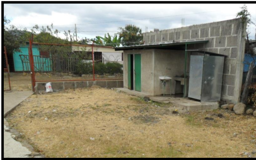
Fotografía 4 Baños del centro comunitario
