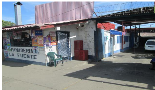
Figura A 9.27 Área de Venta Externa
