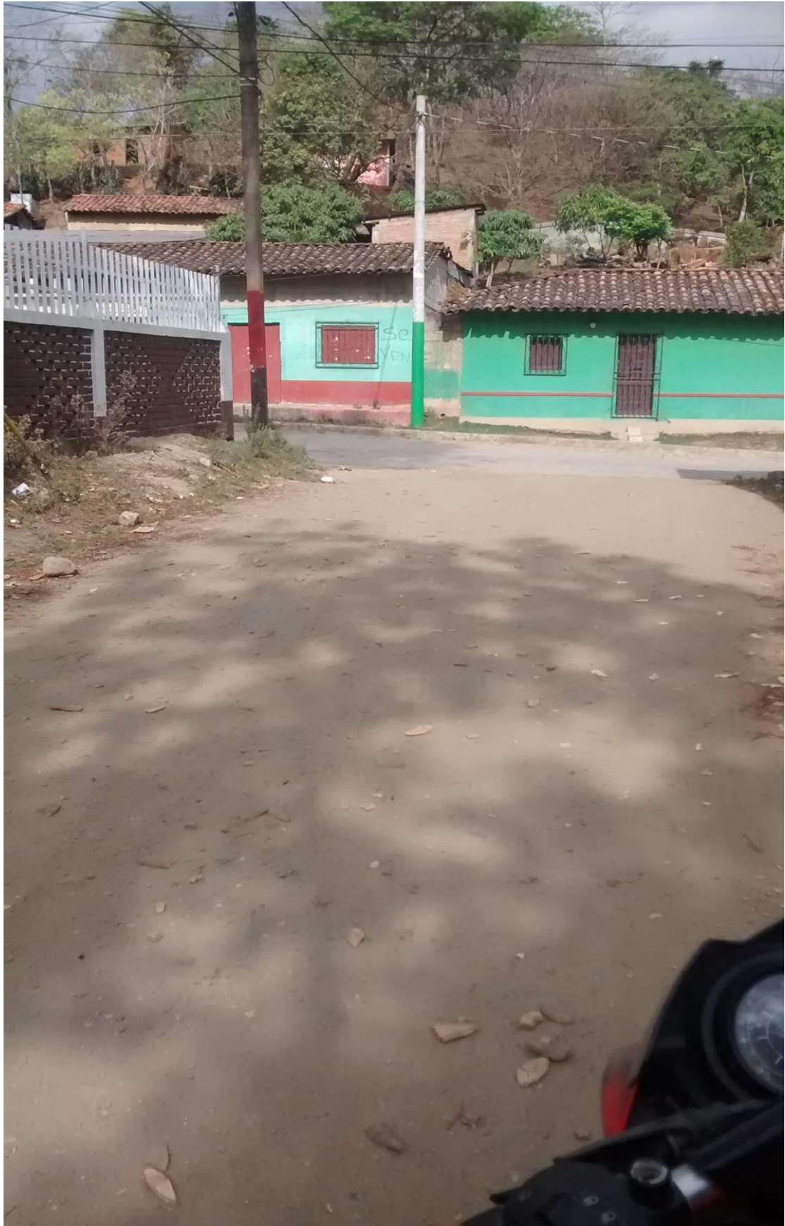
Anexo 2. Fotografía 2. Calle a adoquinar, casco urbano municipio de El Jícaro
