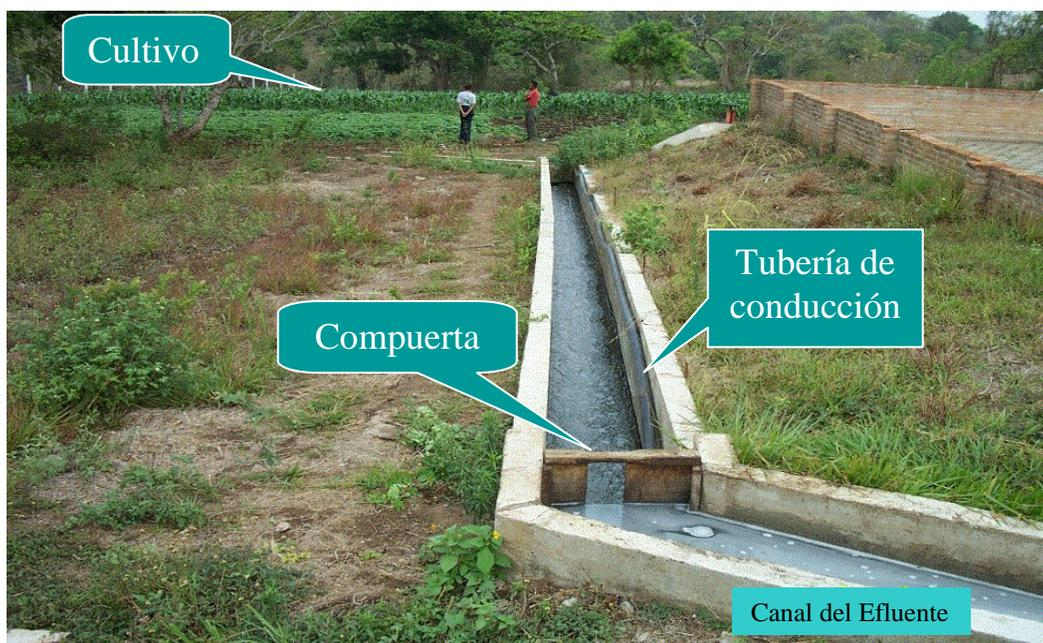
Figura 5. Estructura de retención y conducción del agua.
