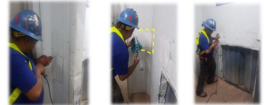
Imagen 6 Colocación de cañuelas y sellado de orificios en el Thermopanel
