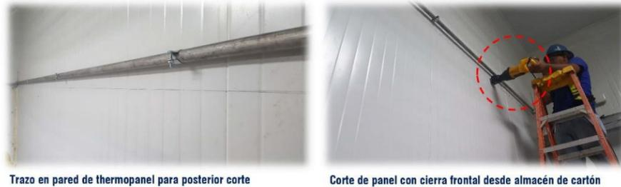
Trazo en pared de thermopanel para posterior corte
