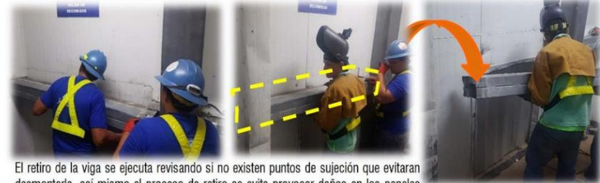
Imagen 4 Equipo de JLópez desmontando la viga galvanizada
