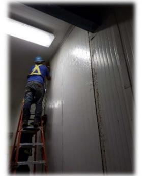
Imagen 51 Instalación de Thermopanel en el nuevo cuarto de tarimas
