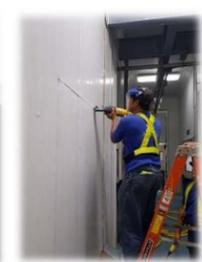
Imagen 60 Corte de Thermopanel
