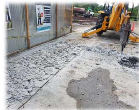
Imagen 1 Demolición de losa con retroexcavadora
