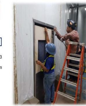
Imagen 64 Fijación de puerta con soldadura
