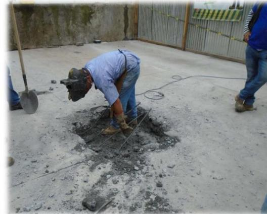
Imagen 4 Corte de acero de refuerzo
