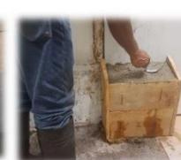
Imagen 57 Relleno de concreto de 3000 PSI
