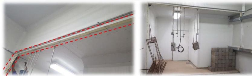
Fotografía de los thermopaneles desinstalados y se aprecia la diferencia de niveles de cielo
