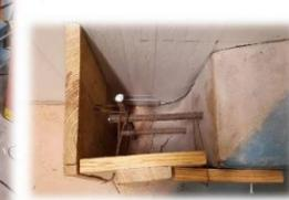
Imagen 56 colocación de varillas y formaletas
