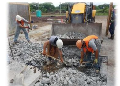
Imagen 8 Evacuación del material del área de demolición
