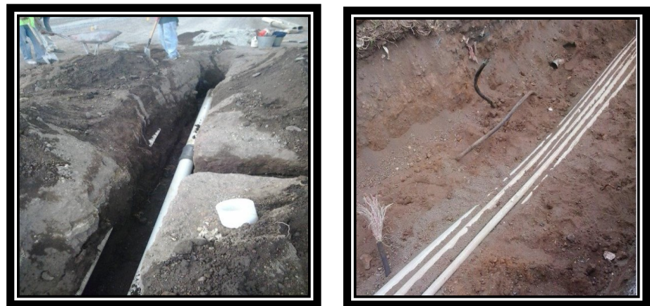
Fotografía 10. Excavaciones y reubicación de ductos (canalizados). Elaboración propia 2017.
