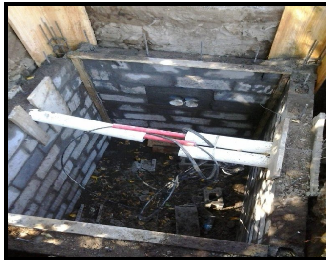
Imagen 4. Instalación de ductos.
