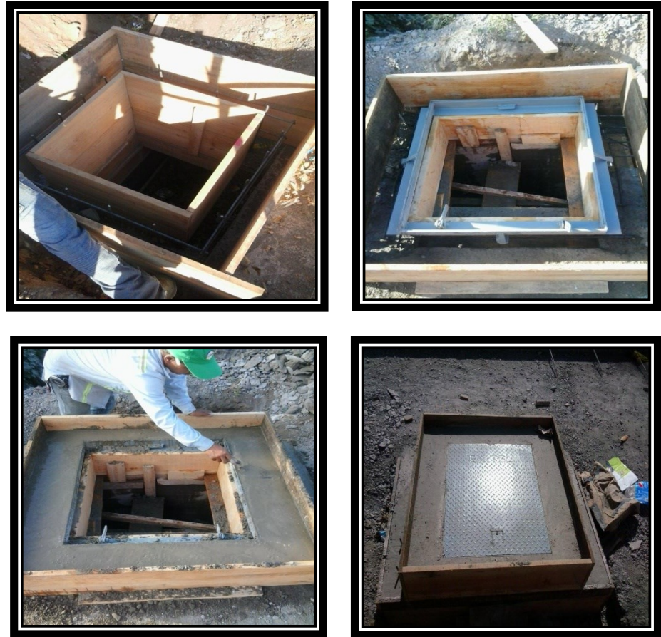
Fotografía 9. Construcción de un pozo tipo IV. Elaboración propia 2017.
