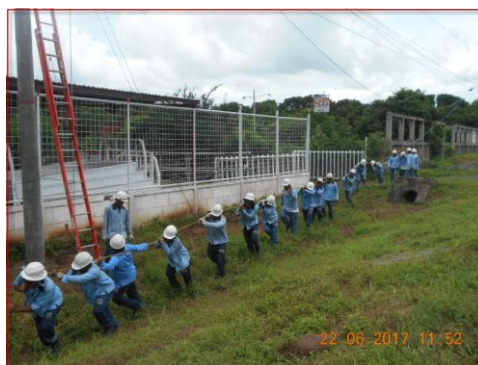
Imagen 3.2-Personal halando conductor
