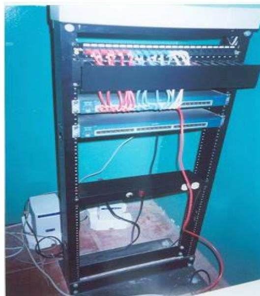
Figura #14 muestra el Rack del la Red LAN comunica el nodo del hospital, ubicado en La oficina de Informática, con capacidad de 72 puertos y le es adaptable otros Swicht.
