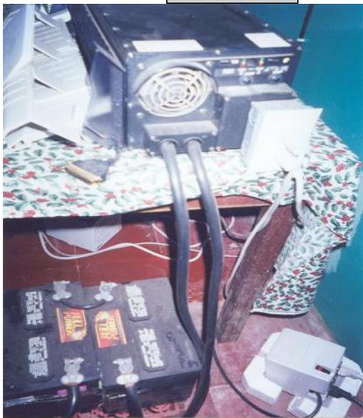
Figura #13; 1 Inversor, 2 Acumuladores de Energía, con Capacidad de 5 horas para trabajar sin energía eléctrica, Ubicado en la Oficina de Informática del Hospital Asunción.
