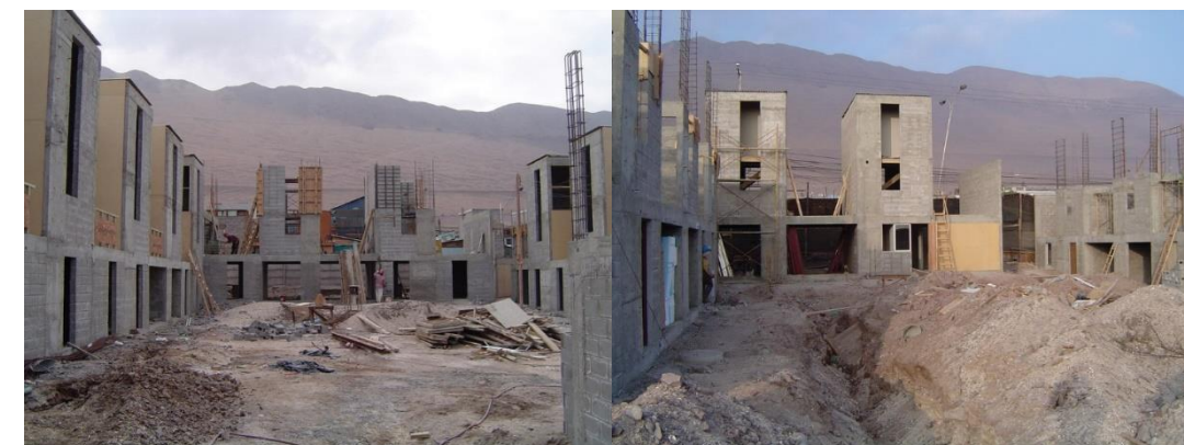
Imagen N°90. Fotografías durante el proceso de construcción de las viviendas.
