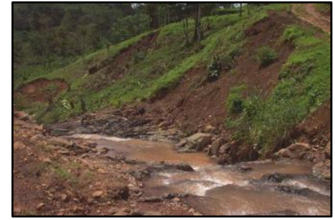
Imagen N°16. Un deslizamiento obstruye el curso natural de los ríos. La socavación del pie de la ladera por erosión fluvial puede provocar inundaciones y avenidas. Fuente: Deslizamientos en Nicaragua_Ing. Tupak Obando
