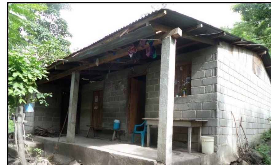
Imagen N°91. Fotografía de prototipo de vivienda durante la ejecución del proyecto respuesta ante deslizamientos
