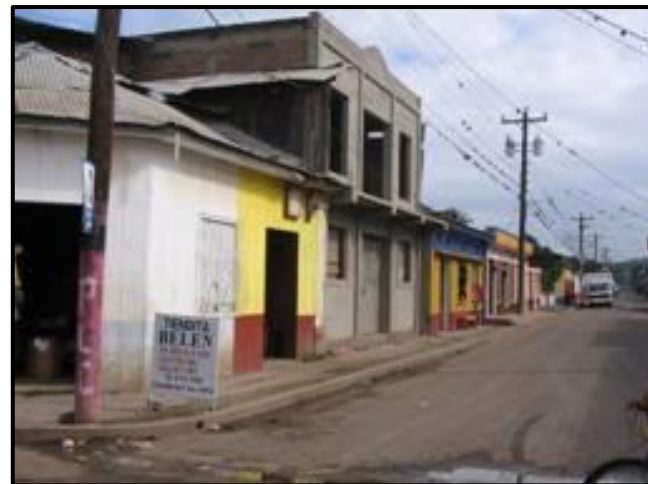
Imagen N°49. Edificio para uso comercial en construcción. Fuente: Diagnostico municipal de Condega.
