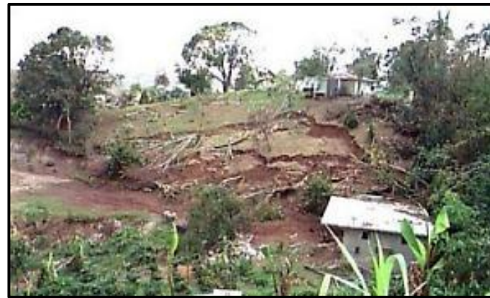
Imagen N°27. Deslizamiento de tierra
