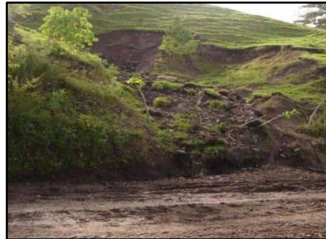
Imagen N°18. Deslizamiento rotacional con corona irregular en su escarpe principal en Bigabual. Jinotega, Octubre- 2005. Fuente: Deslizamientos en Nicaragua_Ing. Tupak Obando
