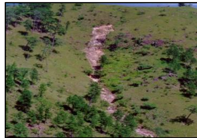
Imagen N°19. Flujos de Detritos Lapan (Puerto Cabezas) Fuente: Deslizamientos en Nicaragua_Ing. Tupak Obando
