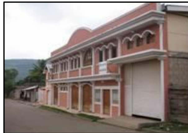
Imagen N°45. Purera Ubicada dentro de la ciudad. Fuente: Diagnostico municipal de Condega.
