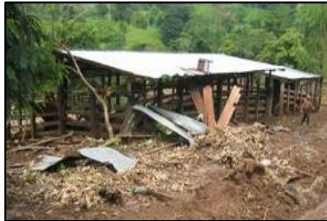
Imagen N°23. Casa afectada por deslizamiento en el Cerro Musún. Fuente: http://webserver2.ineter.gob.ni/boletin/2004/06/cerro-musun0406.htm
