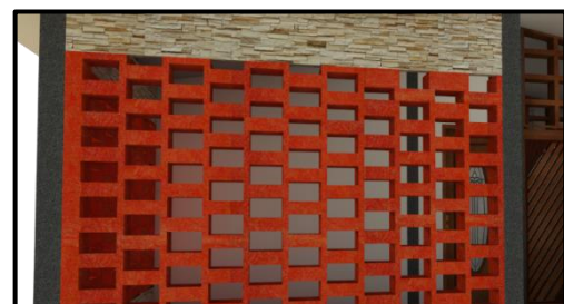
Imagen N°128. Entramado de ladrillo en área de sala en porche
