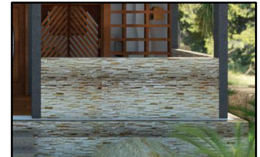
Imagen N°129. Sobrecimiento enchapado con piedra laja.
