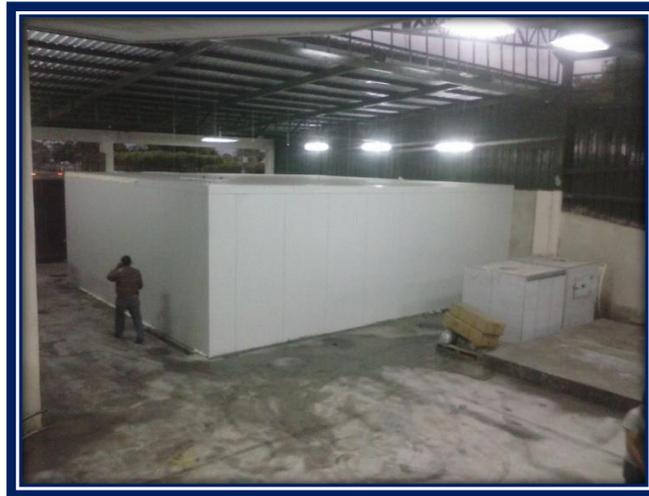
Ilustración 21: Paredes Thermopanel Tipo Sándwich de Cuarto Frio
