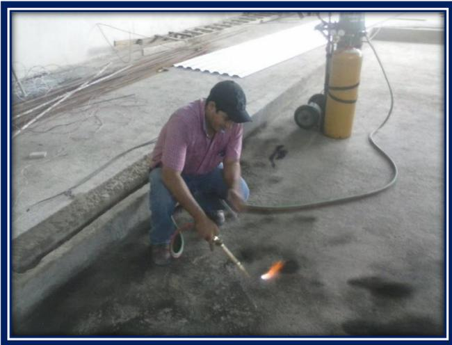
Ilustración 20: Secado de Losa Con acetileno Para Cuarto Frio
