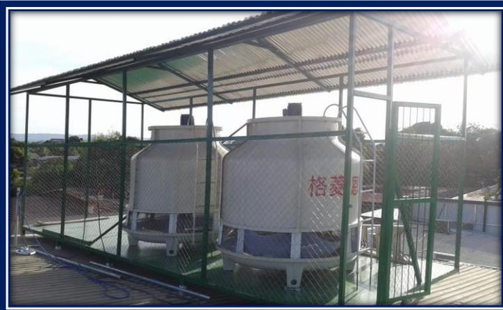
Ilustración 17: Tanques de Enfriamiento con cerramiento de malla ciclón
