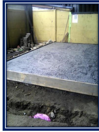
Ilustración 8: fundido de tapa para fosa
