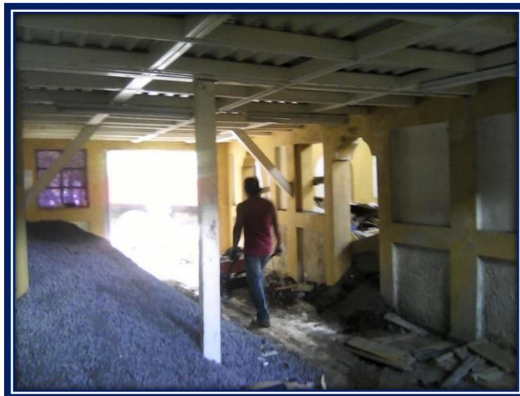
Ilustración 2: Desinstalación de puertas y ventanas
