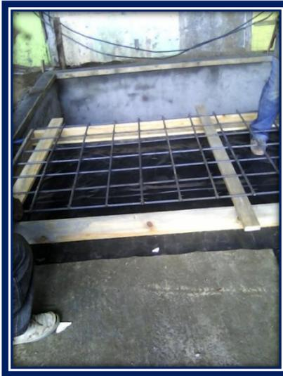
Ilustración 7: Armado de malla para tapa de concreto en fosa
