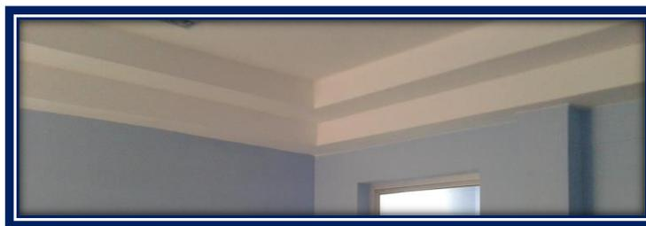
Ilustración 10: Cielo Tipo Gradad en Recepción
