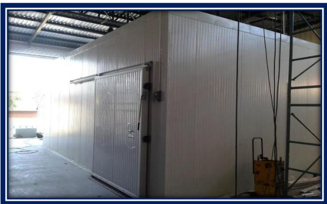
Ilustración 22: Instalación de puerta en cuarto Frio
