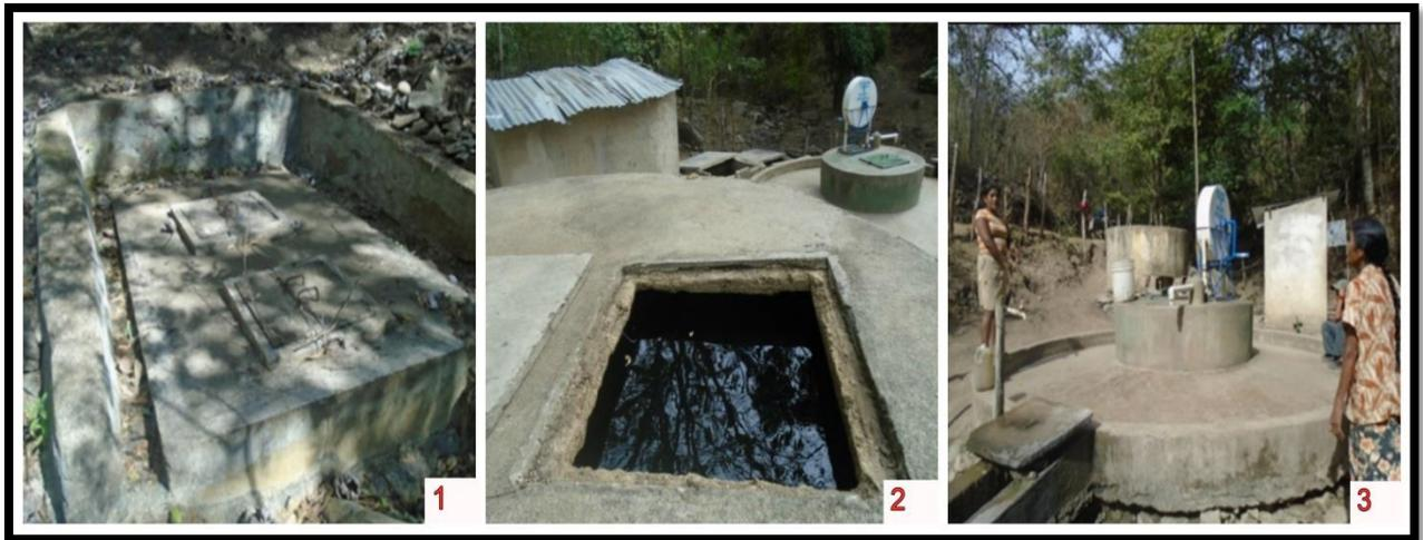
Figura 3. Se muestran los diferentes puntos monitoreados en la comunidad El Cacao. 1. Pila de captación, 2. Tanque de almacenamiento, 3. Llave de chorro.
