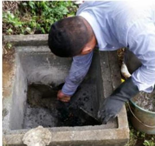
*C.2. Trabajo de elaboración de ranura en piso de caja de registro para poder engavetar el palin metálico que fue usado como compuerta de cierre*
