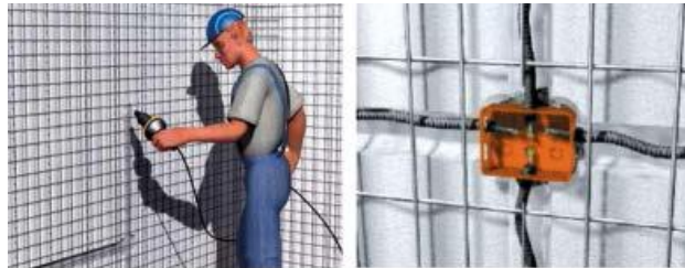
Figura No.1.19. Contracción con fuego del poliestireno para canalización
