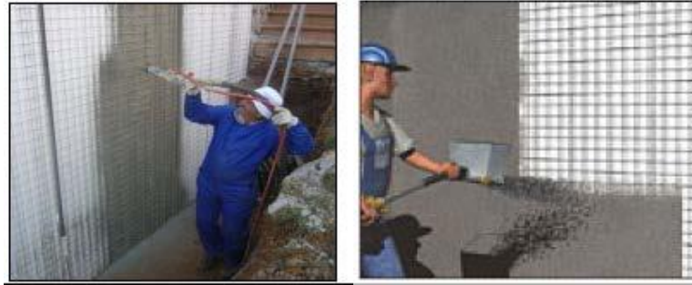
Figura No.1.21. Proceso de revoque de paneles EMMEDUE
