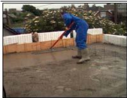
Figura No.1.22. Proceso de colado de capa superior losas estructurales paneles EMMEDUE.
