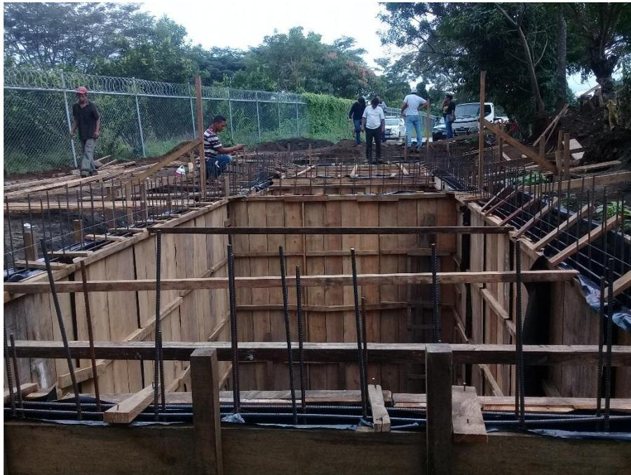
Foto N° 8. Construcción de pilas sépticas.
