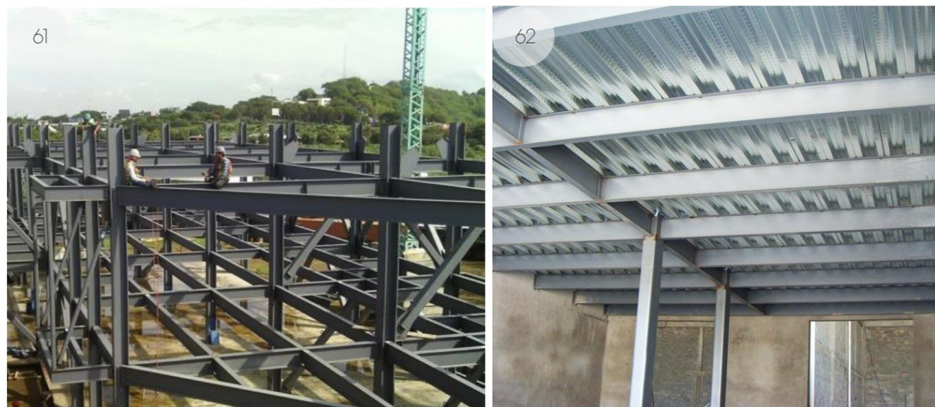
Fotografía 61. Estructura metálica Edificio 01, Universidad Nacional de Ingeniería, Managua, Nicaragua. Fuente: <http://www.inmsaargo.com>
