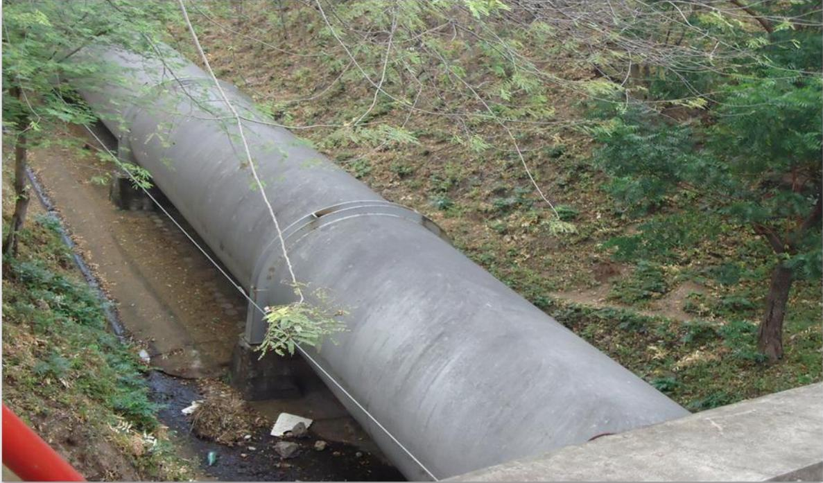
**Fotografía 7:** Tubería de aducción de la planta Carlos Fonseca.
