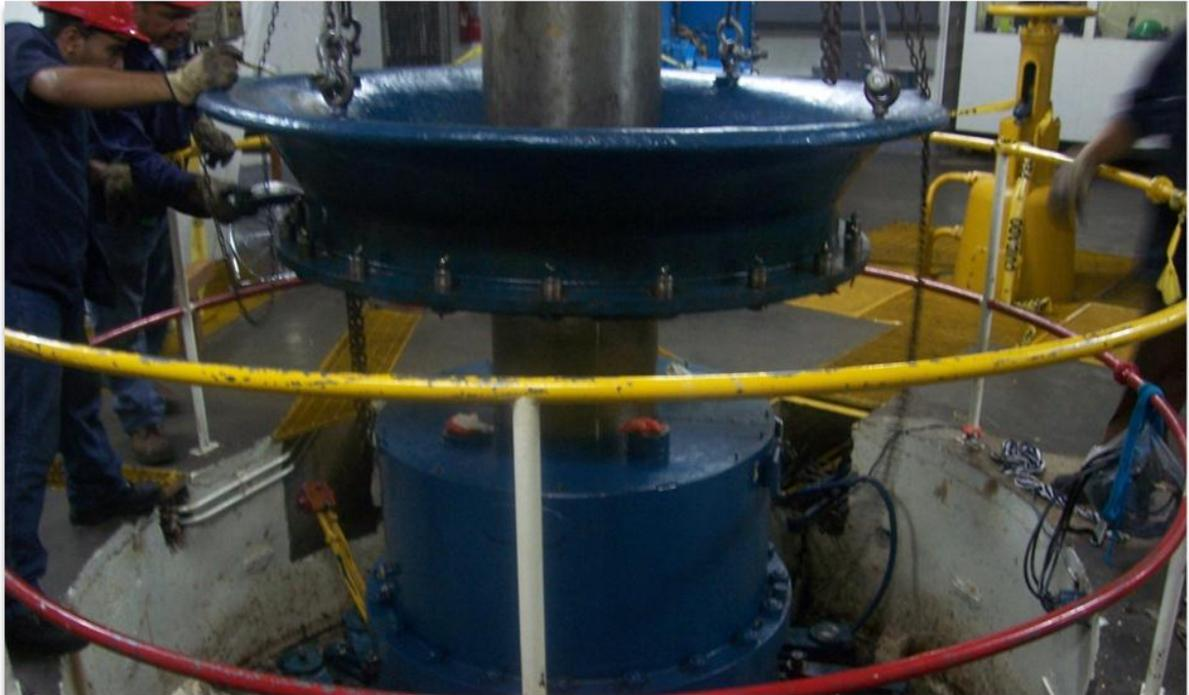
**Fotografía 9:** personal de la planta Centroamérica Desmontando el eje de una de las turbinas realizar el debido mantenimiento.
