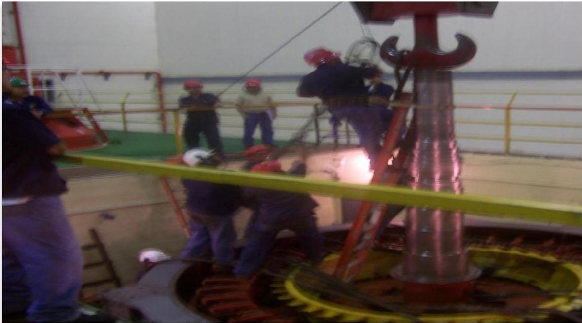
**Fotografía 8:** Personal de la planta Centroamérica desmontando una de las turbinas para realizar mantenimiento.
