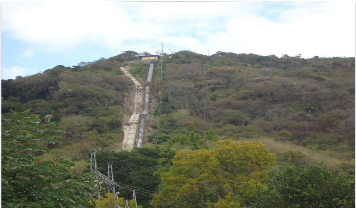
**Fotografía 6:** Tubería forzada de la planta Centroamérica.
