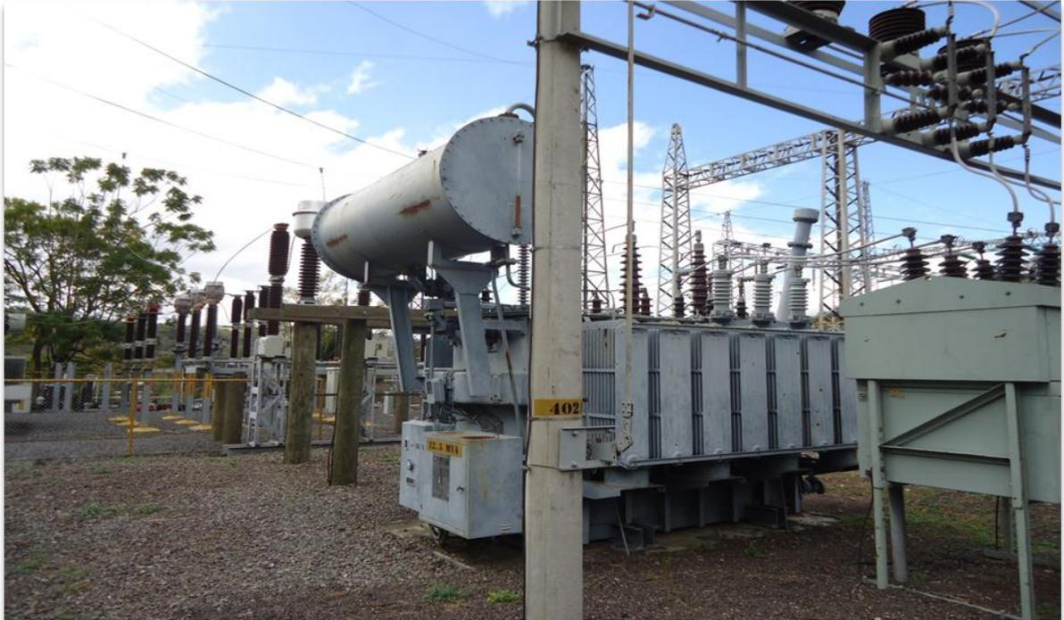
**Fotografía 5:** Transformador de potencia de la subestación de la planta Centroamérica.
