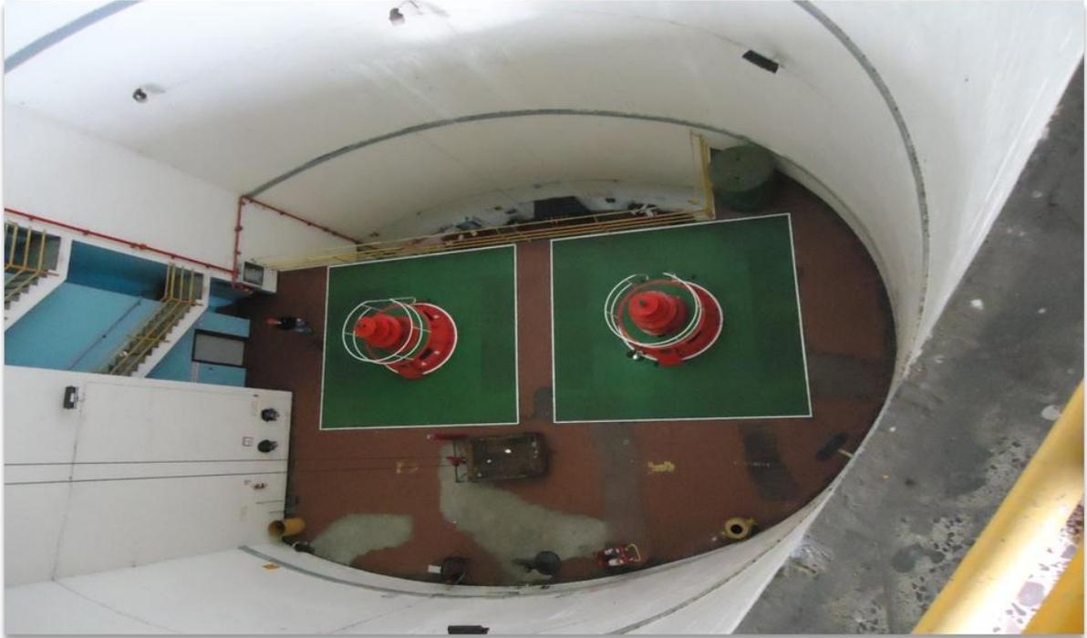
Fotografía 1: Turbinas tipo Francis de la planta Centroamérica en casa de máquinas.
