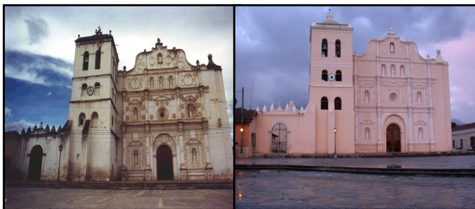
Imagen N°6: El antes y el después de la rehabilitación de la Catedral de Comayagua 15
