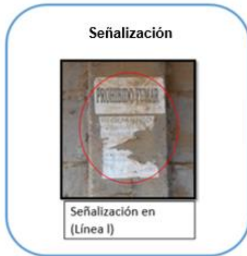
Ilustración 29. Señalización, Corte y Alistado
