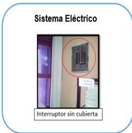
Ilustración 8. Sistema eléctrico Administración
