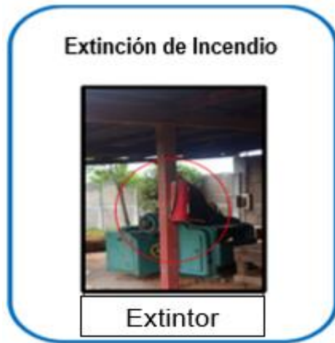
Ilustración 23. Extinción de Incendio, Aserrío
