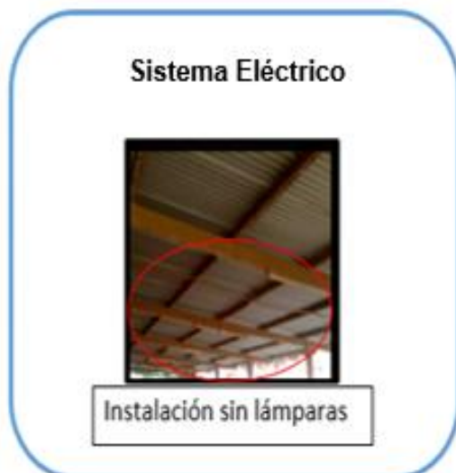
Ilustración 30. Sistema Eléctrico, Armado
