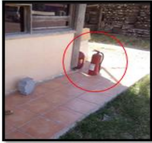
Extintor en el piso
