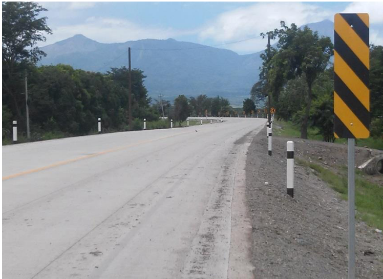
Figura 13. Camino Mejorado sin Baches.
