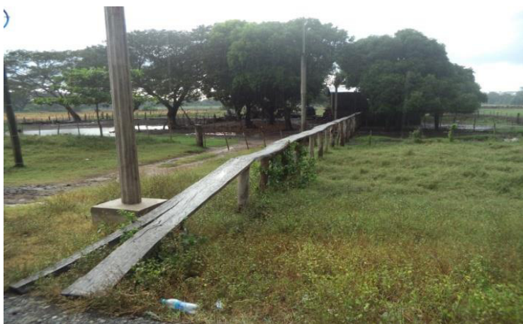
Figura 12. Extensos y precarios puentes entre el borde de la carretera y las viviendas.
