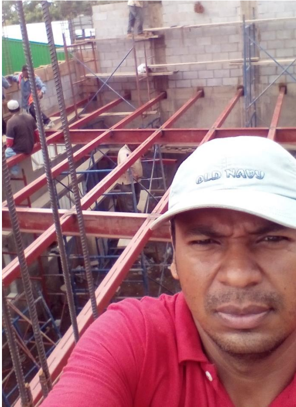
Ilustración 47 Instalando Estructura Metálica de Entrepiso, tomada en campo
