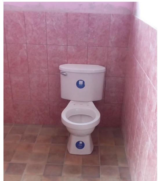
Ilustración 81 Instalación de Inodoro, tomada en campo
