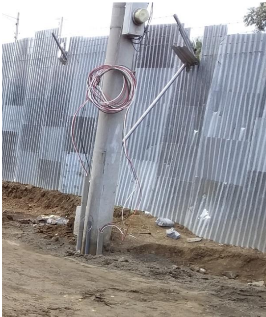
Ilustración 89 Instalación de Acometida, tomada en campo
