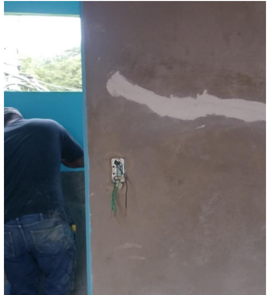
Ilustración 86 Alambrado de Apagadores y Tomacorrientes, tomada en campo
