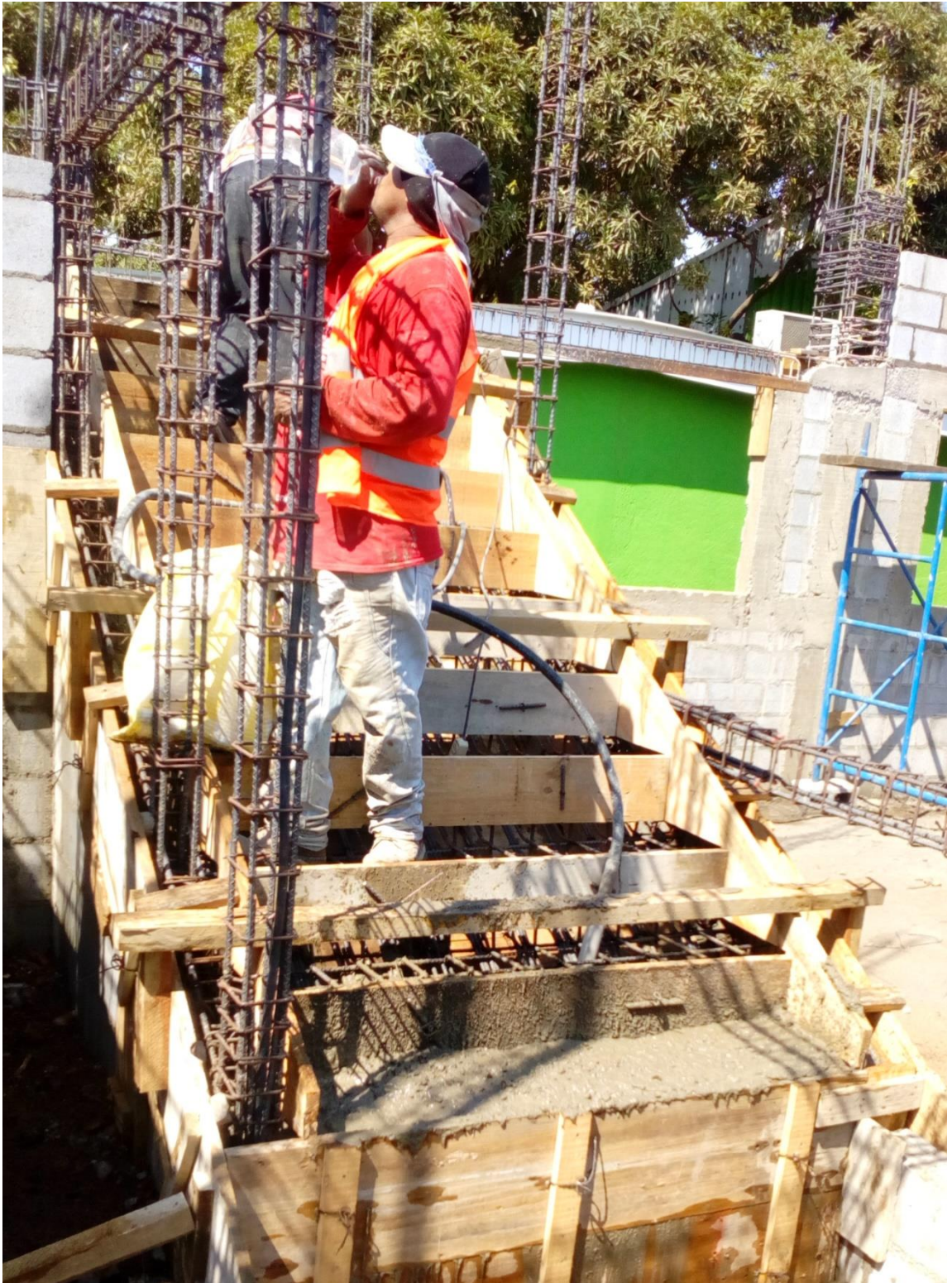
Ilustración 44 Proceso de Colado de Concreto en Escalera del Primer Tramo, tomada en campo
