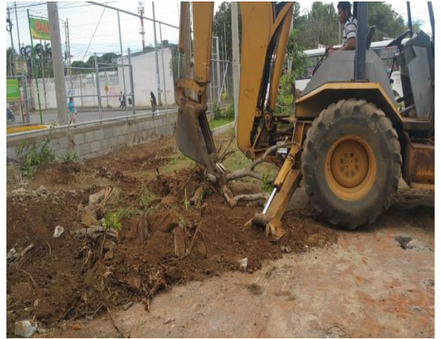
Ilustración 27 Descapote con Ayuda de Retro Escavadora, tomada en campo
