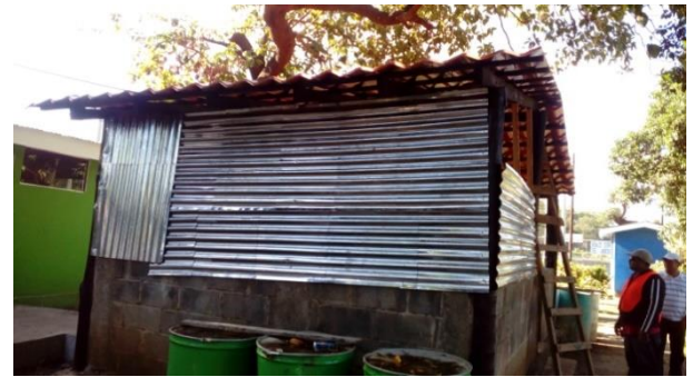
Ilustración 24 Cerramiento de Bodega, tomada en campo
