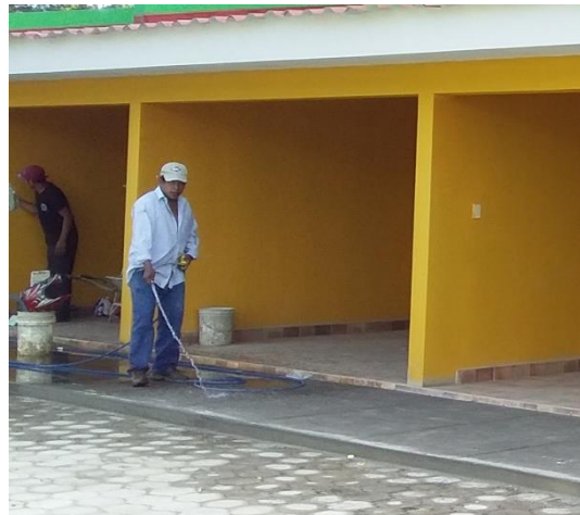
Ilustración 101 Curado de Andén, tomada en campo
