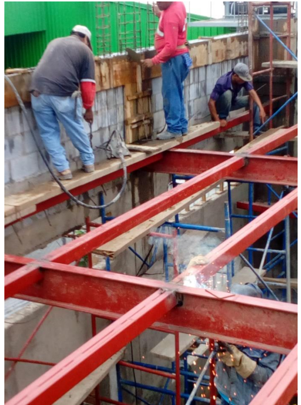
Ilustración 46 Instalando Estructura Metálica de Entrepiso, tomada en campo
