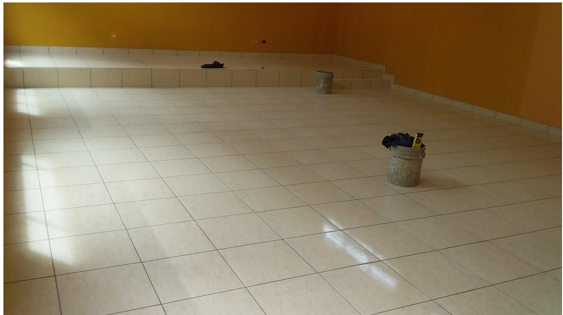
Ilustración 63 Cerámica de Auditorio, este Mismo Tipo se Instaló en Oficinas y Sala de Reunión, tomada en campo
