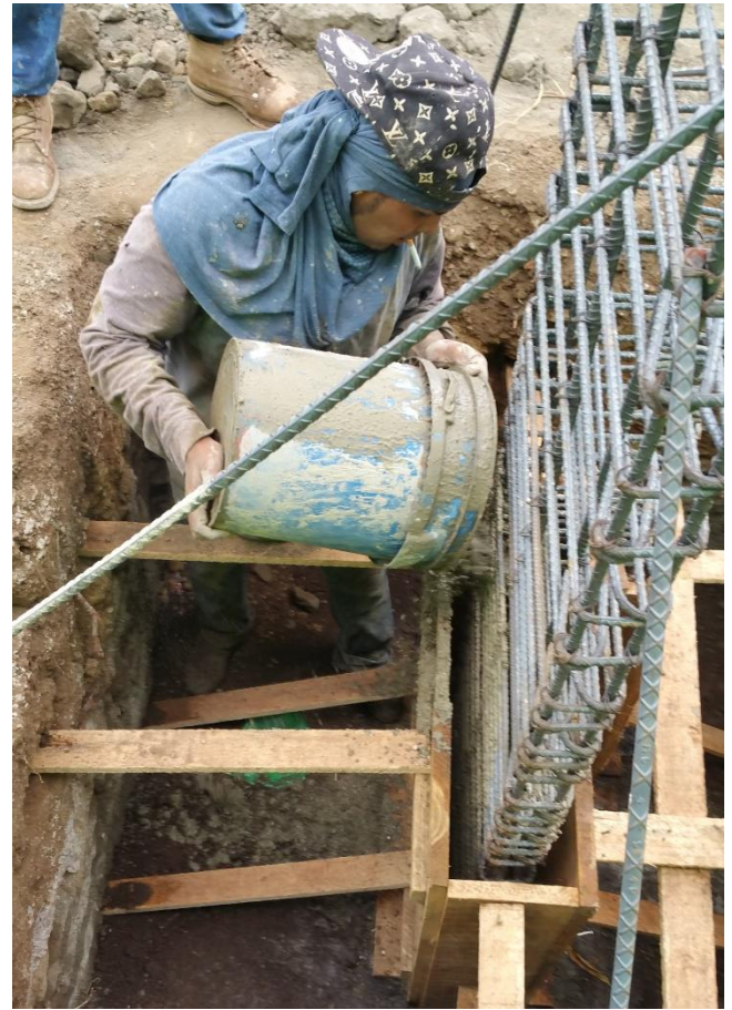
Ilustración 37 Colado de Pedestales P-1, tomada en campo
