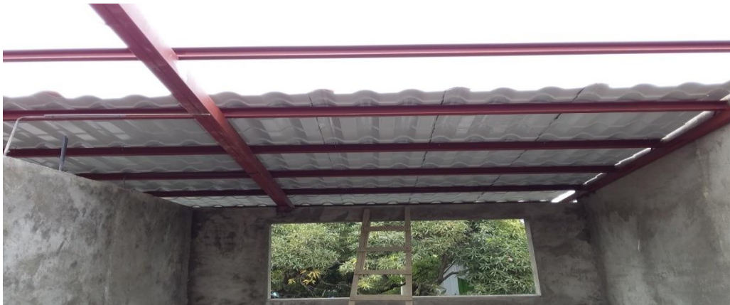
Ilustración 51 Estructura y Cubierta de Techo del Segundo Piso, tomada en campo
