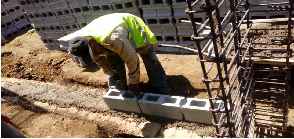
Ilustración 55 Inicio de Pegado de Bloque en Eje A. Tomada en campo
