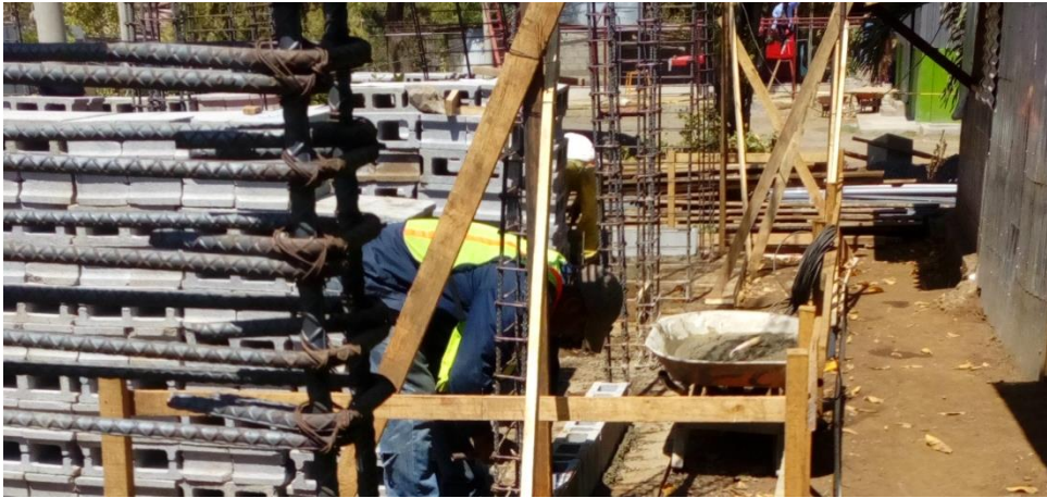
Ilustración 39 Inicio de Pegado de Bloque en Eje A, tomada en campo
