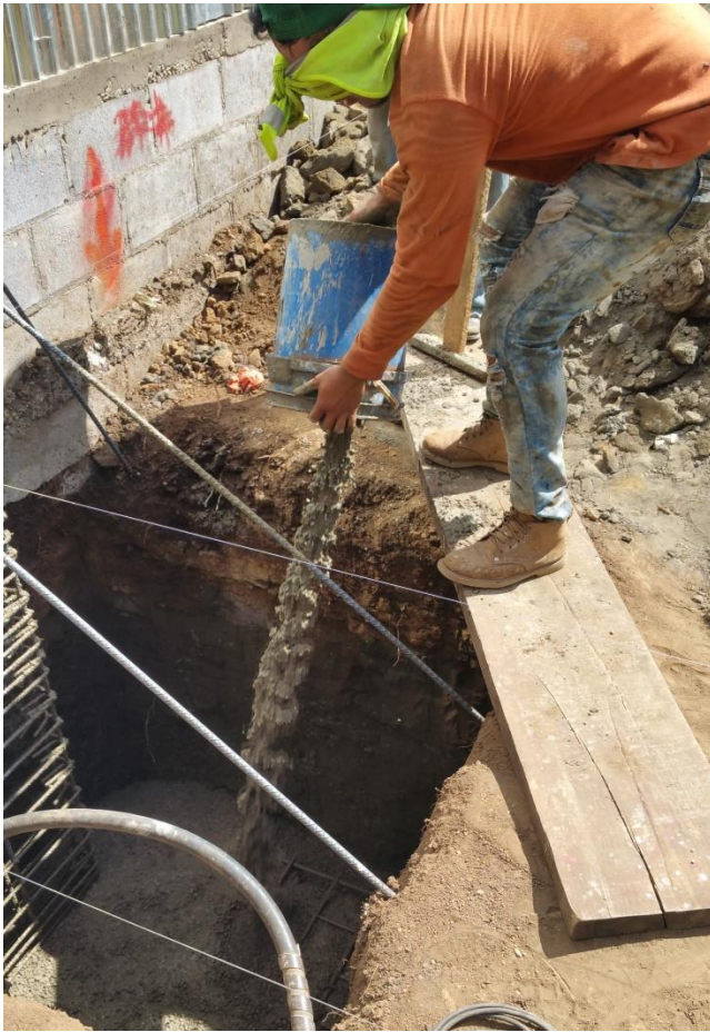
Ilustración 38 Colado de Zapata Z-1, tomada en campo
