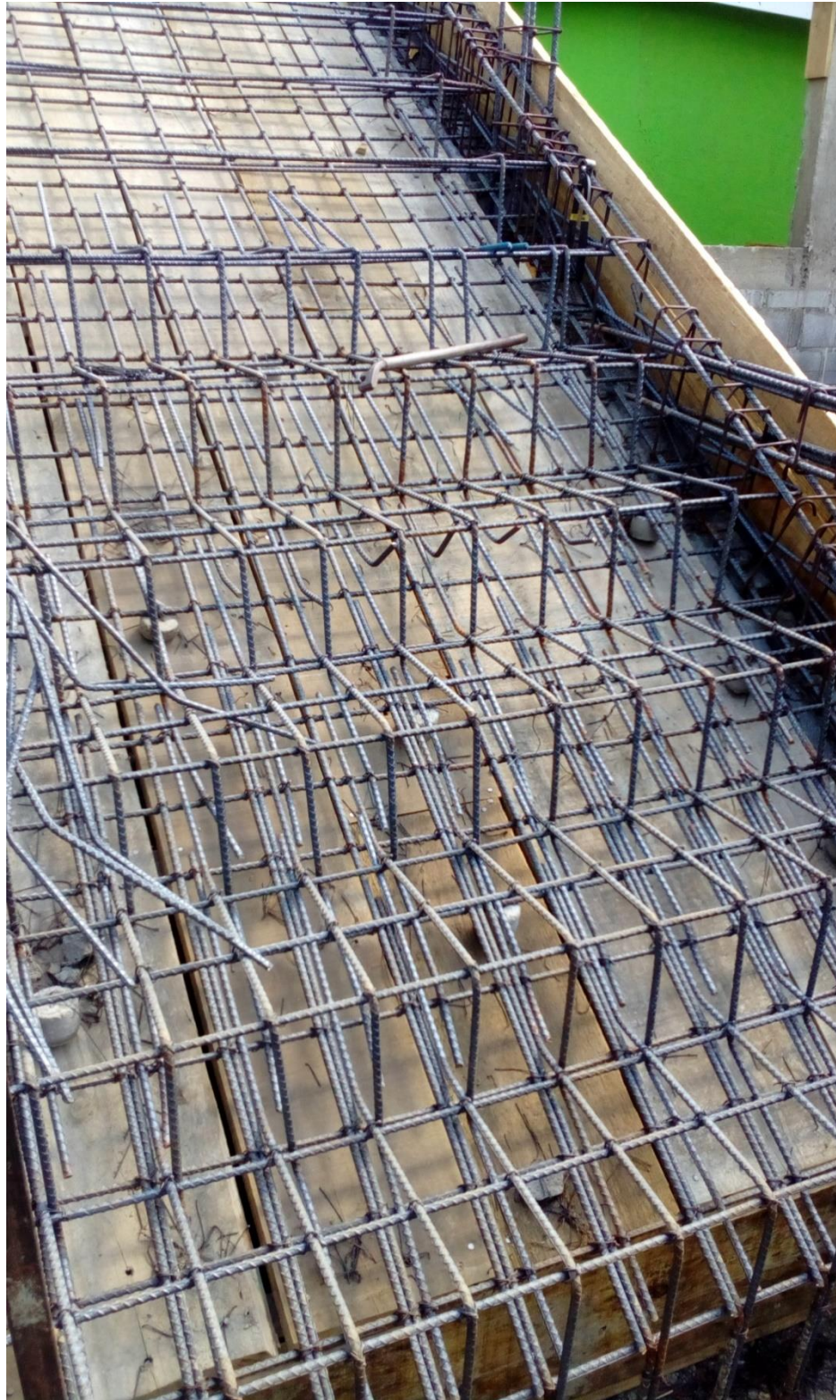
Ilustración 43 Acero de Escalera Primer Tramo, tomada en campo
