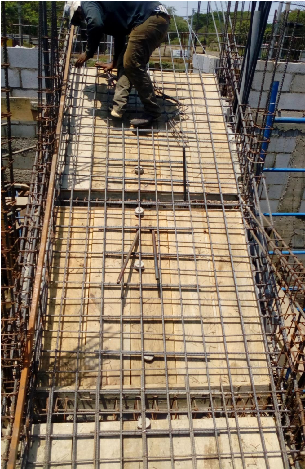
Ilustración 45 Acero de Escalera en Segundo Tramo, tomada en campo
