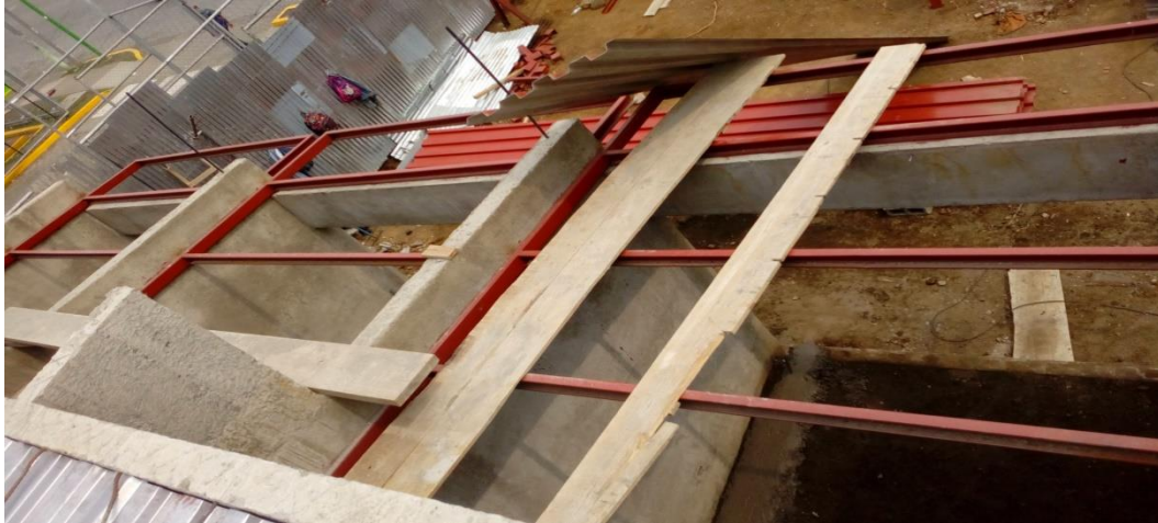
Ilustración 49 Estructura de Techo de Módulos Primer Planta, tomada en campo
