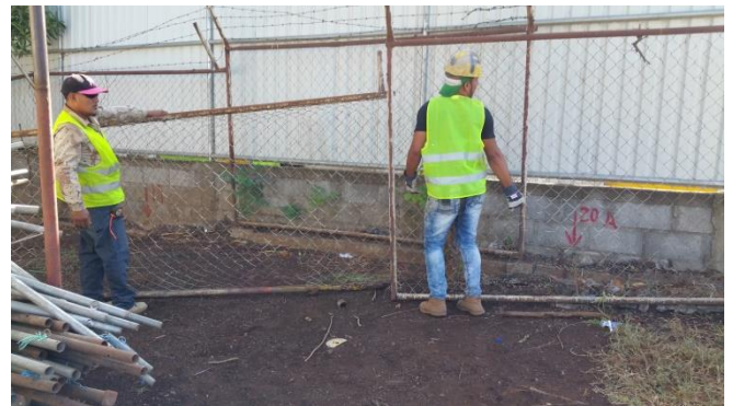
Ilustración 21 Desinstalación de Malla Perimetral, tomada en campo
