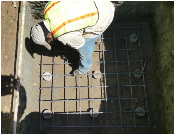
Ilustración 33 Colocación de Acero de Zapatas Z-1, tomada en el campo
