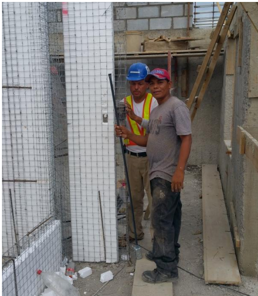
Ilustración 85 Canalización de Apagadores y Tomacorrientes en Paredes de Covintec, tomada en campo
