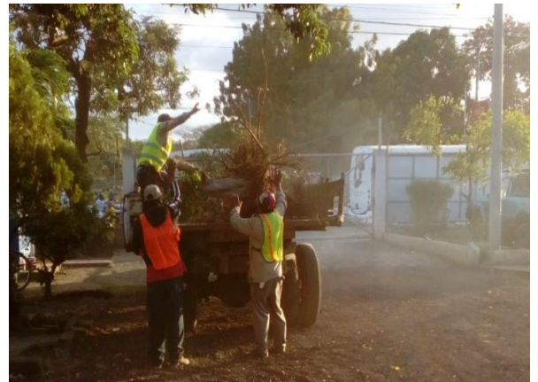
Ilustración 23 Desalojo de Escombros y Basura, tomada en campo
