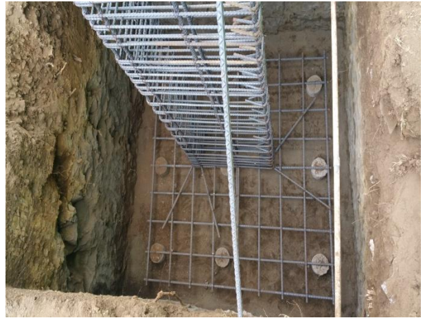
Ilustración 32 Colocación de Acero de Columnas C-5, tomada en el campo
