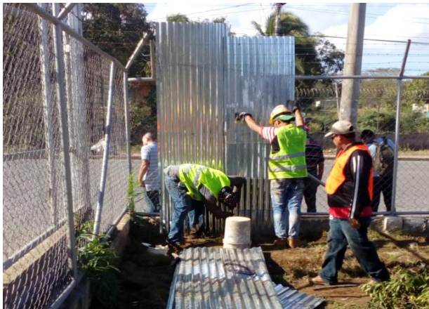
Ilustración 25 Cerramiento de Perímetro de Construcción, tomada en campo
