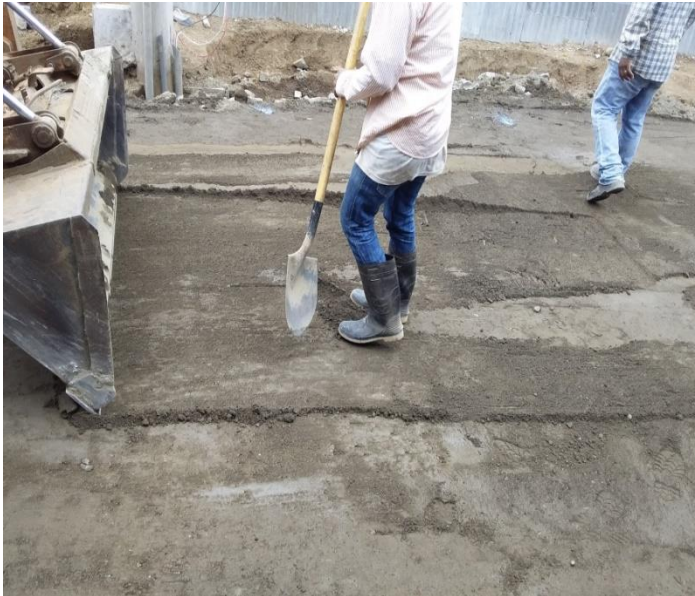
Ilustración 29 Relleno y Conformación con Ayuda de Mini Cargador, tomada en campo
