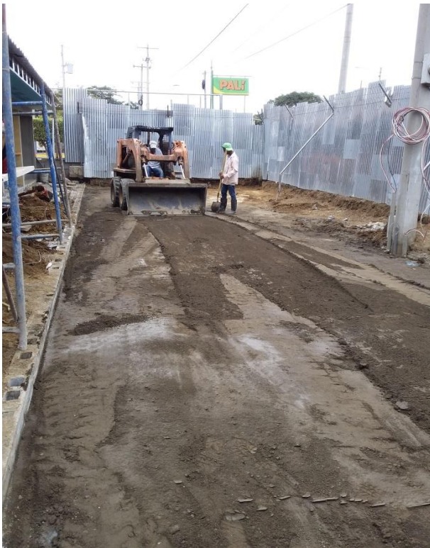
Ilustración 30 Relleno y Conformación, tomada en campo
