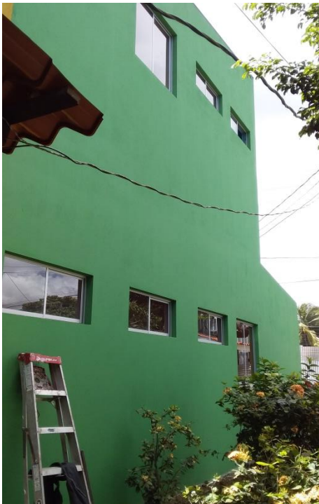
Ilustración 92 Fachada Oeste, tomada en campo
