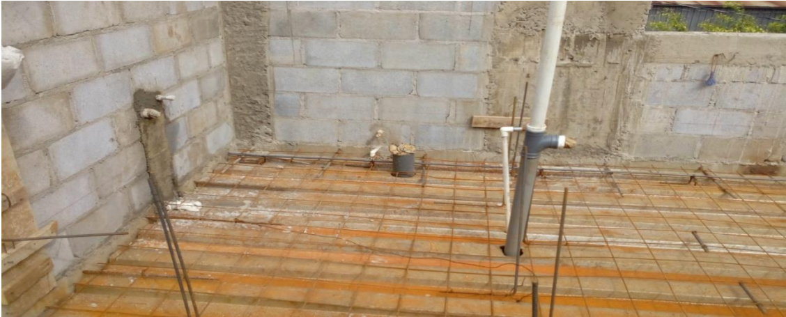
Ilustración 77 Instalación de Esperas de Agua Potable y Drenajes de Aguas Negras, tomada en campo
