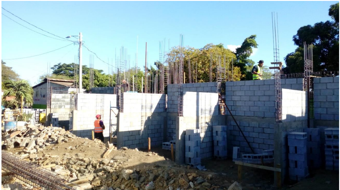
Ilustración 57 Pegado de Bloque en área de módulos en Ejes 1, 3, 7, 9, 11, 12. Tomada en campo
