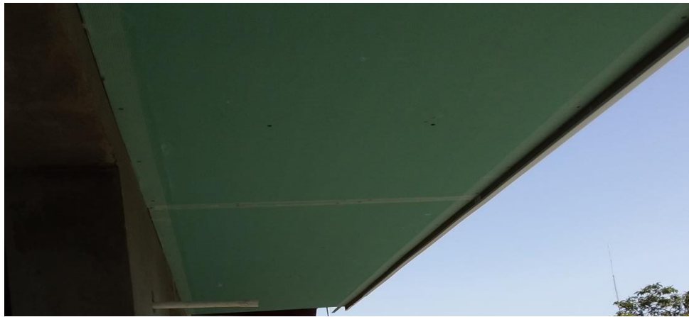
Ilustración 52 Alero y Fascia parte Trasera, tomada en campo
