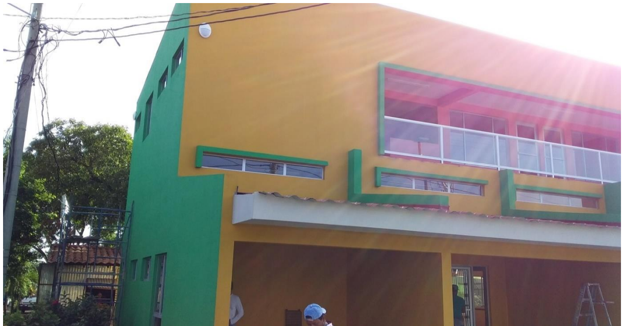
Ilustración 71 Ventanas de Aluminio y Vidrio Fijo (tragaluz para primer piso), y Barandal de Pasillo de 2do Piso, tomada en campo
