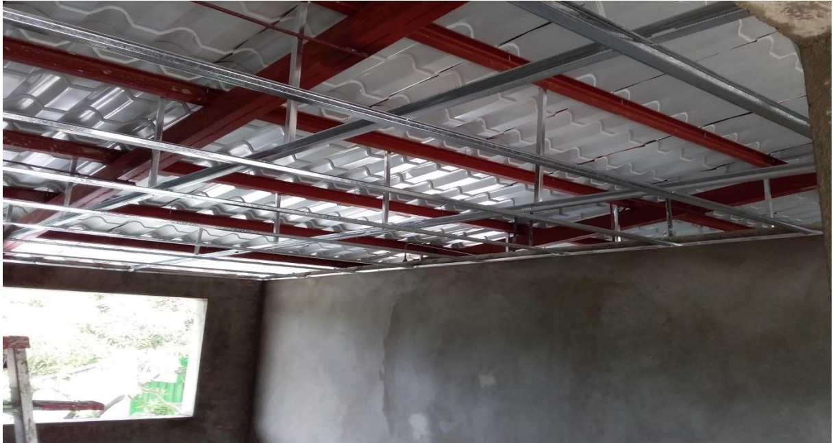
Ilustración 68 Estructura de Cielo Raso, tomada en campo
