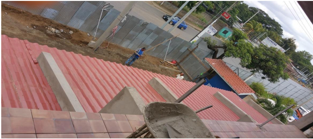
Ilustración 50 Cubierta de Techo de Módulos Primer Planta, tomada en campo
