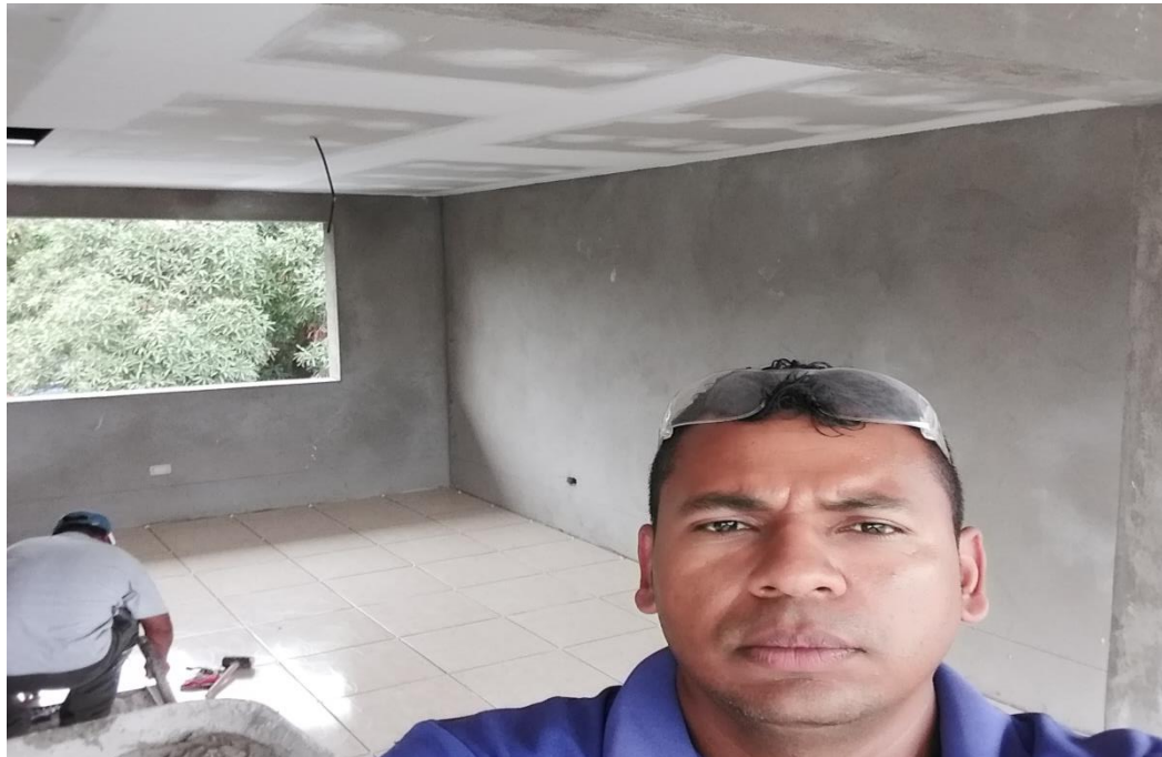
Ilustración 69 Cielo Raso Acabado y Pegado de Cerámica en Oficinas, 2do Piso, tomada en campo
