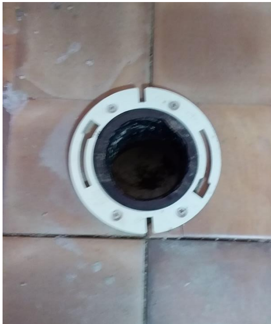
Ilustración 82 Instalación de Flange Para Instalar Inodoro, tomada en campo
