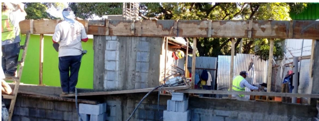
Ilustración 41 Colado de Concreto en Viga Dintel de Eje A, tomada en campo
