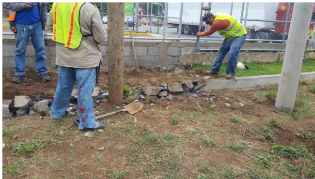
Ilustración 22 Demolición de Muro de Jardinera, tomada en campo
