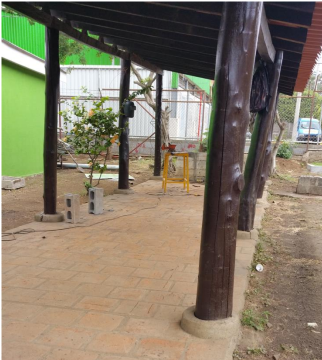
Ilustración 19 Edificación a Demoler, tomada en campo
