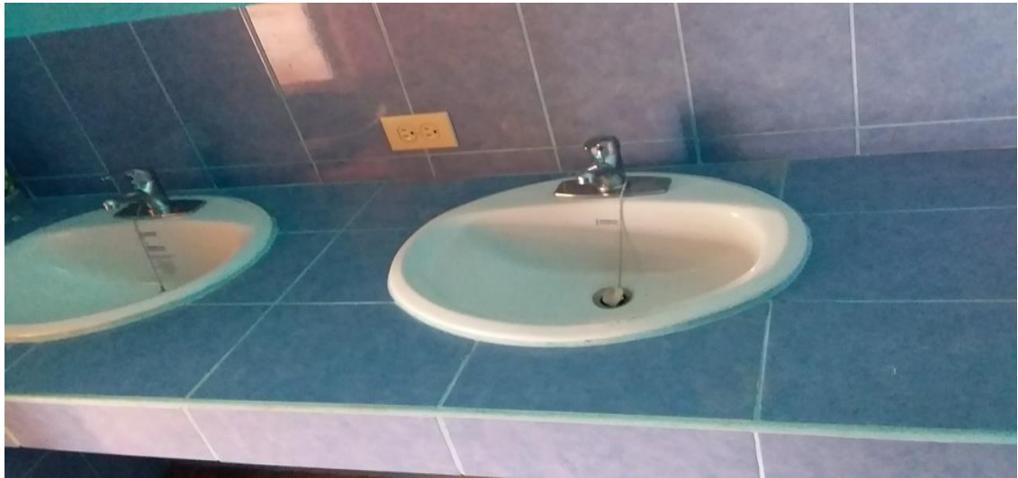
Ilustración 80 Instalación de Lavamanos, tomada en campo
