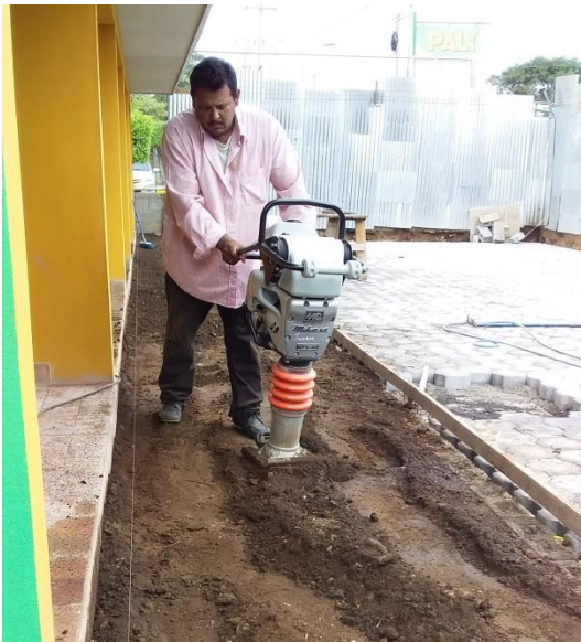
Ilustración 102 Relleno y Compactación para Fundir Cascote de Andén, tomada en campo
