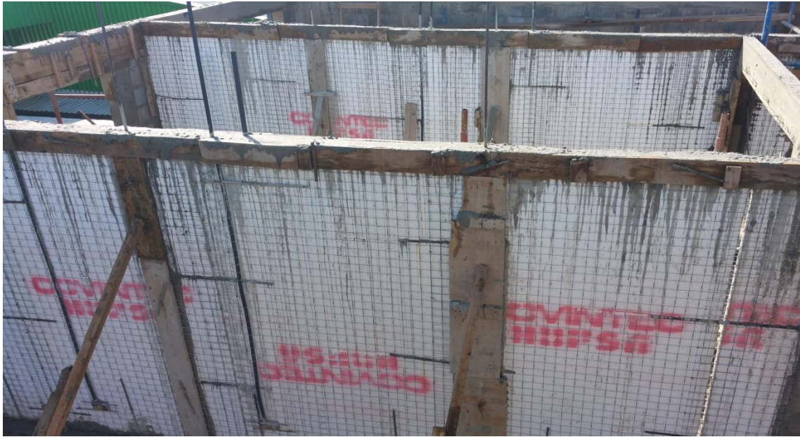
Ilustración 58 Paredes de COVINTEC, Reforzadas con Llenas de Concreto en Dos Celdas Asemejando Vigas y Columnas, tomada en campo
