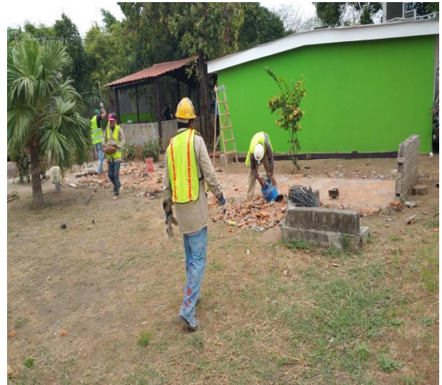
Ilustración 20 Retirando Escombros y Cascote Existente, tomada en campo
