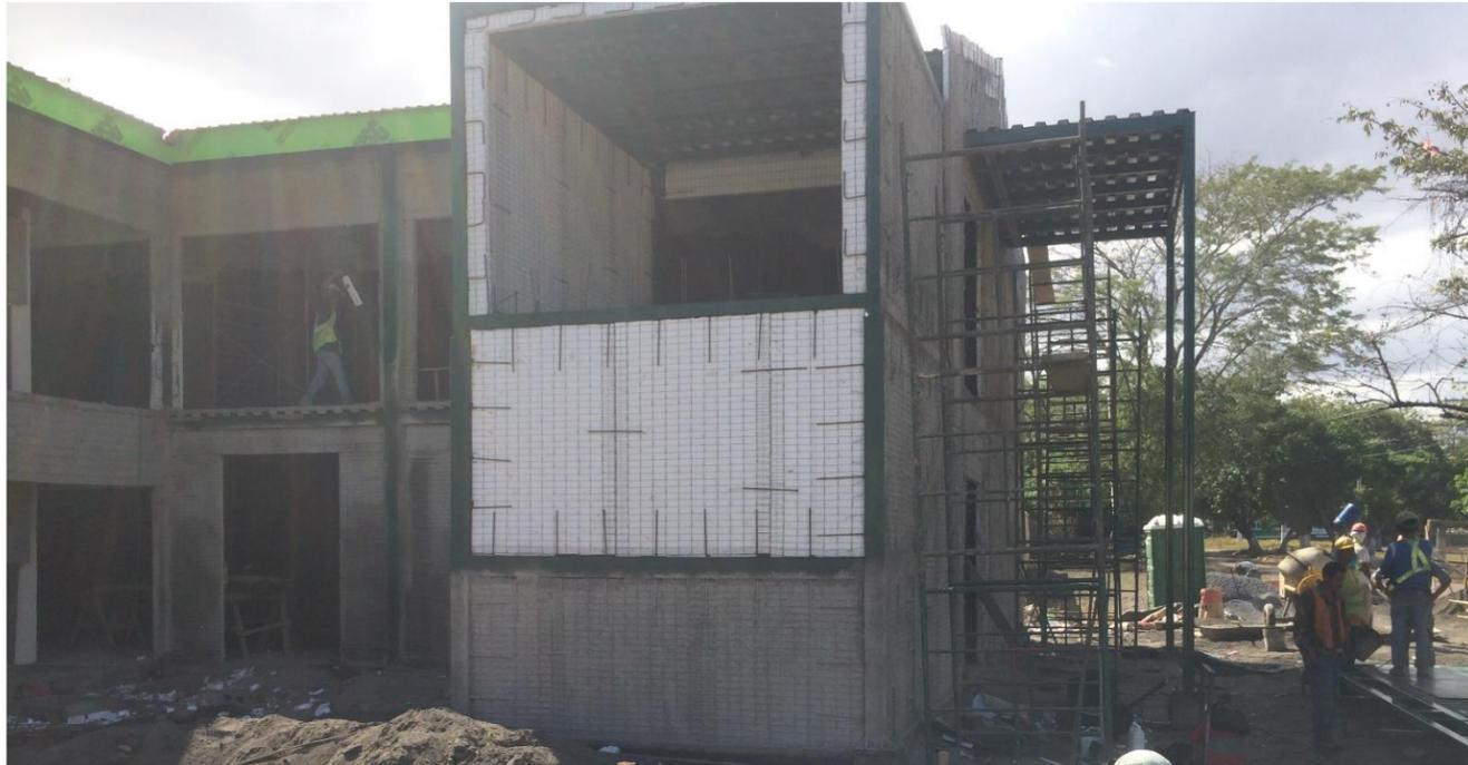
**IMAGEN No. 184** Paredes de covintec. Perspectiva lateral izquierda con paredes chilateadas. Fuente: Autor.
