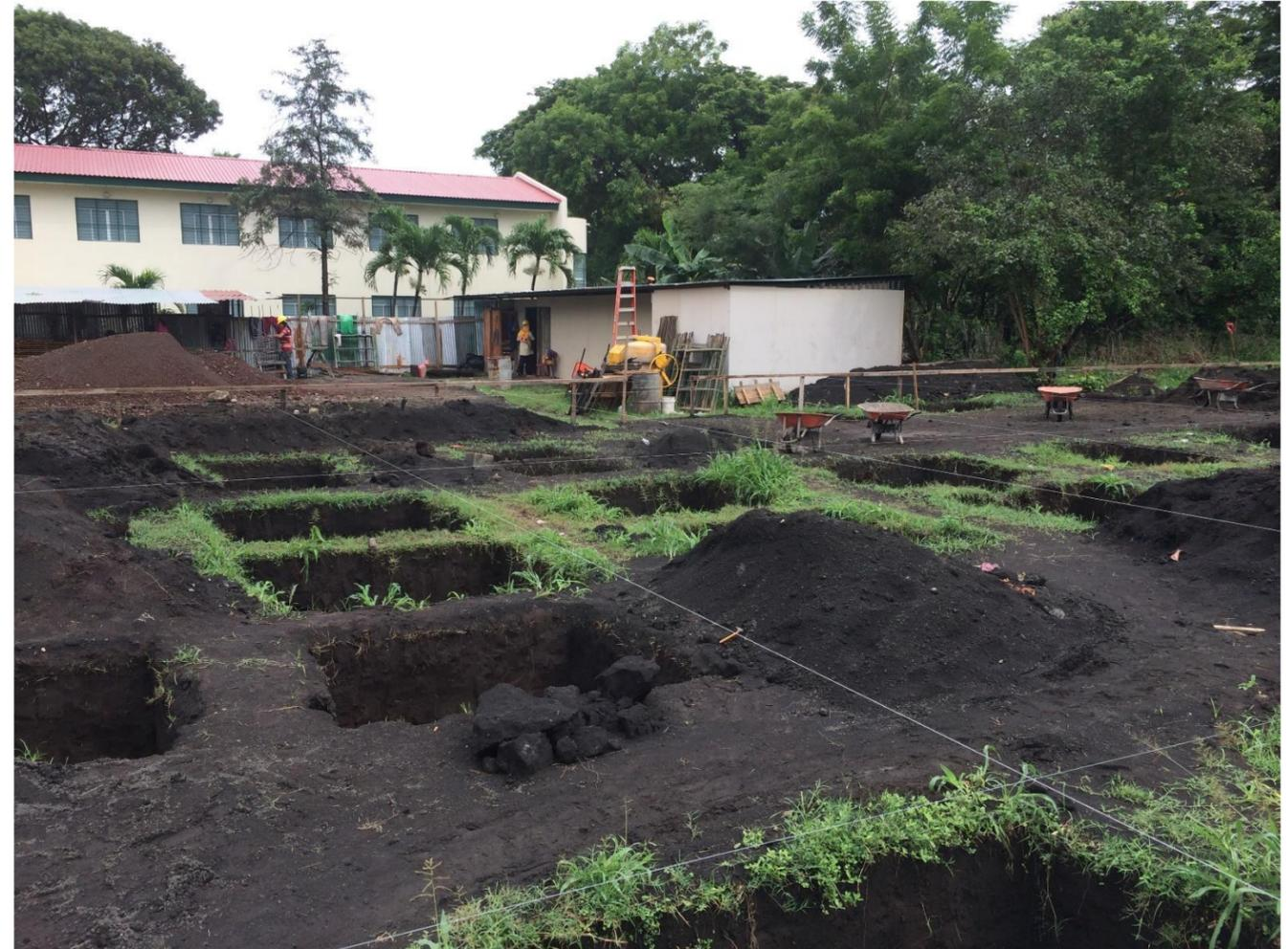
**IMAGEN No. 8** Movimiento de tierra. Excavación estructural para zapatas. Fuente: Autor.
