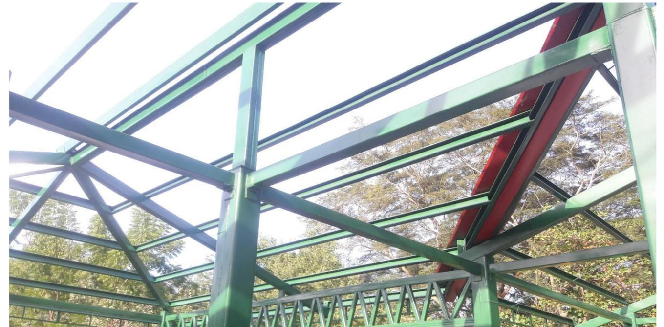
**IMAGEN No. 117** Estructura de techos. Detalle de canalización limahoya. Fuente: Autor.
