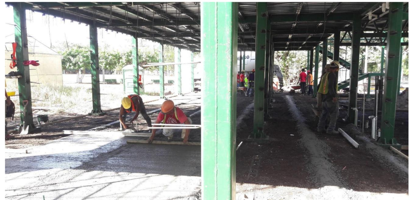
**IMAGEN No. 155** Concreto estructural 2500 Psi. Nivelado de concreto con mairras.
