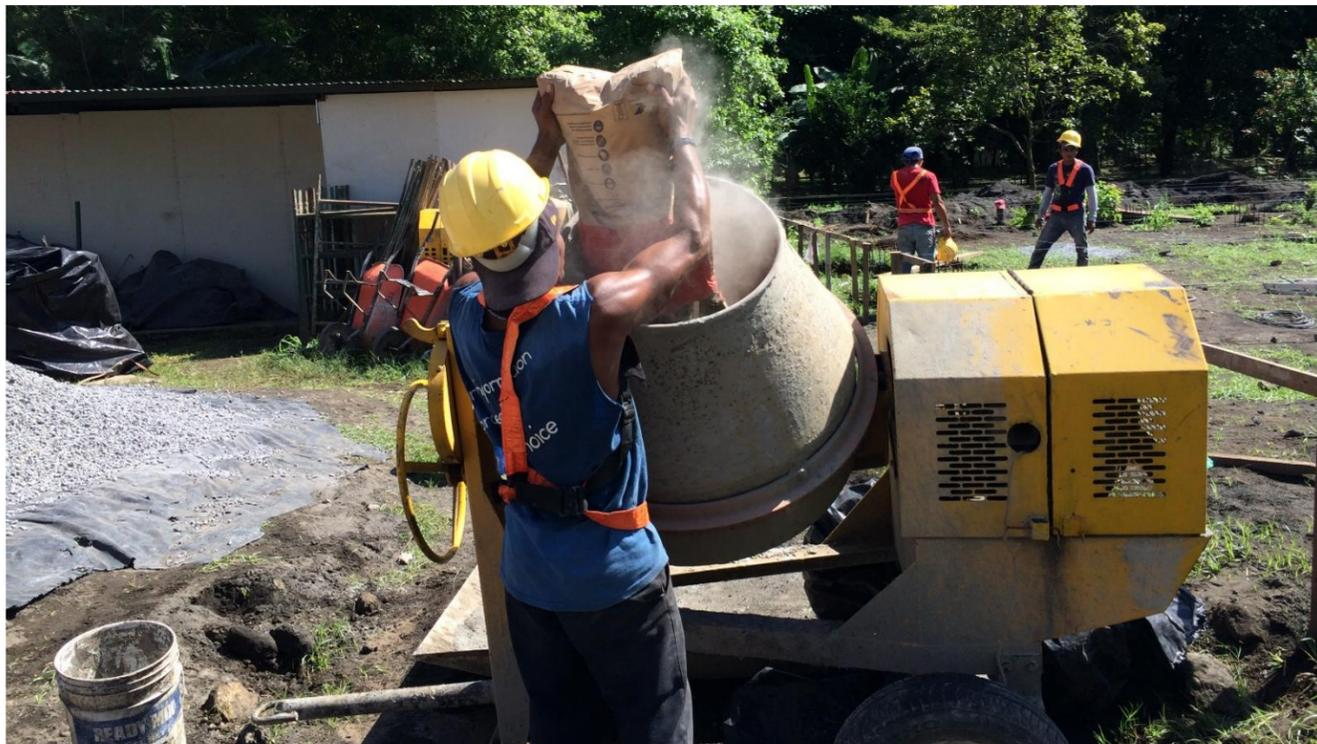
IMAGEN No. 47 Concreto Estructural 3000 Psi. Proceso de mezclado. Fuente: Autor.
