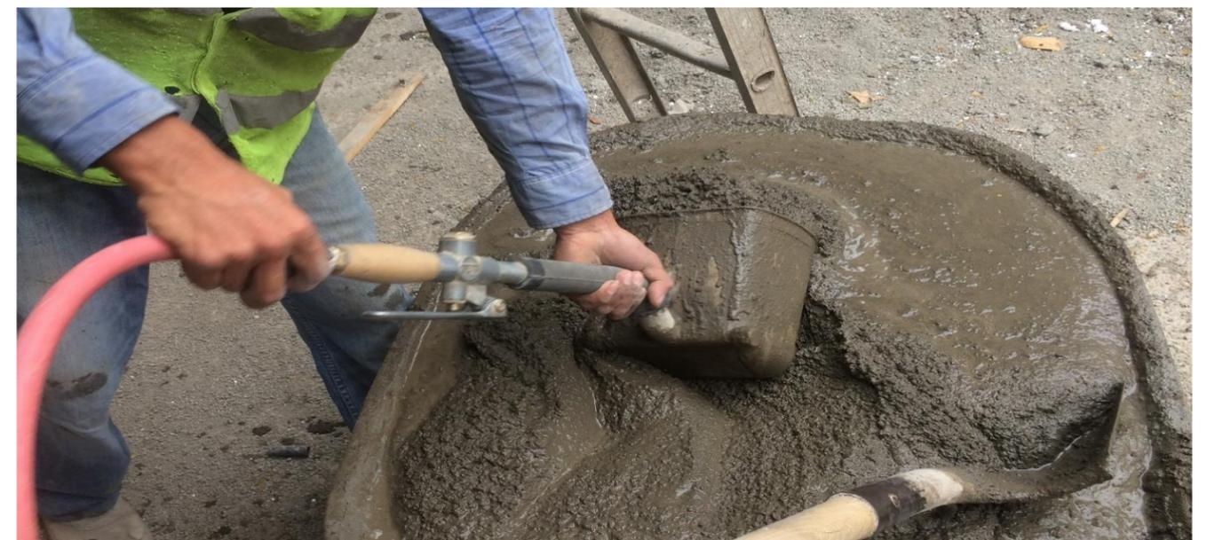
**IMAGEN No. 178** Paredes de covintec. Mezcla de mortero para chilatear. Fuente: Autor.
