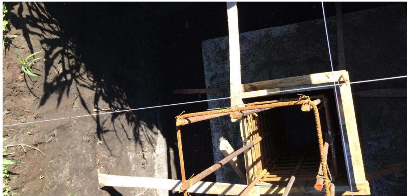
**IMAGEN No. 44** Formaletas. Nivelación a plomo de formaleta para zapata Z-1 Fuente: Autor.
