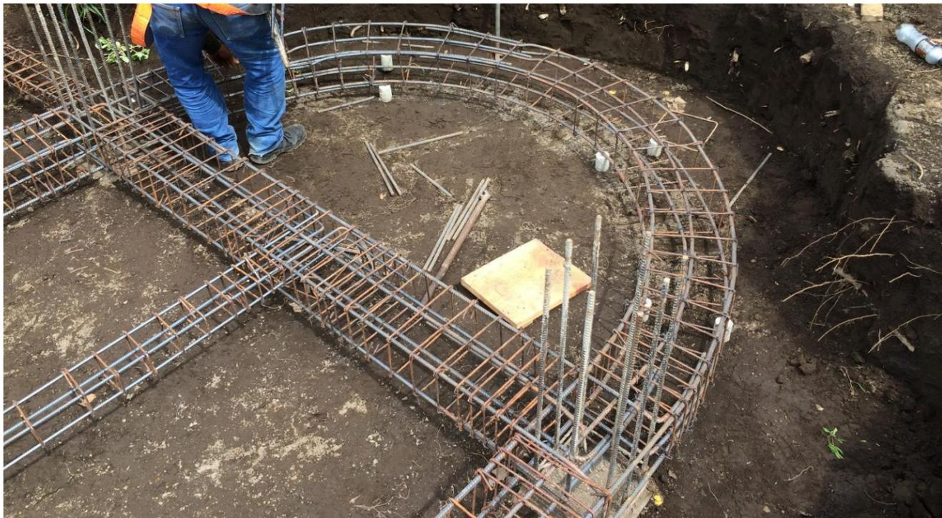
**IMAGEN No. 56** Armado de hierro. Espaciamiento de estribos en sección semi circular. Fuente: Autor.
