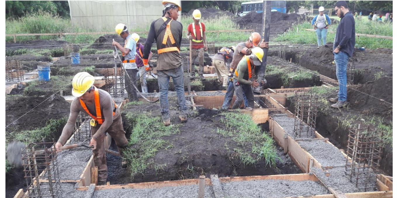
**IMAGEN No. 68** Concreto estructural 3000 Psi. Autor haciendo revisión de llena de viga
