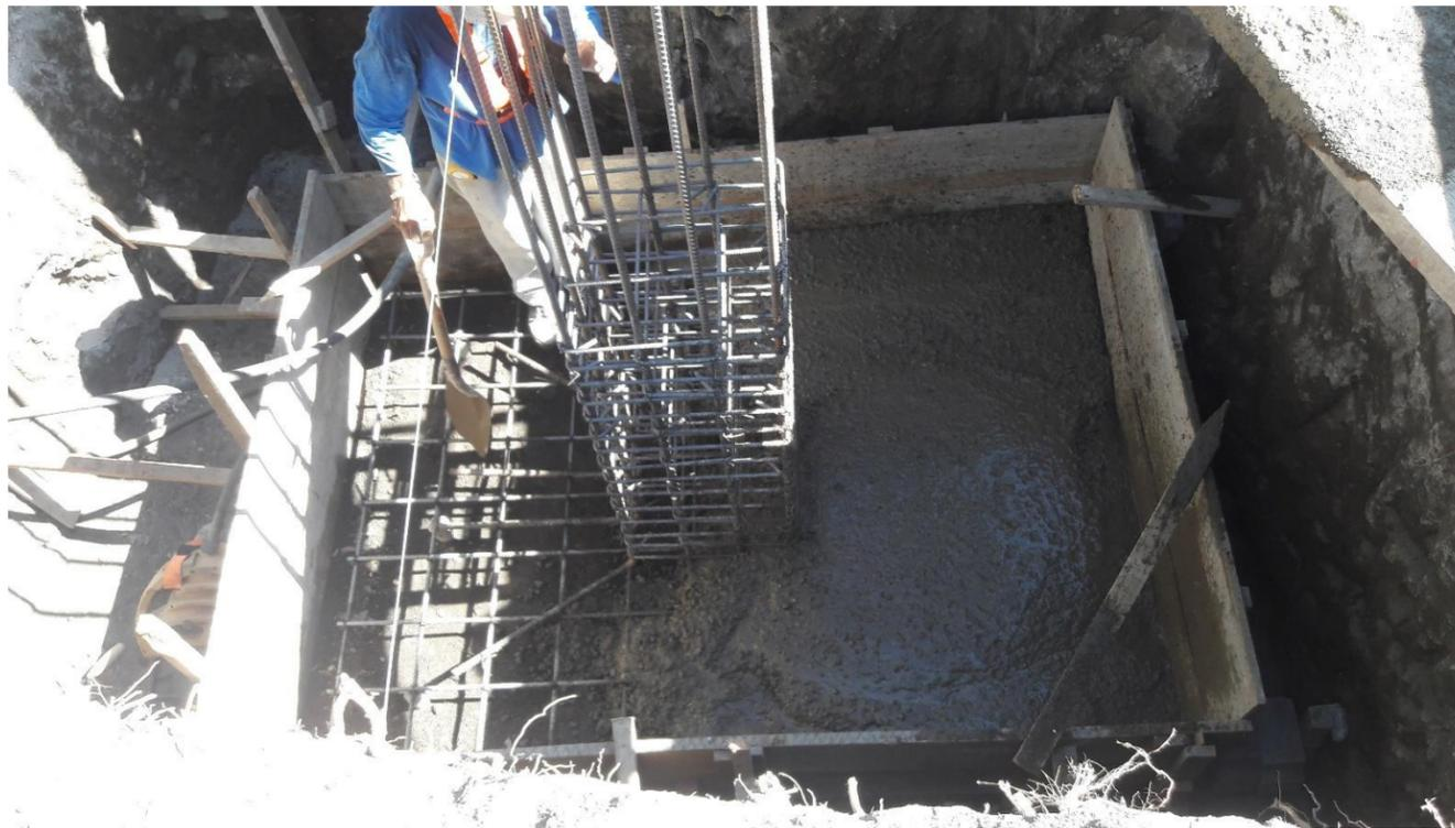
**IMAGEN No. 203** Concreto estructural 3000 Psi. Llena de zapatas. Formaletas. Instalación de formaletas en zapata Z-1 Excavación con tubería de redes expuesta. Fuente: Autor.
