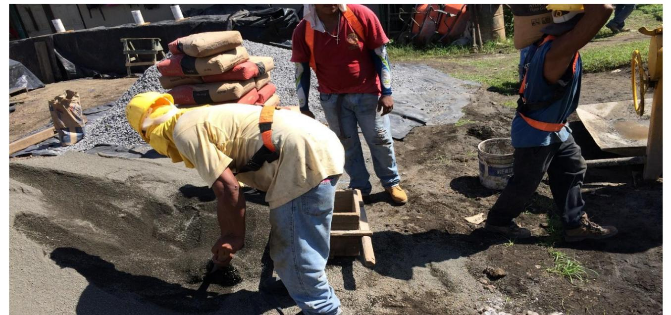
IMAGEN No. 49 Concreto Estructural 3000 Psi. Proceso de mezclado. Fuente: Autor.
