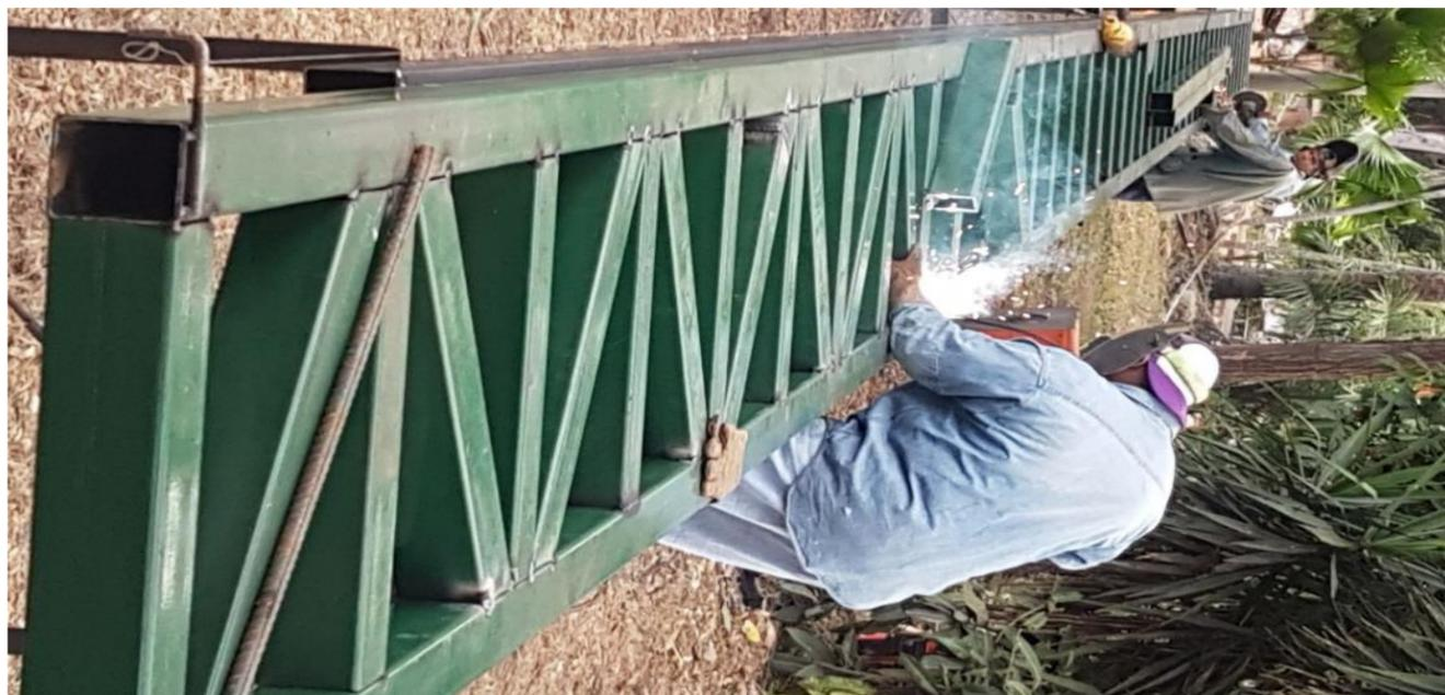
**IMAGEN No. 215** Estructura metálica. Construcción de cercha metálica. Fuente: Autor
