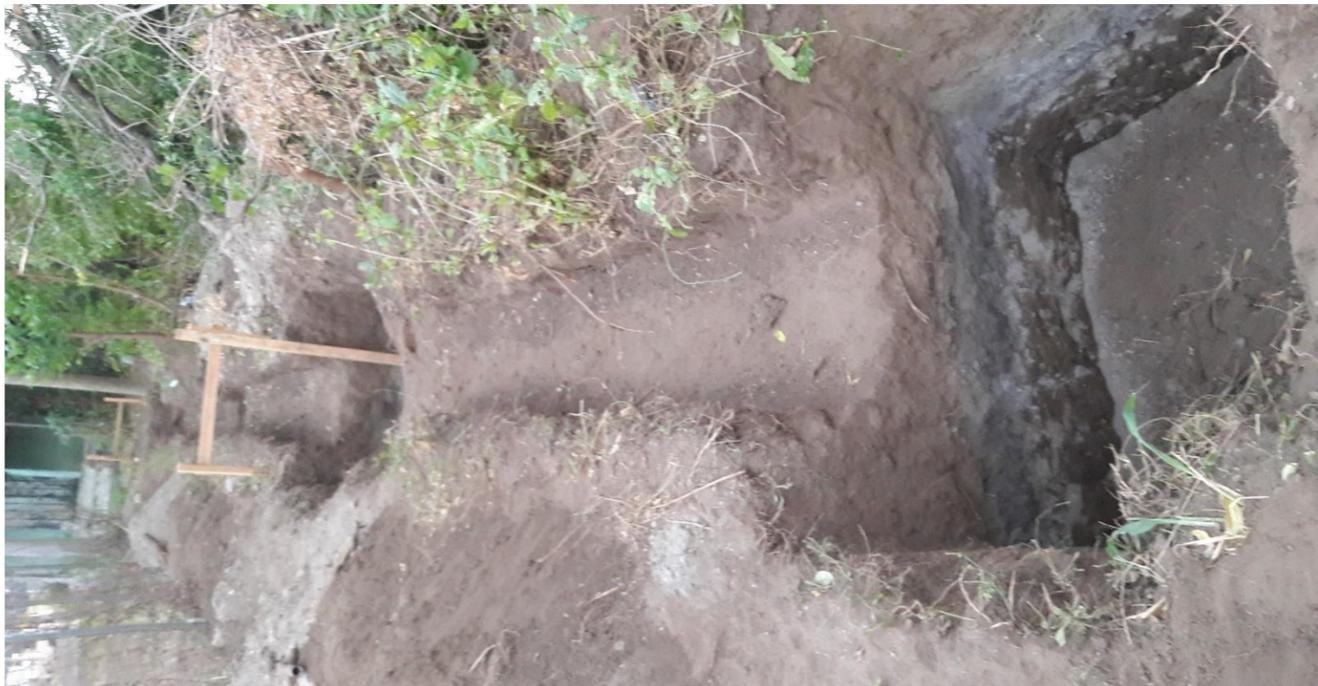
**IMAGEN No. 218** Movimiento de tierra, excavación para zapatas. Fuente: Autor.
