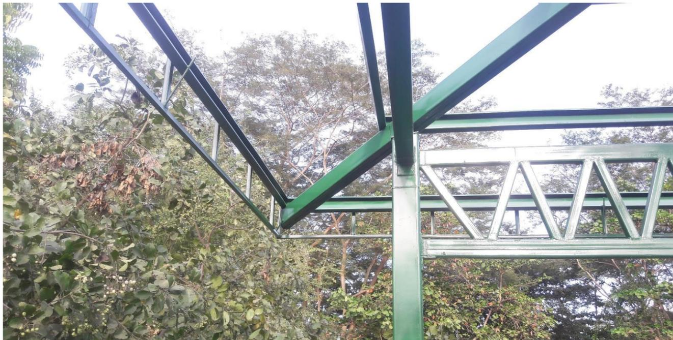
**IMAGEN No. 115** Estructura de techos. Detalle de fascia. Fuente: Autor.
