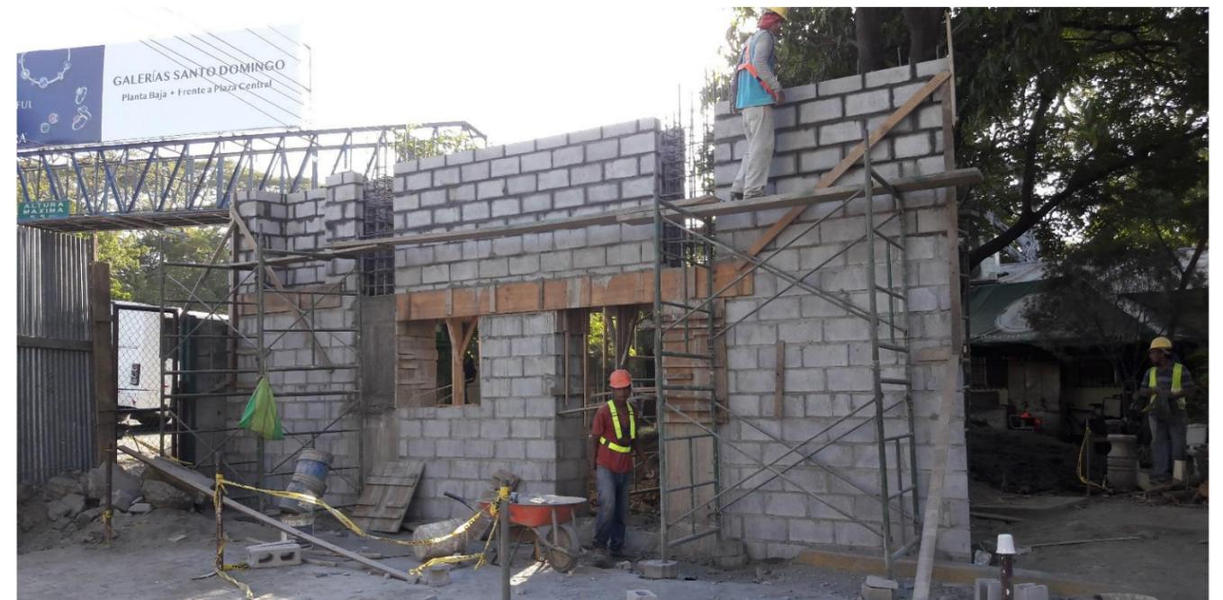
**IMAGEN No. 209** Paredes de mampostería reforzada. Construcción de paredes estructurales. Fuente: Autor.
