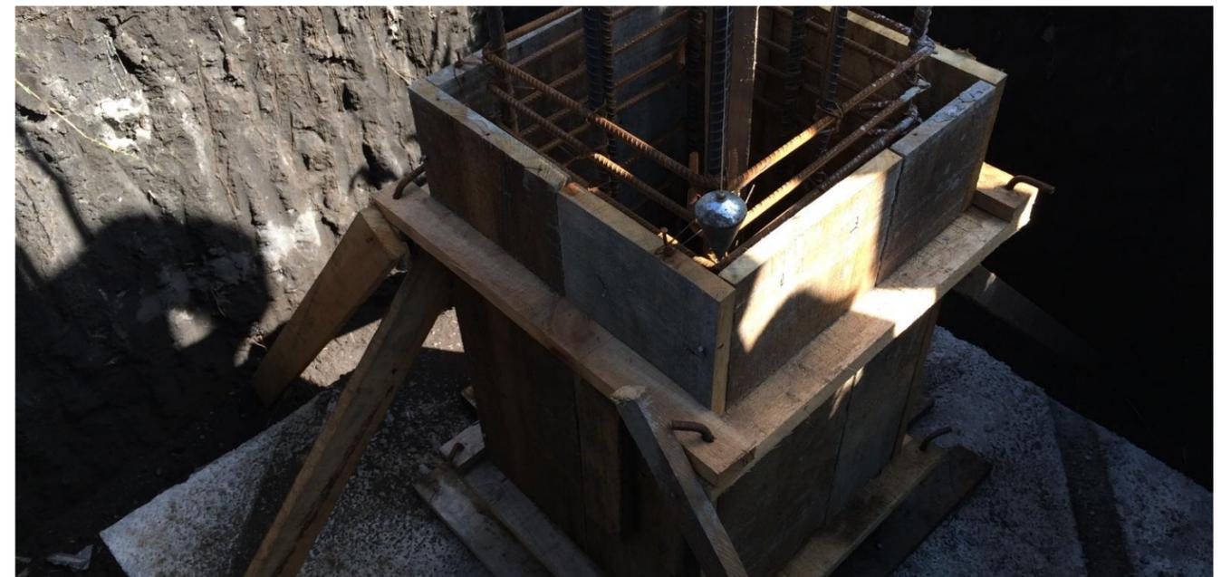
**IMAGEN No. 45** Formaletas. Nivelación a plomo de formaletas para zapata Z-1. Fuente: Autor.
