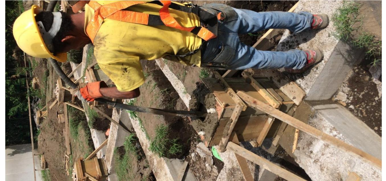
**IMAGEN No. 83** Concreto estructural 3000 Psi. Llena de pedestal PD-1 y proceso de vibrado de concreto. Fuente: Autor.
