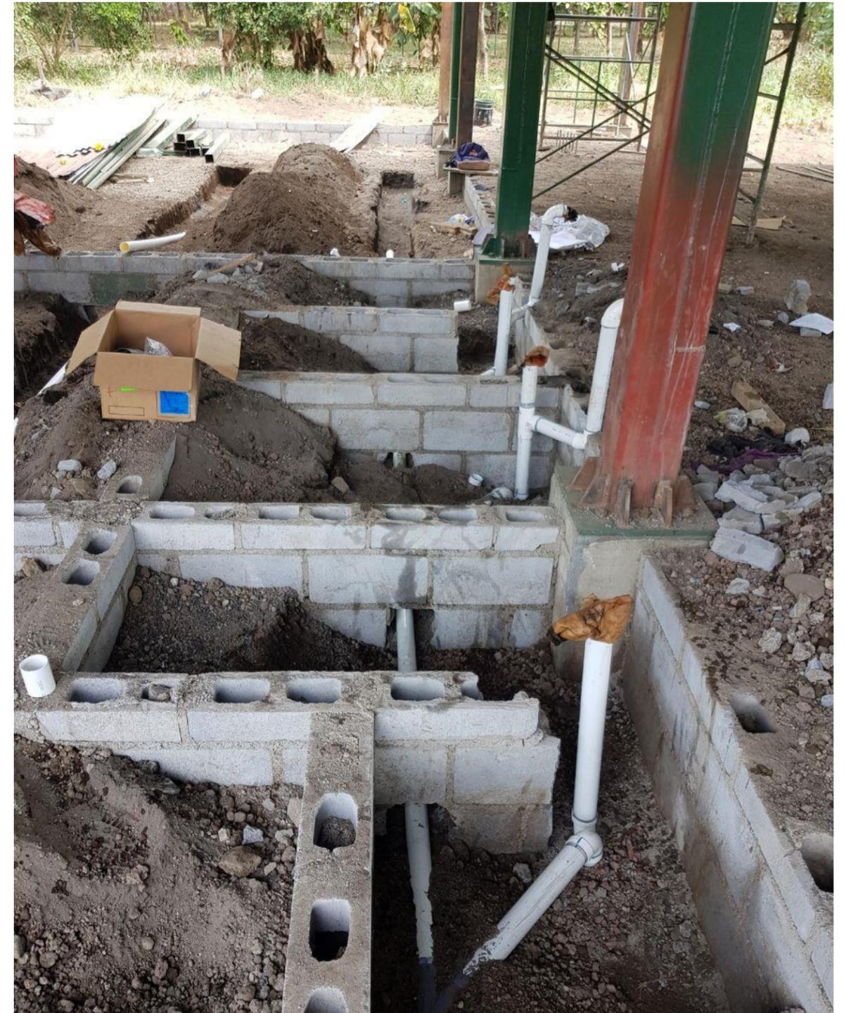
**IMAGEN No. 146** Tubería y accesorios de aguas negras. Instalación de tragantes de inodoro. Fuente: Autor.
