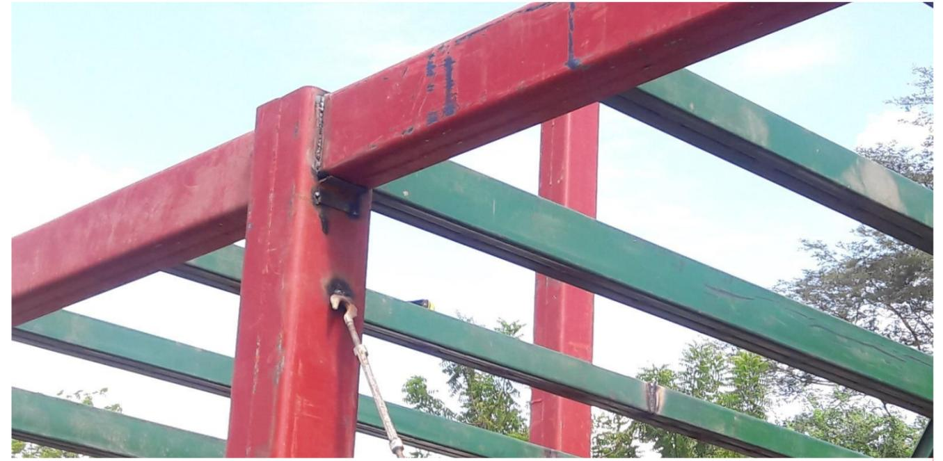
**IMAGEN No. 104** Estructura metálica. Colocación de columnas metálicas. Fuente: Autor.
