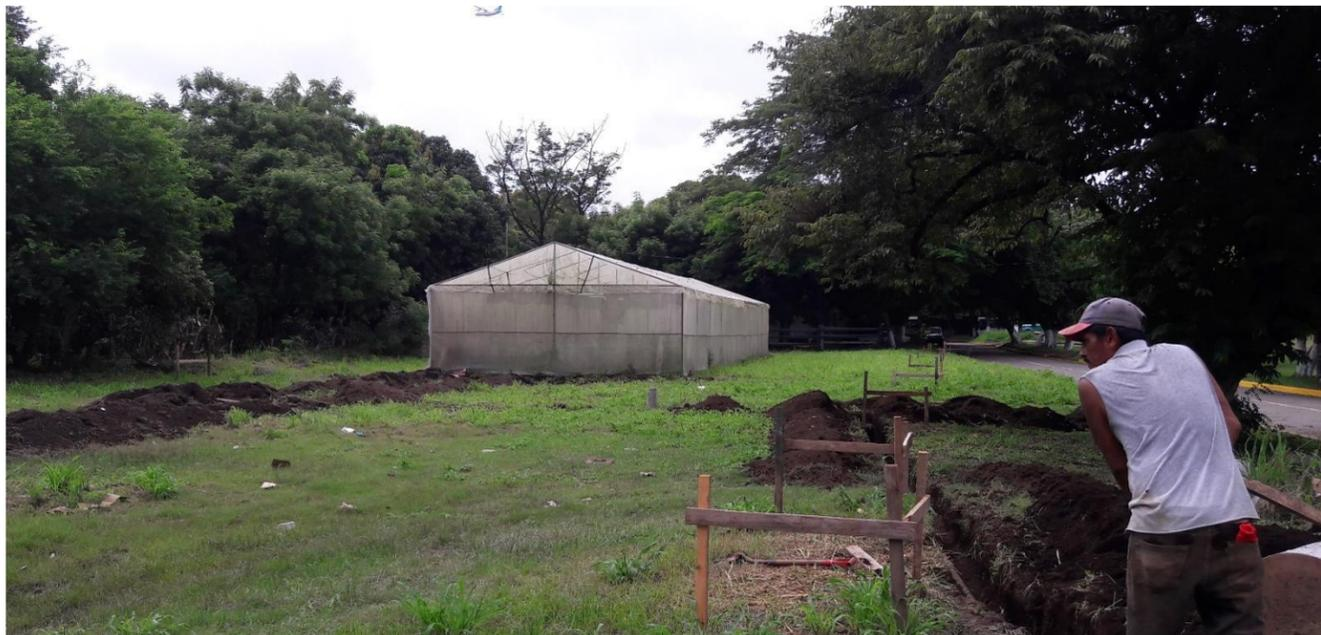
**IMAGEN No. 141** Tubería y acceso de agua potable. Excavación para colocación de tubo madre de agua potable. Fuente: Autor.
