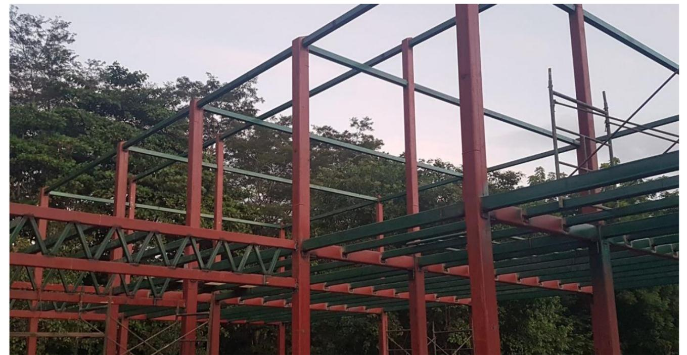
**IMAGEN No. 112** Estructura metálica. Colocación de cercha metálica. Fuente: Autor.
