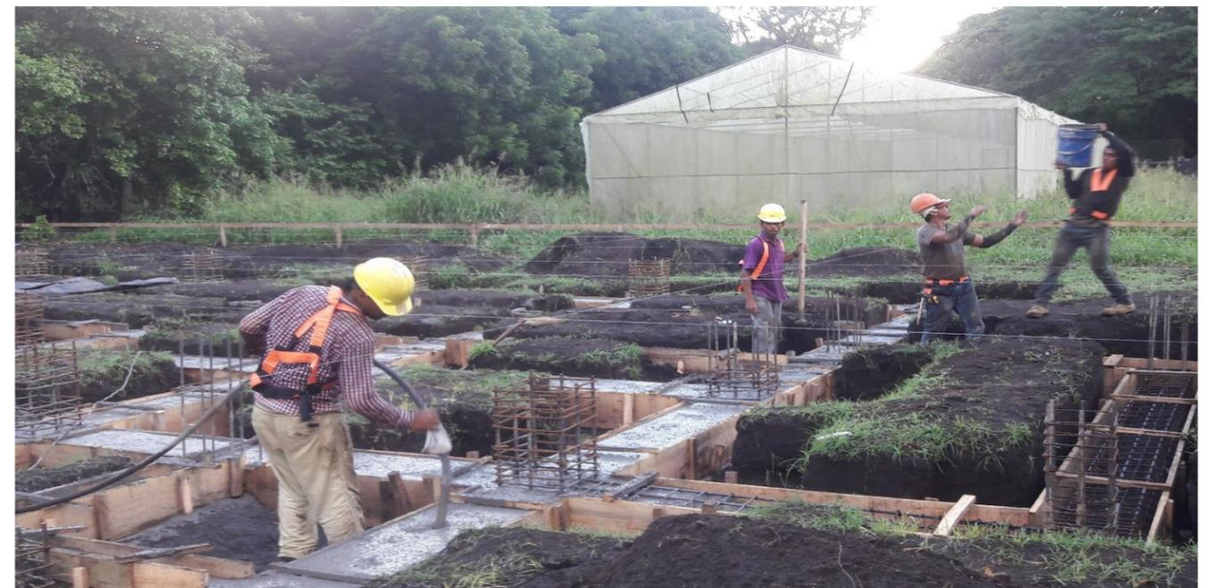
**IMAGEN No. 70** Concreto estructural 3000 Psi. Llena de viga asísmica. Fuente: Autor.
