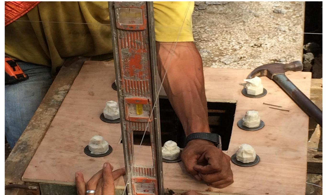
**IMAGEN No. 80** Fundaciones hierro de refuerzo. Colocación y recubrimiento de pernos metálicos. Fuente: Autor.
