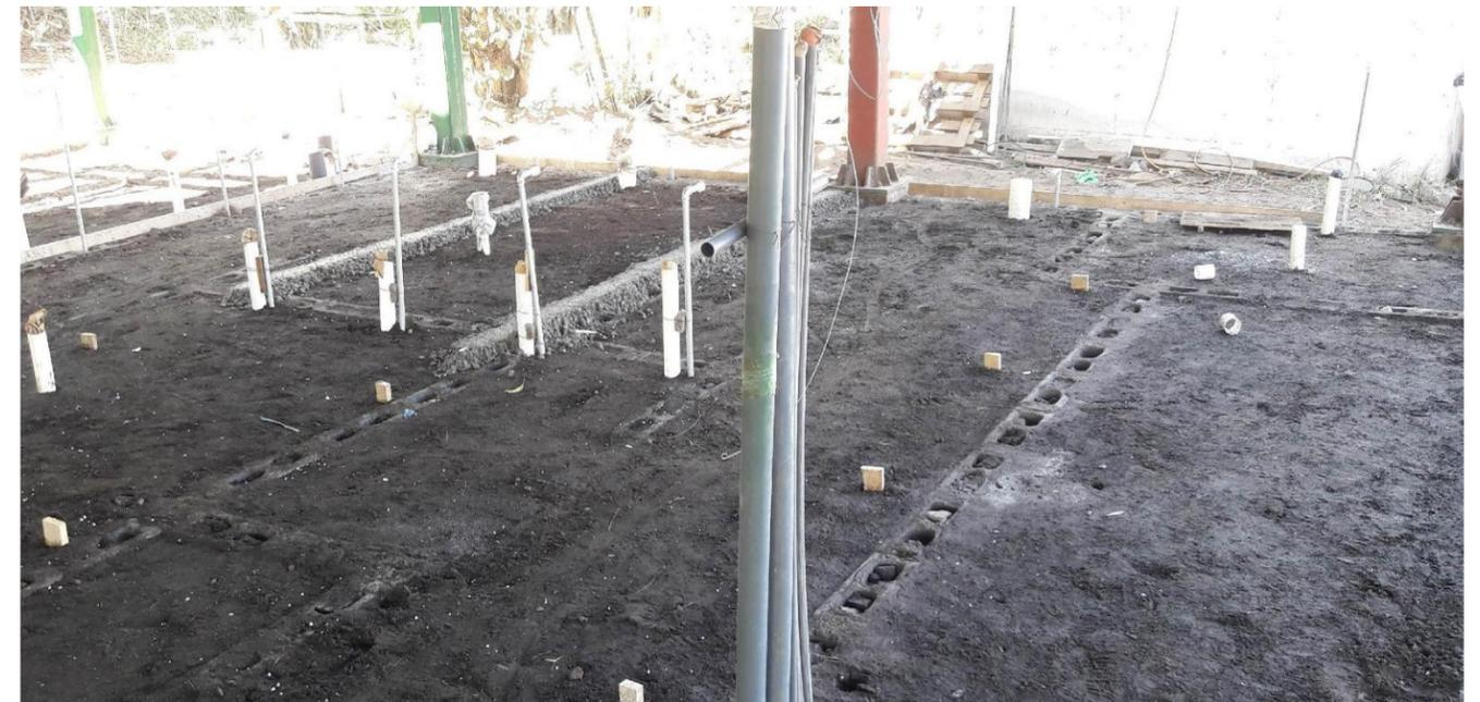
**IMAGEN No. 140** Distribución de agua potable. red de agua potable en primera planta de edificio. Fuente: Autor.
