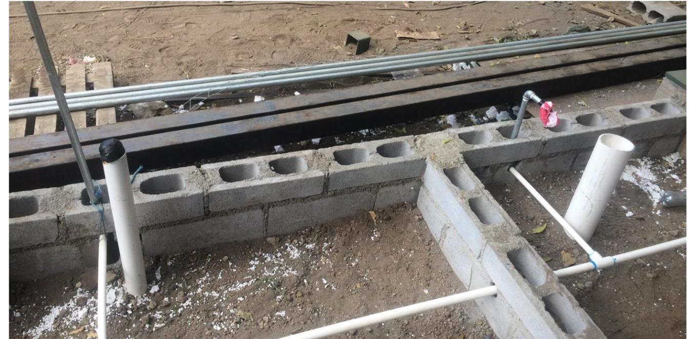
**IMAGEN No. 142** Distribución de agua potable. red de agua potable en primera planta de edificio. Fuente: Autor.
