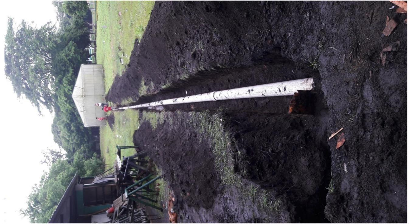
**IMAGEN No. 137** Tubería y acceso de agua potable. Excavación para colocación de tubo madre de agua potable. Fuente: Autor.
