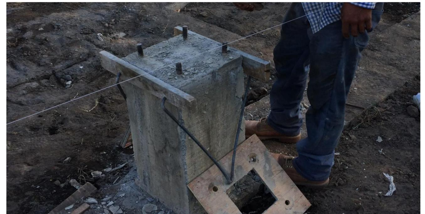
**IMAGEN No. 85** Formaletas. Desencofrado de pedestal PD-2 Y limpieza de borde superior. Fuente: Autor.
