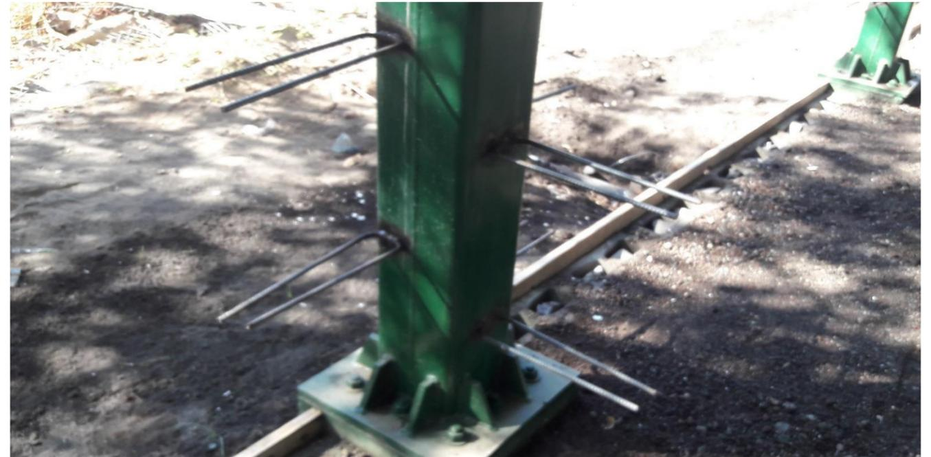
**IMAGEN No. 159** Paredes de covintec. Anclas para paneles de covintec. Fuente: Autor.
