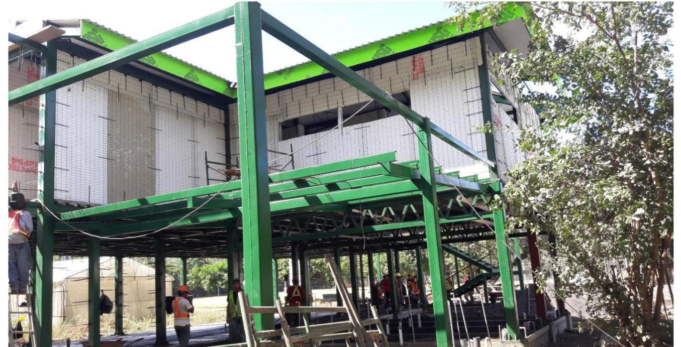
**IMAGEN No. 175** Paredes de covintec. Instalación de paneles. Fuente: Autor
