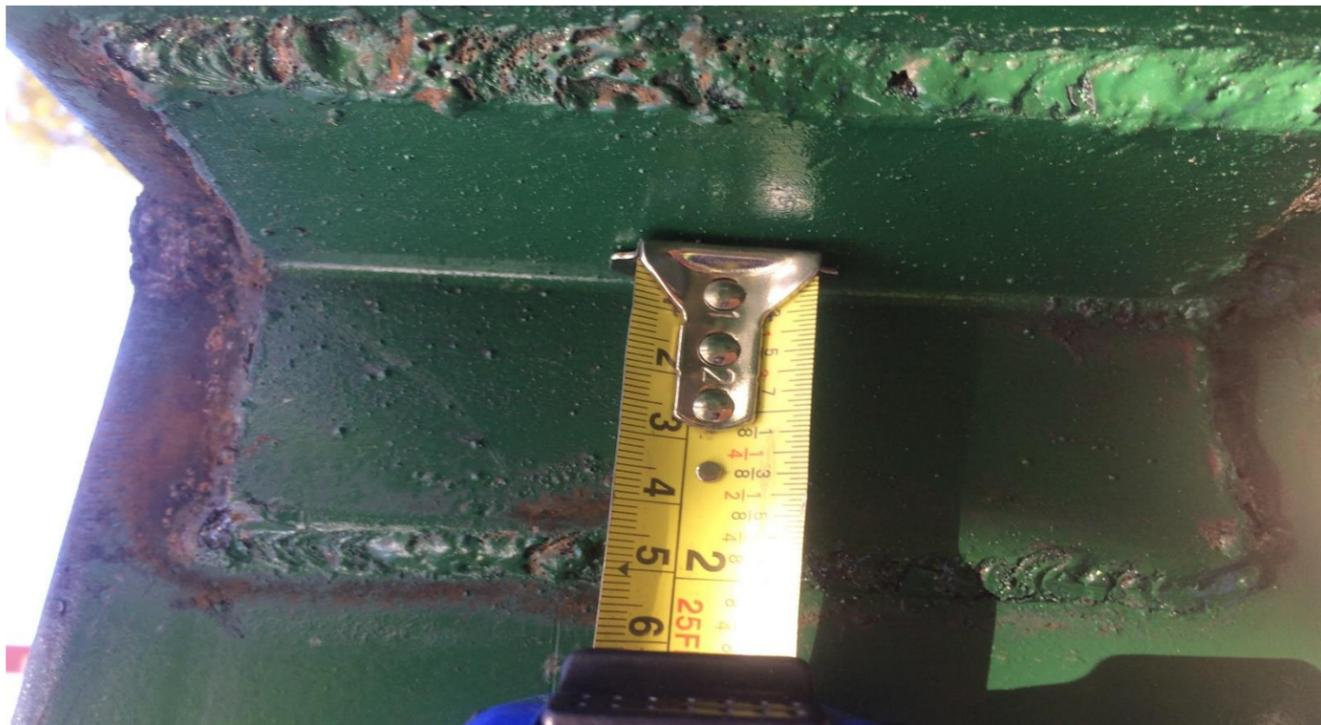
**IMAGEN No. 105** Acero de refuerzo. Revisión de Angulares en vigas. Fuente: Autor.
