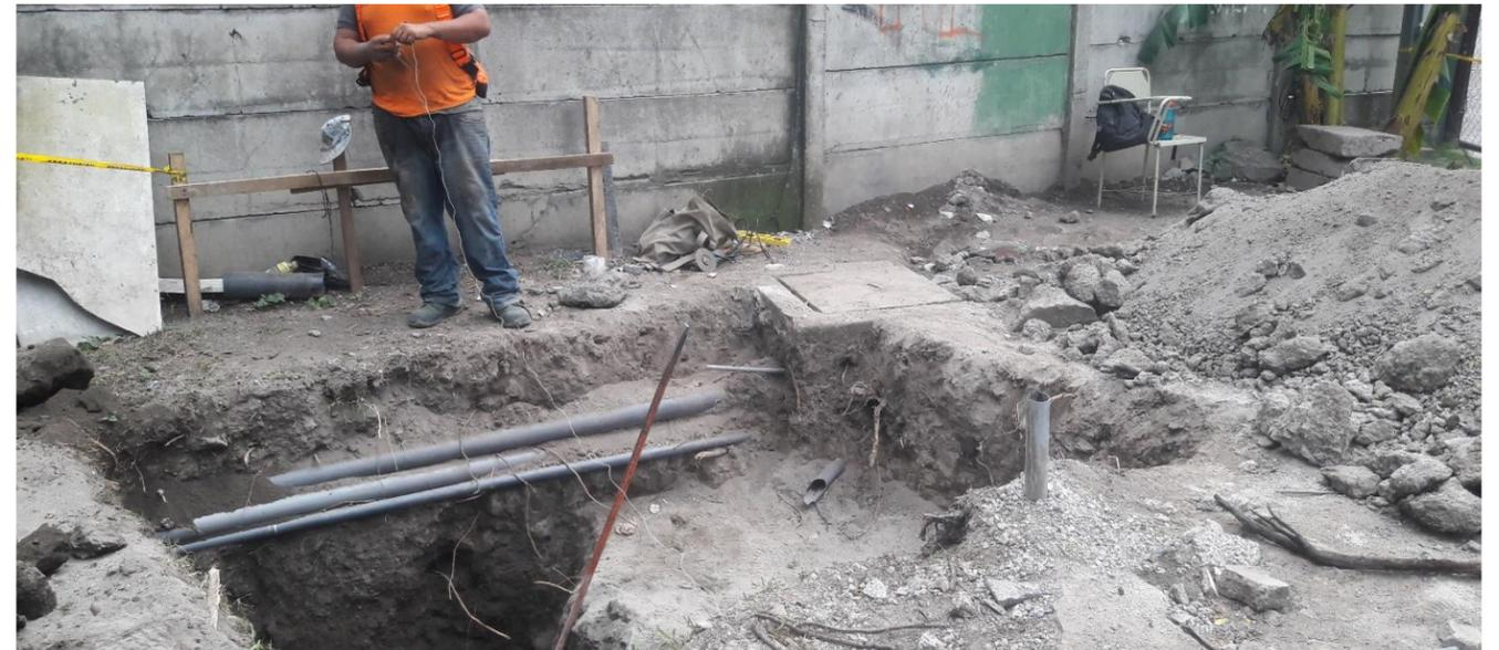
**IMAGEN No. 196** Excavación con tubería de redes expuesta. Fuente: Autor.
