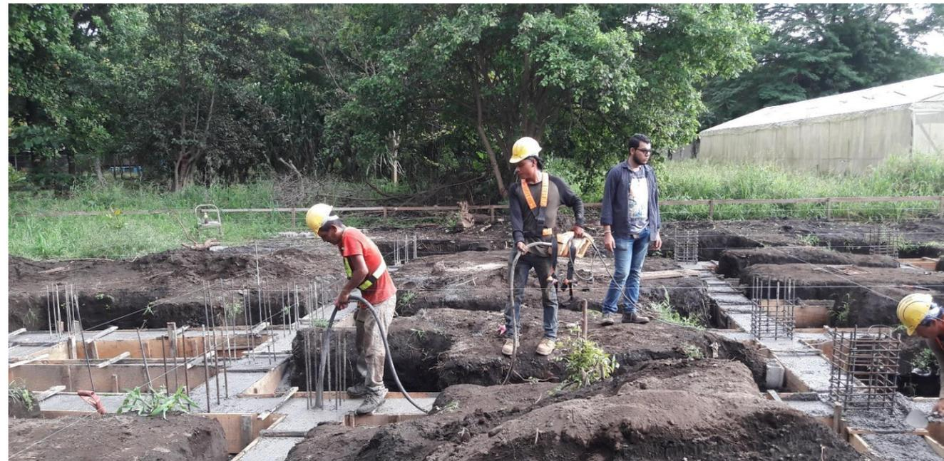
**IMAGEN No. 71** Concreto estructural 3000 Psi. Autor haciendo revisión de llena de viga asísmica y proceso de vibrado. Fuente: Autor.
