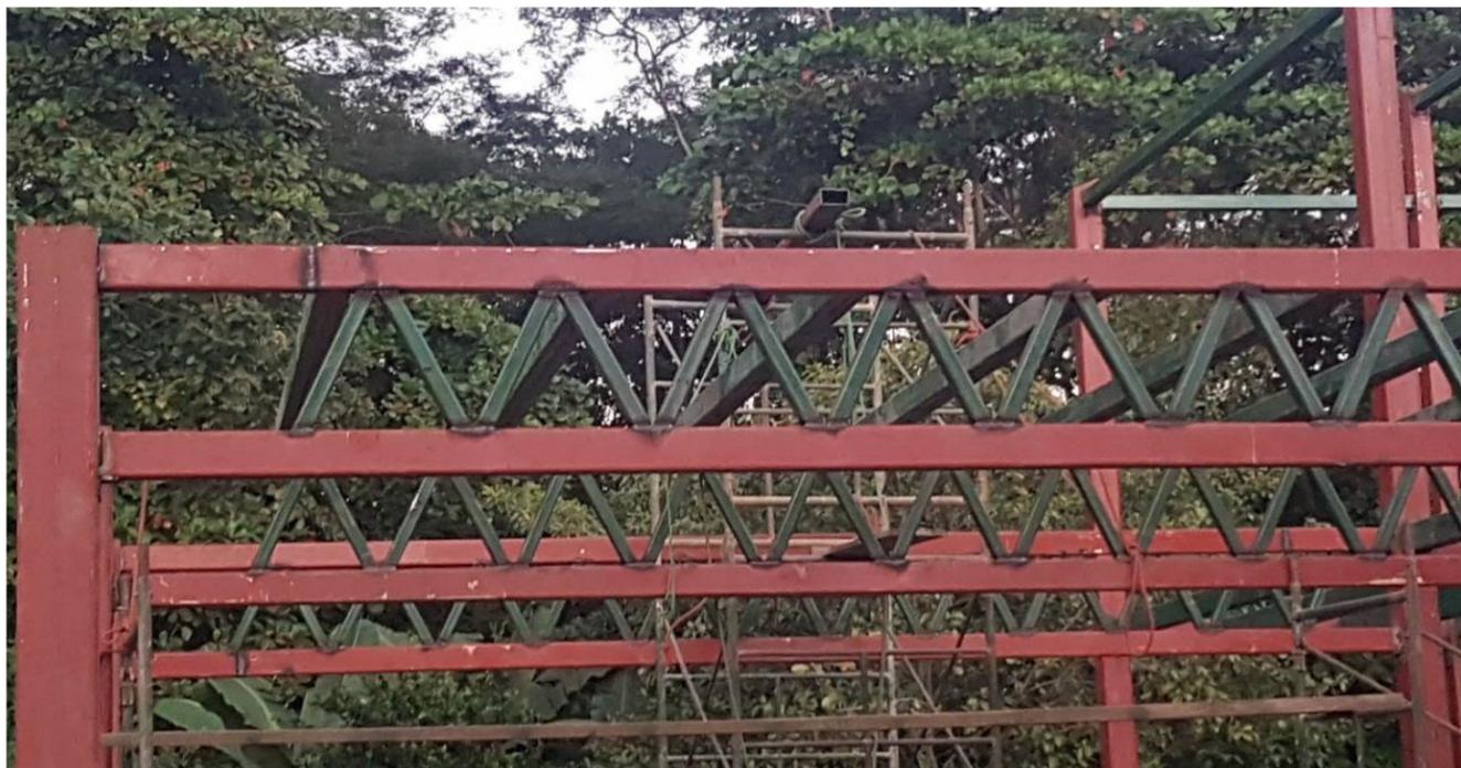
**IMAGEN No. 111** Estructura metálica. Colocación de cercha metálica. Fuente: Autor.
