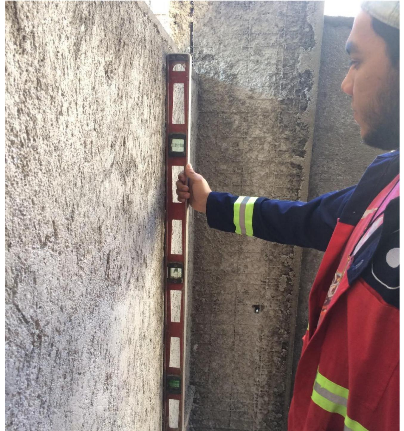
**IMAGEN No. 185** Paredes de covintec. Autor haciendo revisión de nivel de paredes de covintec. Fuente: Autor
