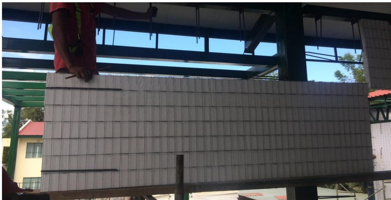
**IMAGEN No. 162** Paredes de covintec. Instalación de paneles. Fuente: Autor.
