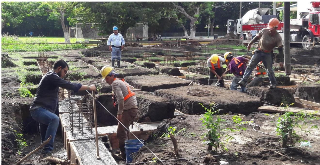
**IMAGEN No. 67** Concreto estructural 3000 Psi. Autor haciendo revisión de nivel de concreto en viga asísmica. Fuente: Autor.
