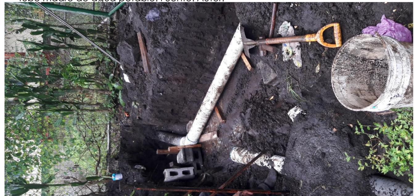
**IMAGEN No. 139** Tubería y acceso de agua potable. Excavación para colocación de tubo madre de agua potable. Fuente: Autor.
