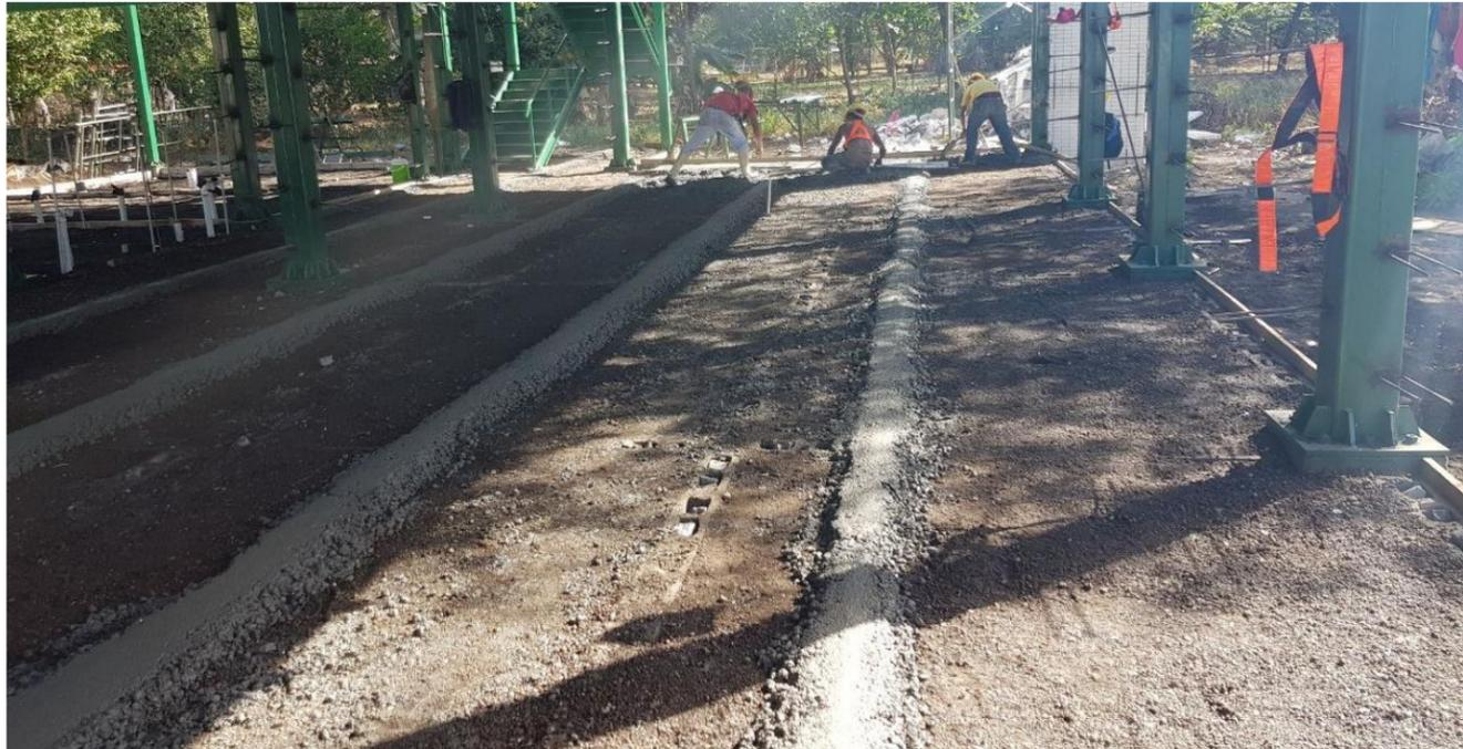
**IMAGEN No. 156** Concreto estructural 2500 Psi. Nivelado de concreto con mairras.
