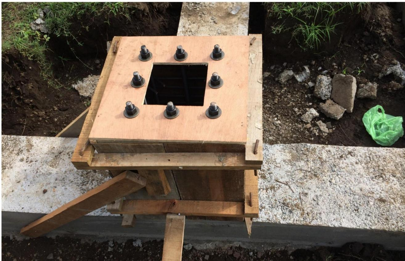
**IMAGEN No. 77** Formaletas de pedestales. PD-1 Y tapa superior con pernos. Fuente: Autor.
