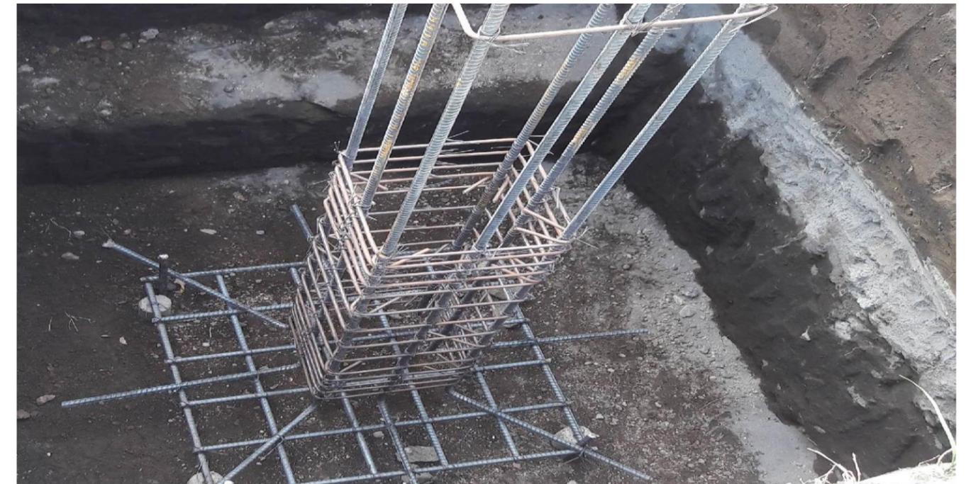
**IMAGEN No. 25** Armado de hierro y acero de refuerzo. colocación de zapata sobre quesitos. Fuente: Autor.
