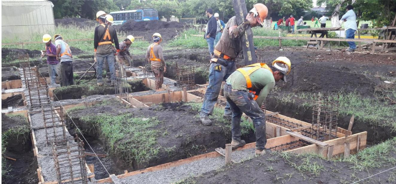
**IMAGEN No. 73** Concreto estructural 3000 Psi. Autor haciendo revisión de llena de viga asísmica y proceso de vibrado. Fuente: Autor.
