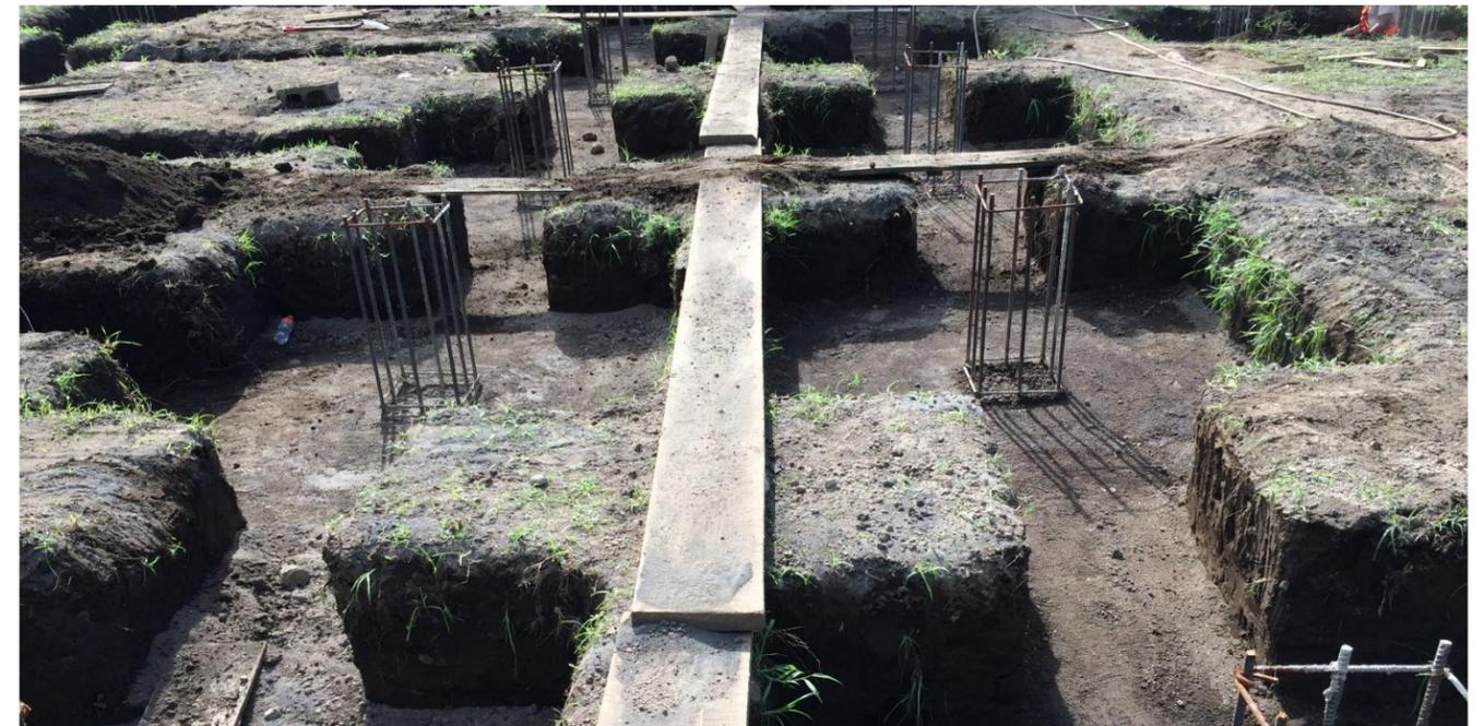
IMAGEN No. 52 Relleno y compactación. Relleno para viga asísmica. Fuente: Autor.
