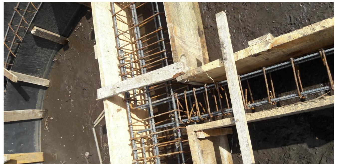
**IMAGEN No. 63** Formaletas. Colocación de formaletas para viga asísmica. Fuente: Autor.
