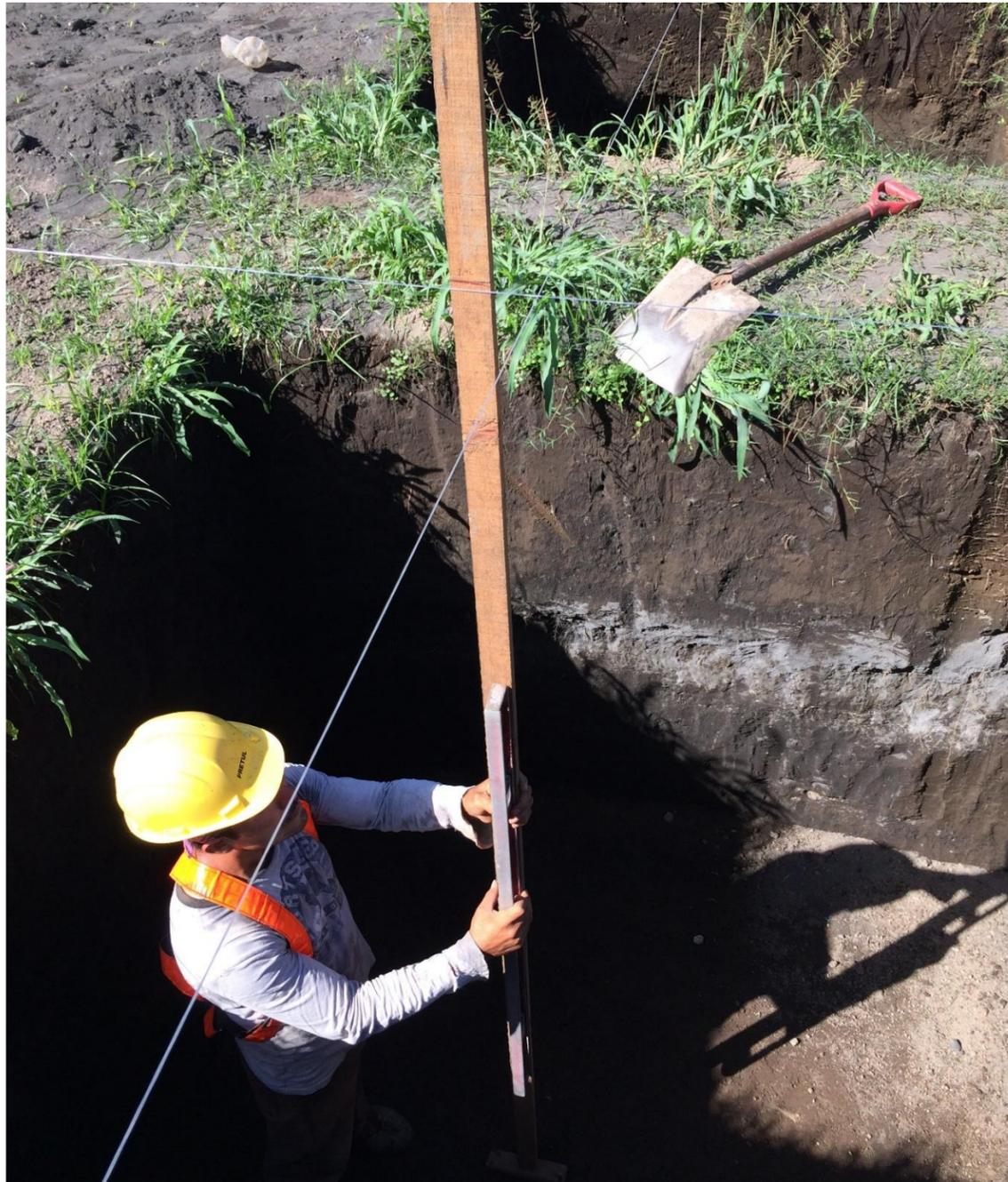
**IMAGEN No. 19** Movimiento de tierra. Revisión de Nivel de excavaciones.
