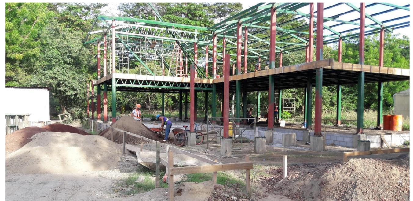
**IMAGEN No. 123** Losa de entrepiso. perspectiva lateral izquierda con formaletas instaladas. Fuente: Autor.
