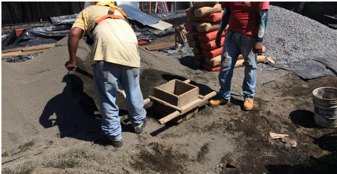
**IMAGEN No. 34** Concreto estructural 3000 psi, Mezcla de concreto Fuente: Autor.
