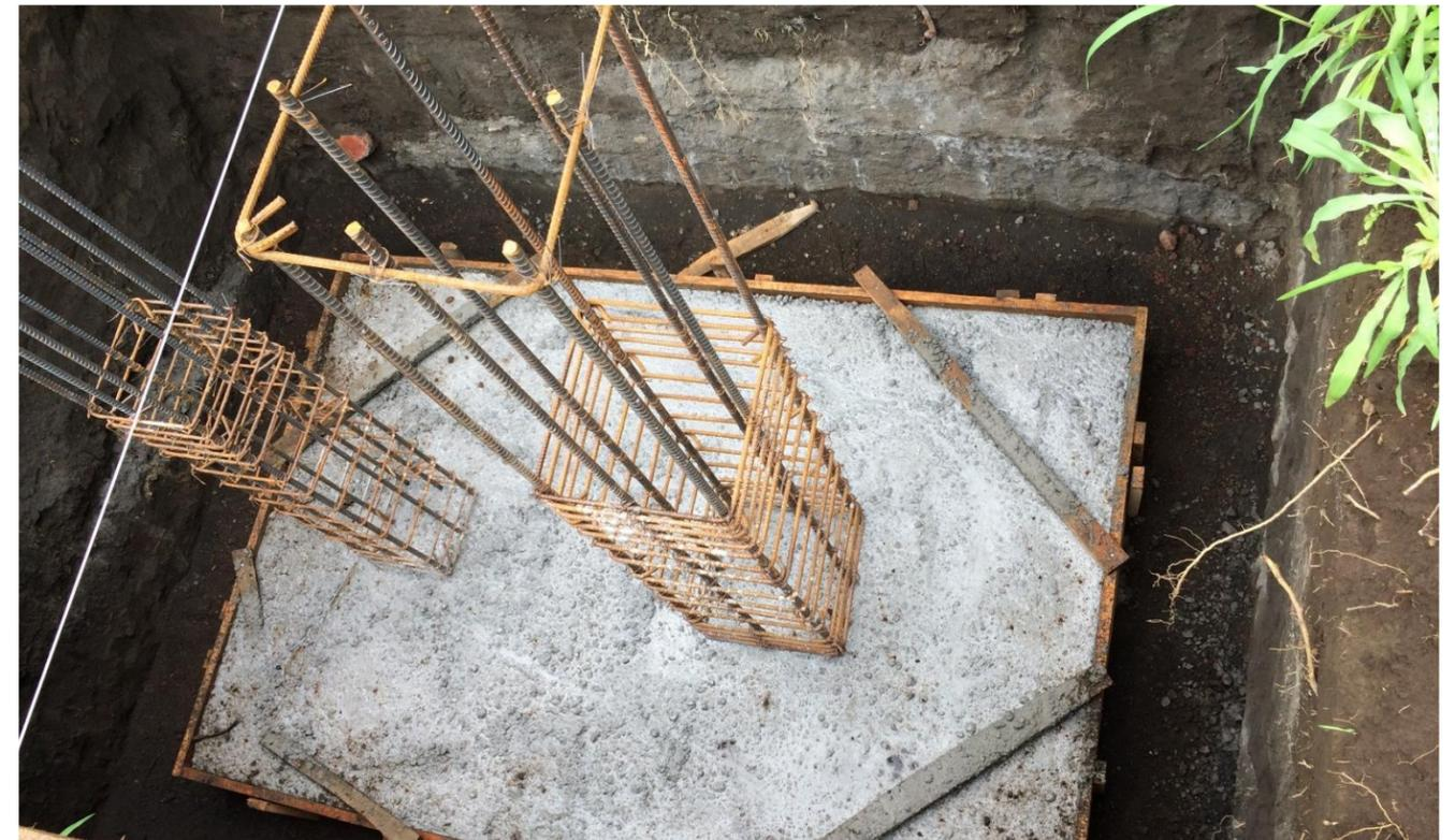
**IMAGEN No. 40** Desencofrado. Zapata Z4, momento previo al desencofrado. Fuente: Autor.
