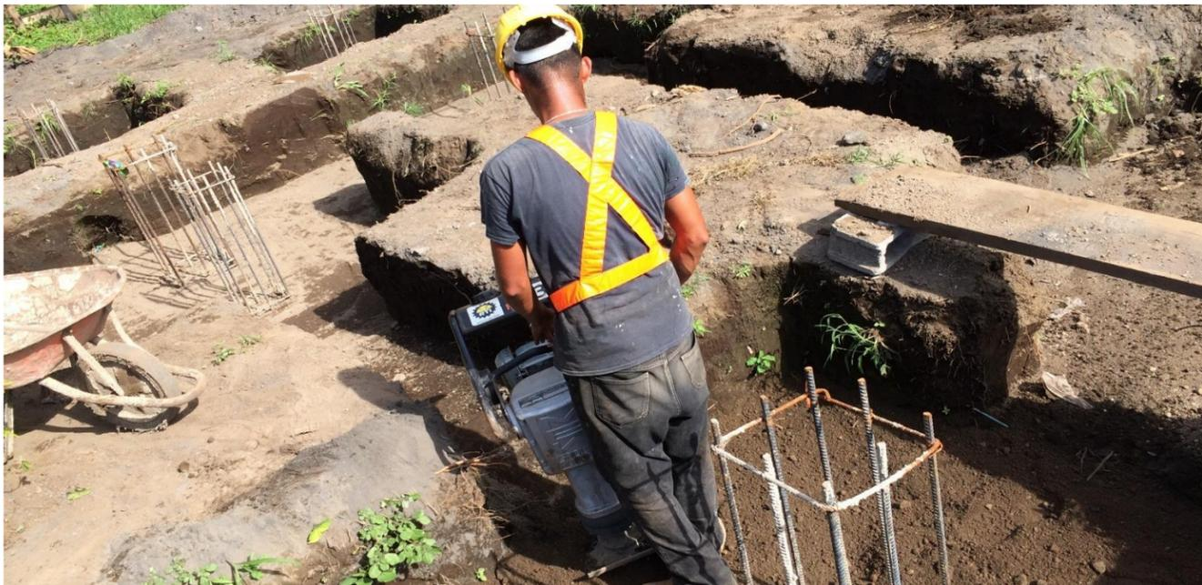
IMAGEN No. 53 Relleno y compactación. Relleno para viga asísmica. Fuente: Autor.
