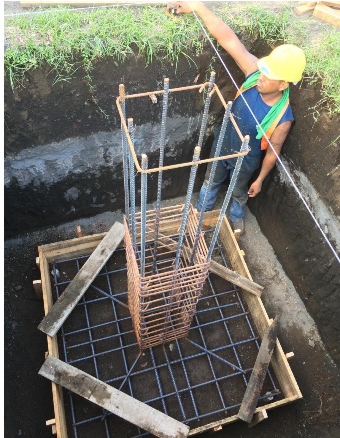
**IMAGEN No. 32** Formaletas. Colocación y centralización de formaletas.
