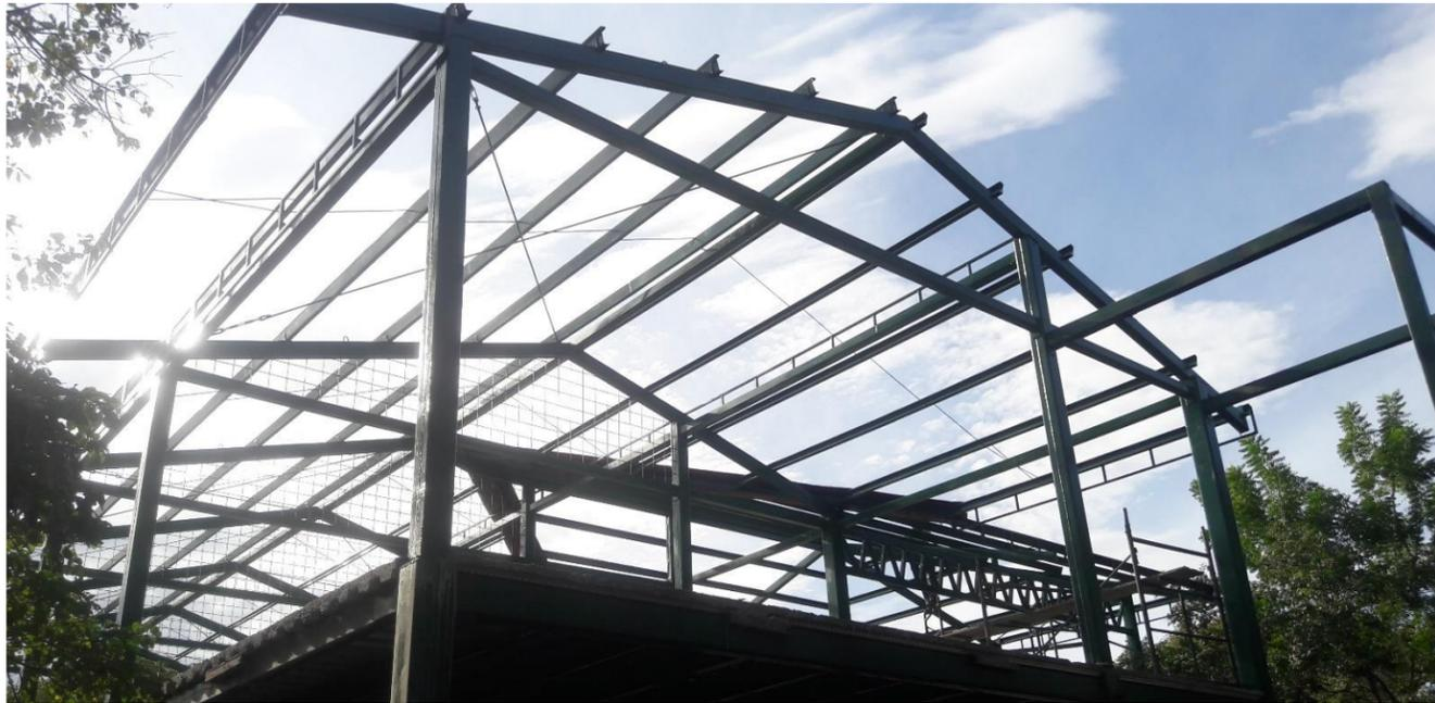
**IMAGEN No. 116** Estructura de techos. perspectiva lateral derecha del edificio con la estructura de techos armada. Fuente: Autor.
