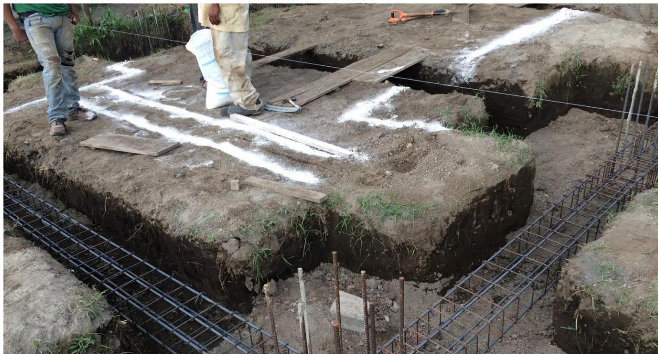
**IMAGEN No. 59** Movimiento de tierra. Trazado con cal para viga asísmica VA2. Fuente: Autor.
