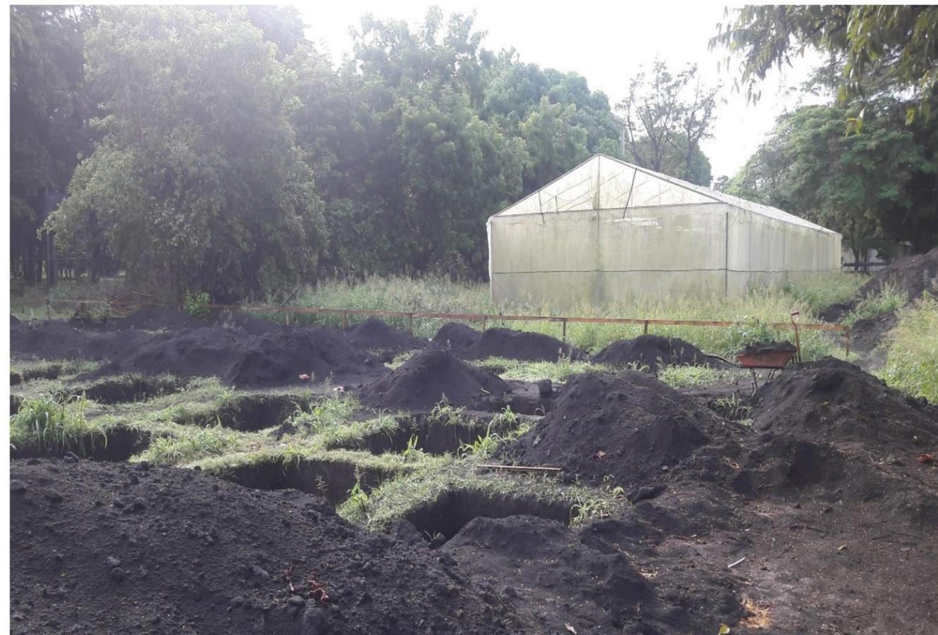
**IMAGEN No. 15** Movimiento de tierra Vista lateral izquierda de excavaciones para zapata. Fuente: Autor.
