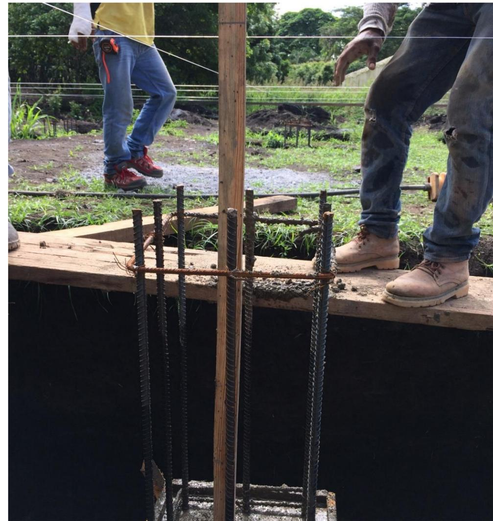
**IMAGEN No. 51** Concreto Estructural 3000 Psi. Nivelación de volumen de concreto en dado de cimentación. Fuente: Autor.
