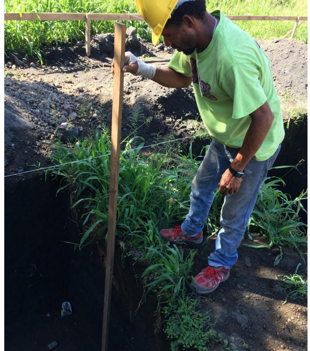
**IMAGEN No. 20** Movimiento de tierra. Revisión de nivel de excavaciones para fundaciones. Fuente: Autor.
