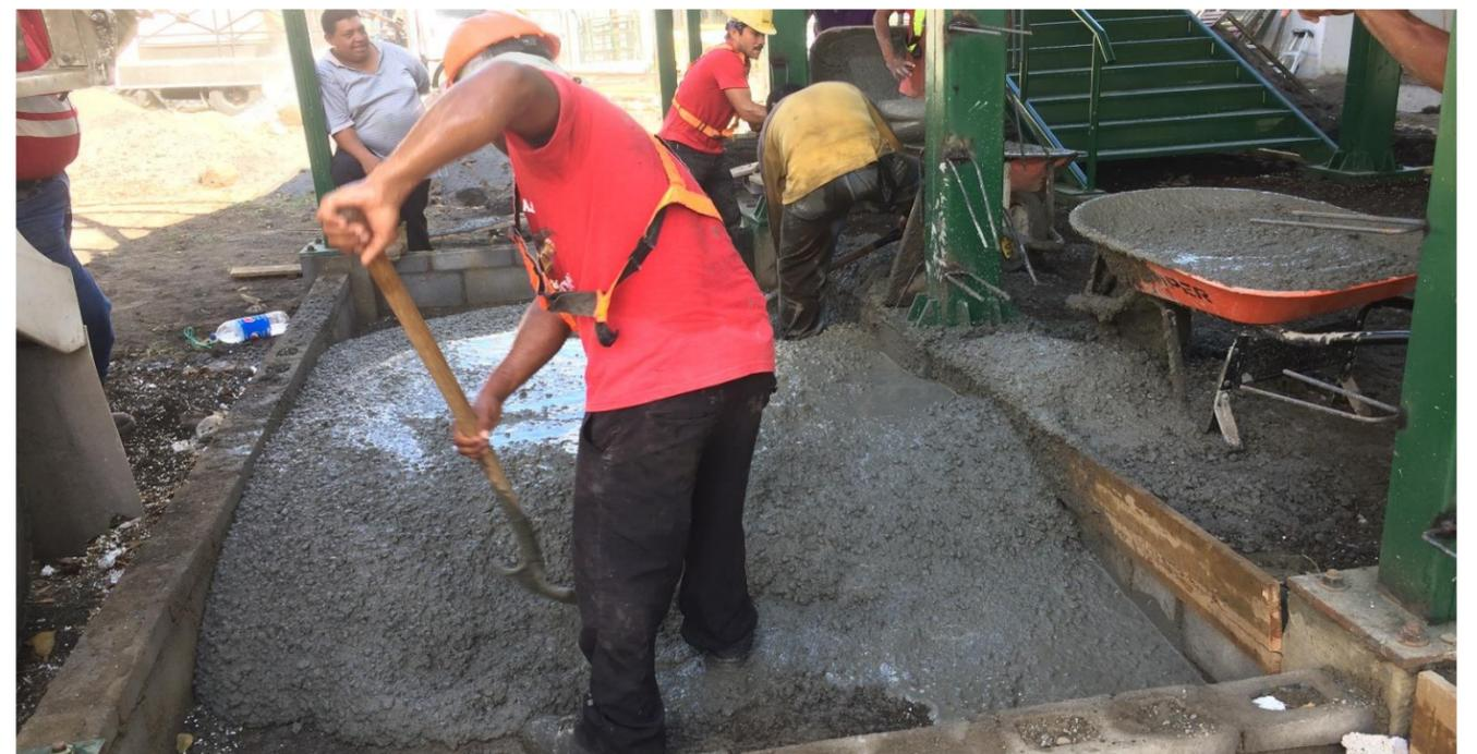
**IMAGEN No. 154** Concreto estructural 2500 Psi. Traslado de concreto. Fuente: Autor.
