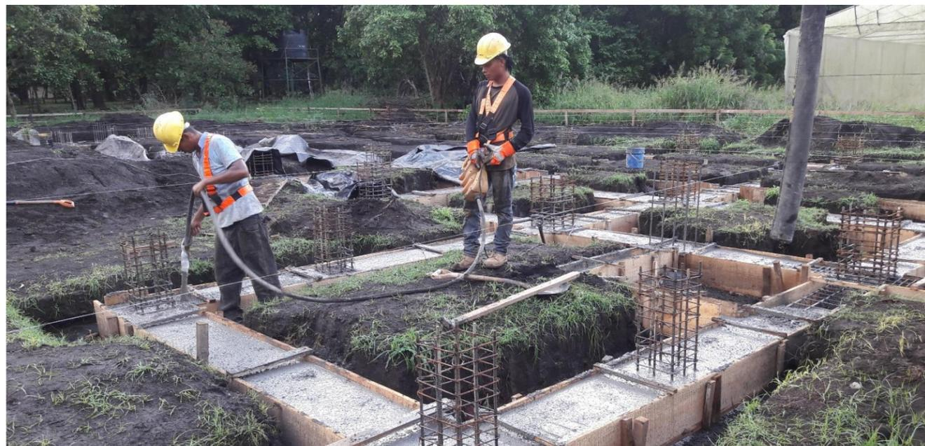
**IMAGEN No. 69** Concreto estructural 3000 Psi. Proceso de vibrado. Fuente: Autor.
