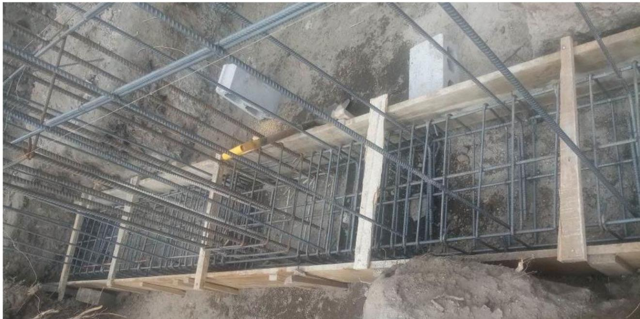
**IMAGEN No. 206** Armado de hierro. instalación de viga asísmica con bastones para mampostería. Fuente: Autor
