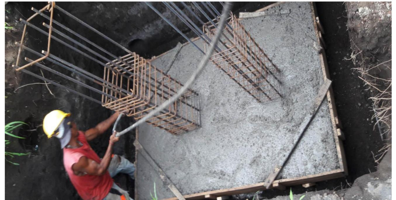
**IMAGEN No. 35** Concreto estructural 3000 psi. Vibrado de concreto. Fuente: Autor.
