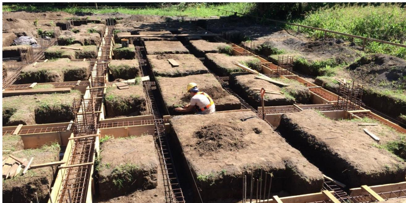
**IMAGEN No. 62** Formaletas. Colocación de formaletas para viga asísmica, VA-1. Fuente: Autor.
