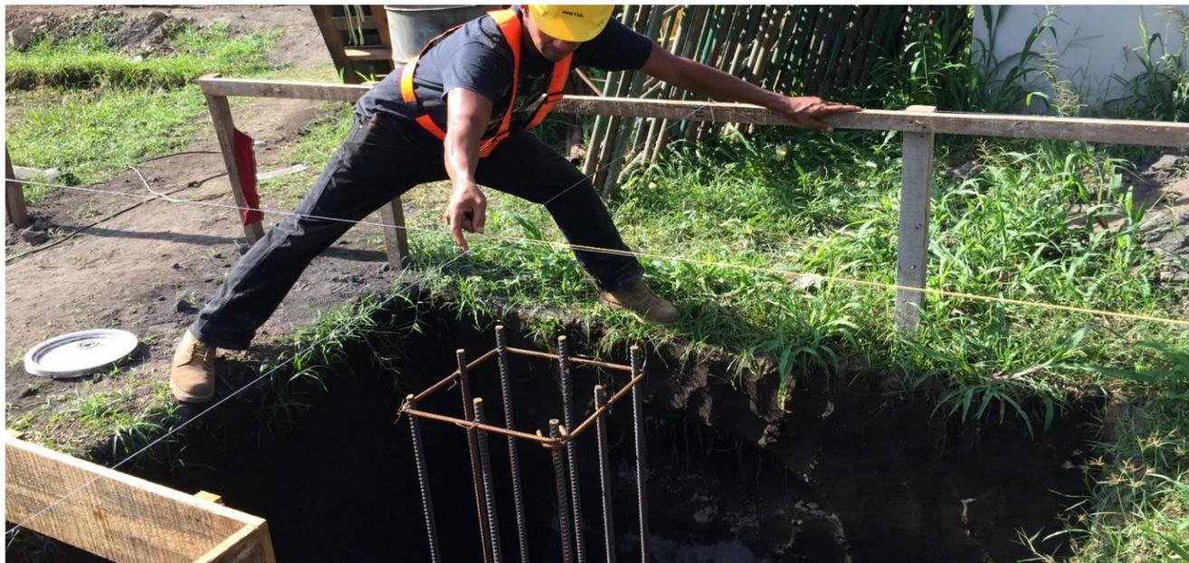
**IMAGEN No. 27** Armado de hierro. centralización de fundaciones. Fuente: Autor.
