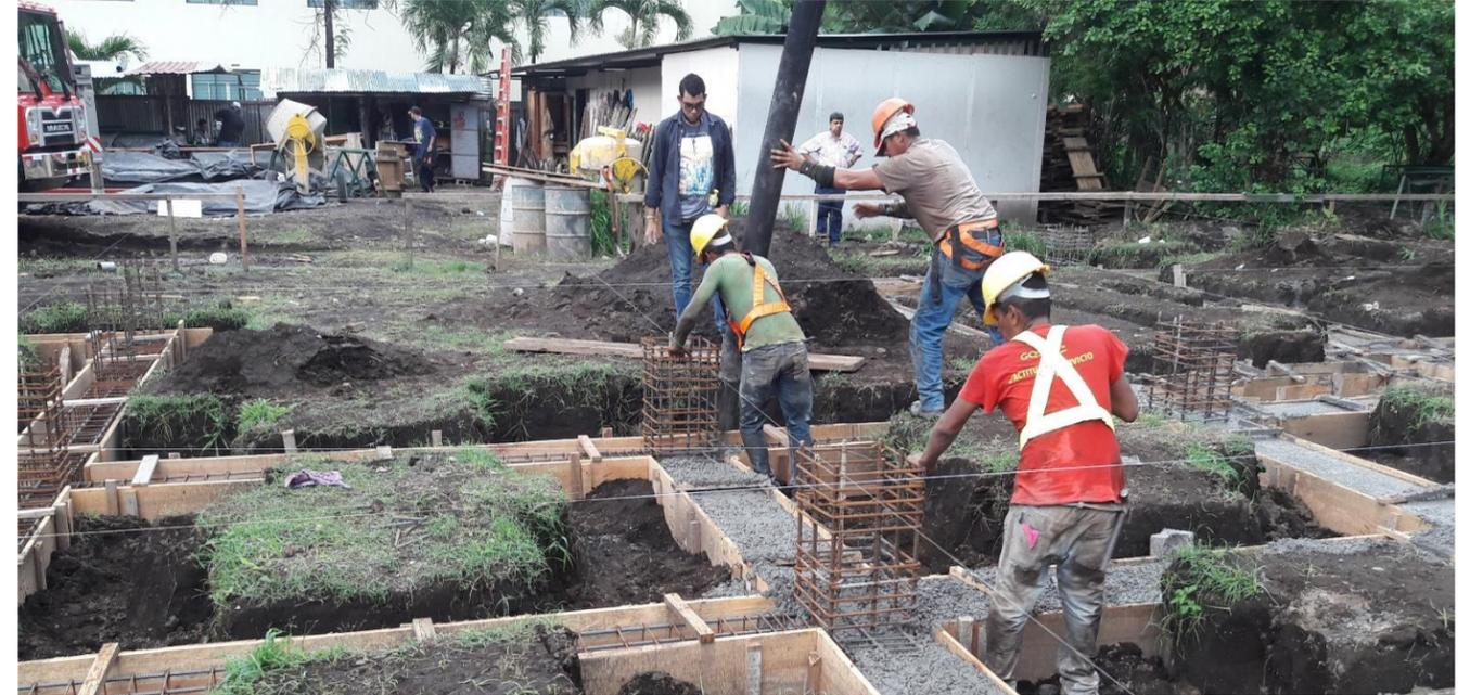
**IMAGEN No. 72** Concreto estructural 3000 Psi. Autor haciendo revisión de llena de viga asísmica y proceso de vibrado. Fuente: Autor.
