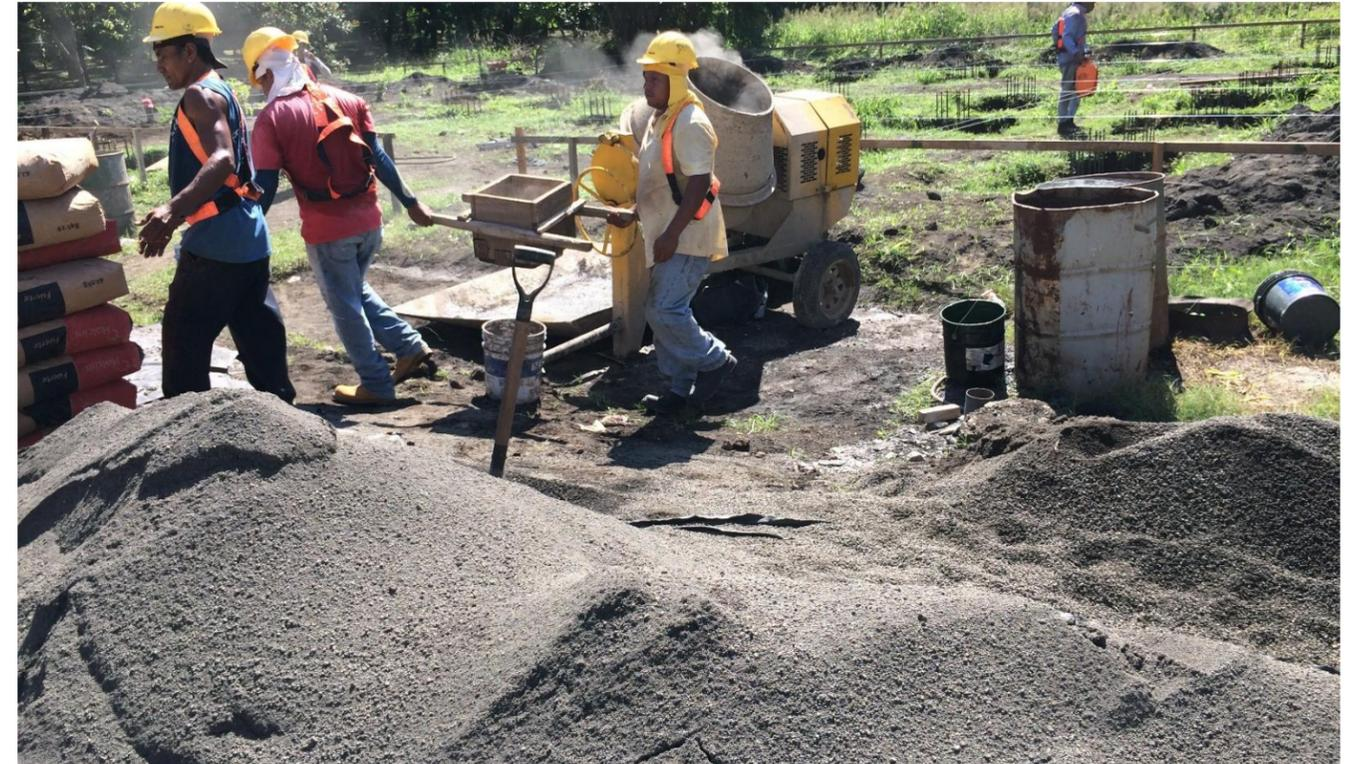
IMAGEN No. 48 Concreto Estructural 3000 Psi. Proceso de mezclado. Fuente: Autor.
