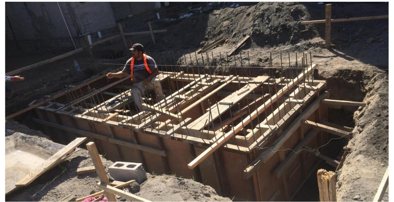
IMAGEN No. 149 Séptico. Formaleta de pozo séptico. Fuente: Autor
