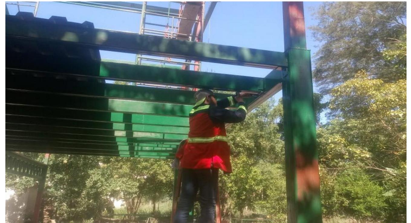
**IMAGEN No. 106** Acero de refuerzo. Revisión de Angulares en vigas. Fuente: Autor.
