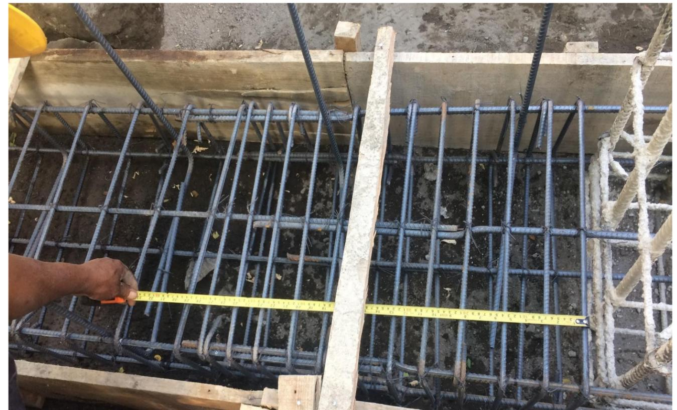
**IMAGEN No. 54** Armado de hierro. Chequeo de espaciamiento de estribos. Fuente: Autor.
