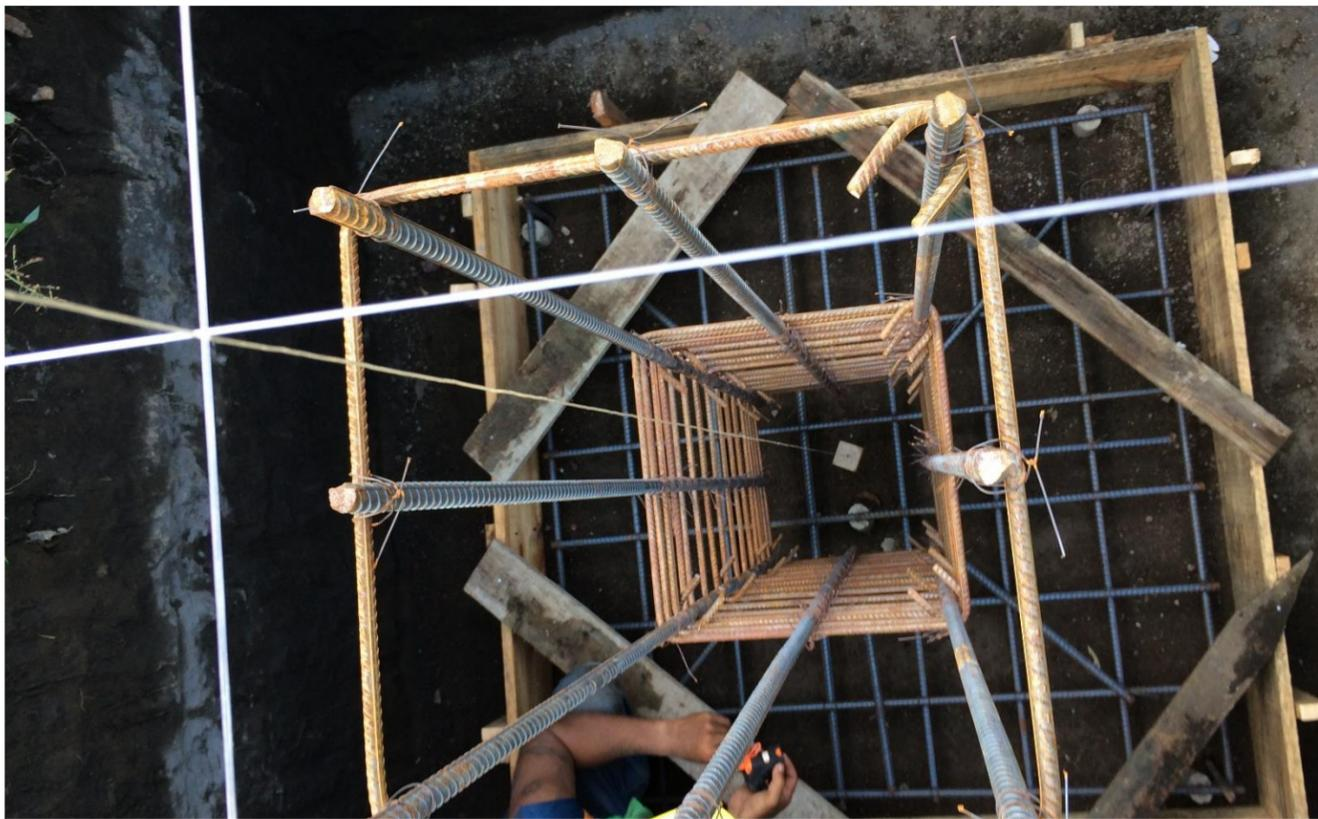
**IMAGEN No. 29** Formaletas. colocación y centralización de formaletas. Fuente: Autor.
