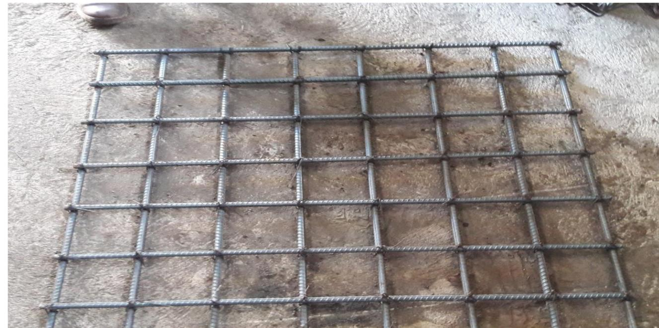
**IMAGEN No. 26** Armado de hierro y acero de refuerzo. Parrilla de zapata. Fuente: Autor.
