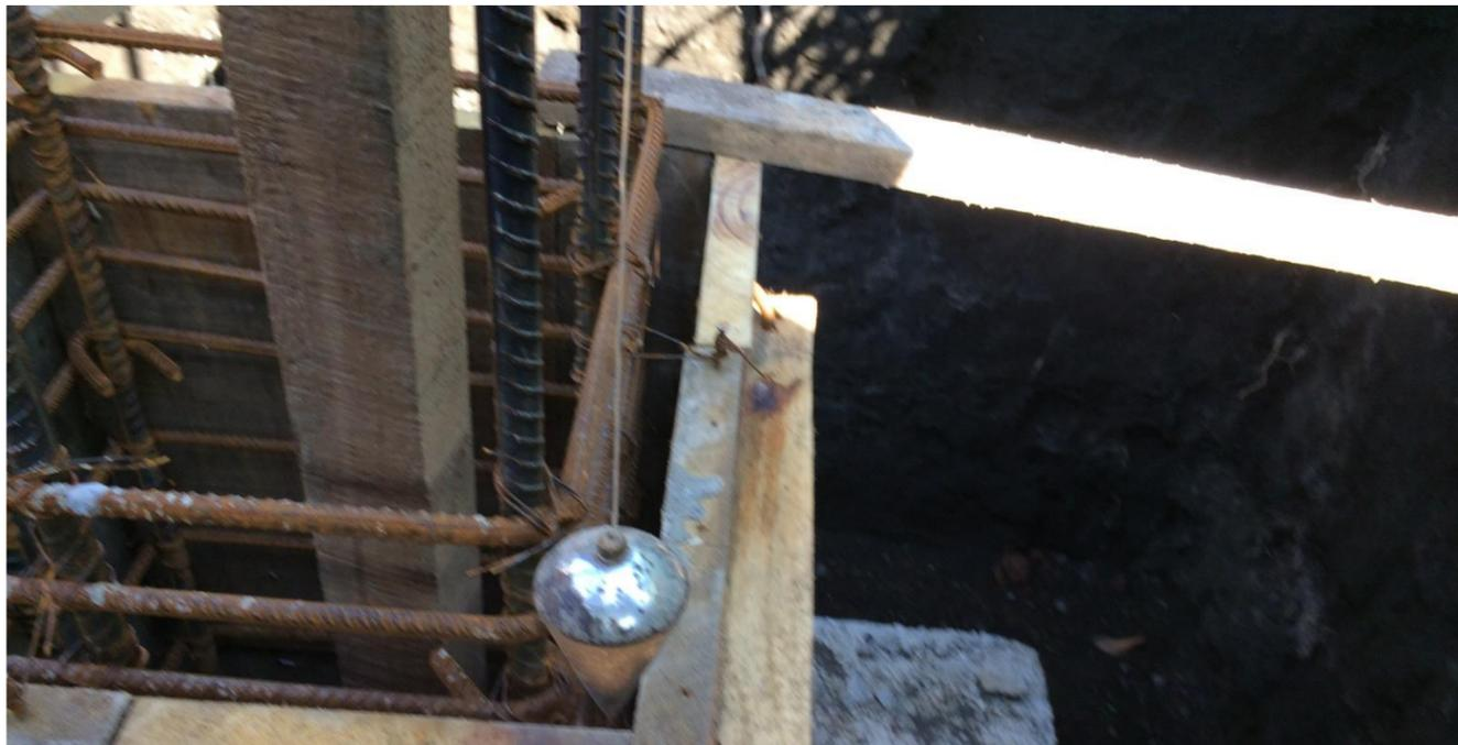
**IMAGEN No. 31** Colocación y centralización de formaleta. Fuente: Autor.
