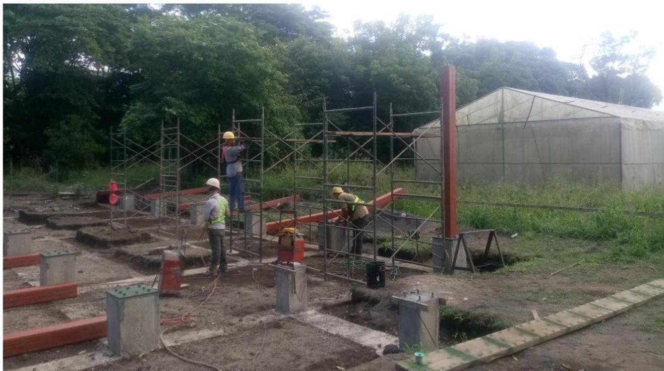
IMAGEN No. 97 Estructura metálica. Colocación de columnas metálicas. Fuente: Autor.
