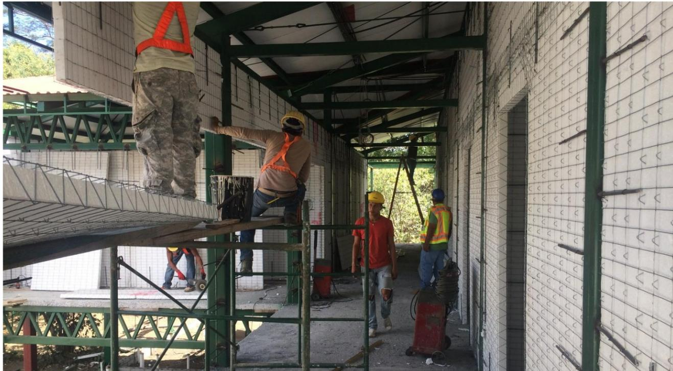
**IMAGEN No. 174** Paredes de covintec. Instalación de paneles. Fuente: Autor
