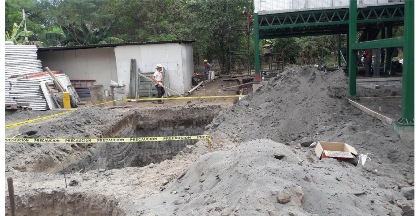
IMAGEN No. 147 Pozo séptico: Excavación pozo. Fuente: Autor
