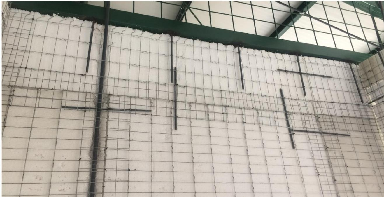
**IMAGEN No. 166** Paredes de covintec. unión entre paneles. Fuente: Autor.
