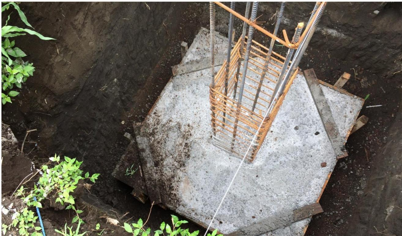
**IMAGEN No. 39** Desencofrado. Zapata Z1 momento previo al desencofrado. Fuente: Autor.
