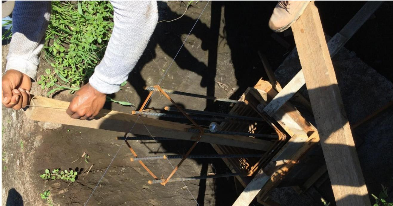
**IMAGEN No. 46** Formaletas. Nivelación a plomo de formaleta para zapata Z-1 Fuente: Autor.
