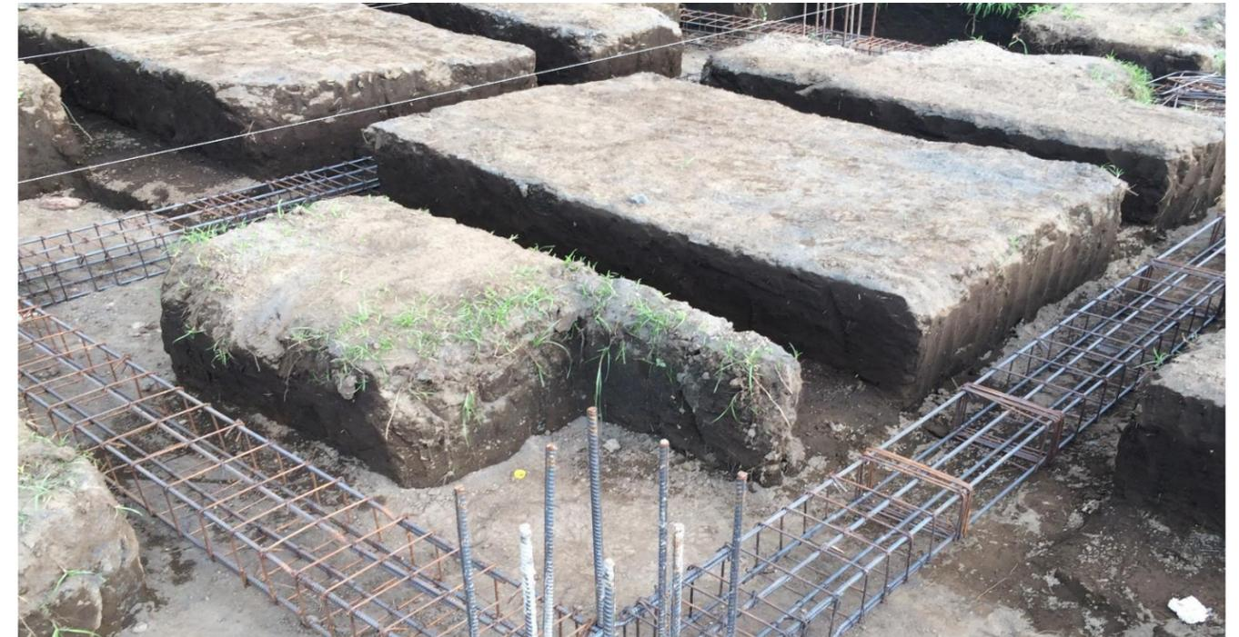
**IMAGEN No. 60** Movimiento de tierra. Excavaciones para viga asísmica VA2. Fuente: Autor.
