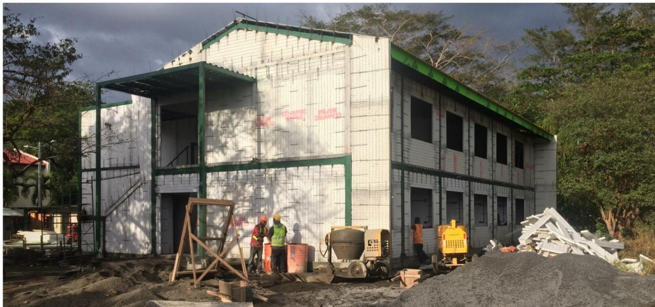
**IMAGEN No. 173** Paredes de covintec. Perspectiva frontal con paneles instalados. Fuente: Autor.
