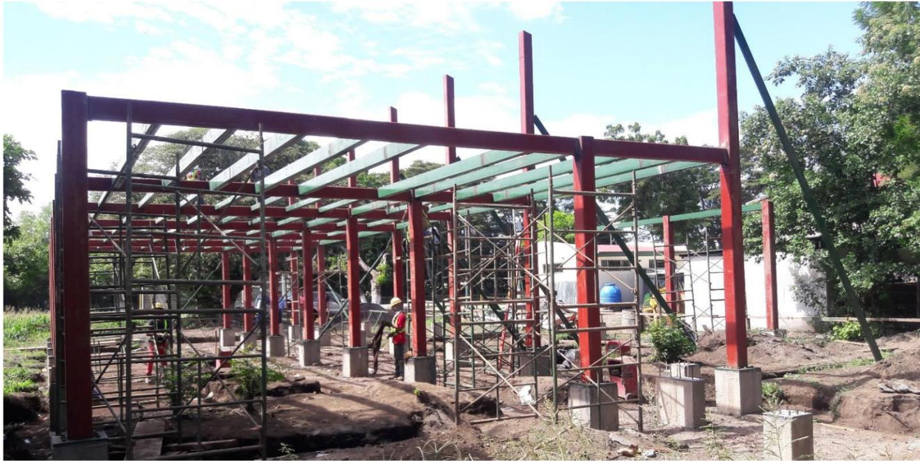
**IMAGEN No. 102** Estructura metálica. Colocación de columnas metálicas. Fuente: Autor.
