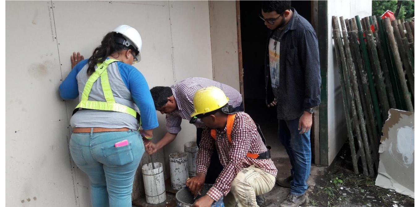
**IMAGEN No. 36** Concreto estructural 3000 psi, llena de cilindro para prueba de resistencia. Fuente: Autor.
