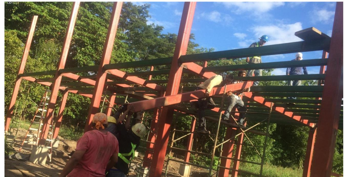
IMAGEN No. 98 Estructura metálica. Colocación de columnas metálicas. Fuente: Autor.
