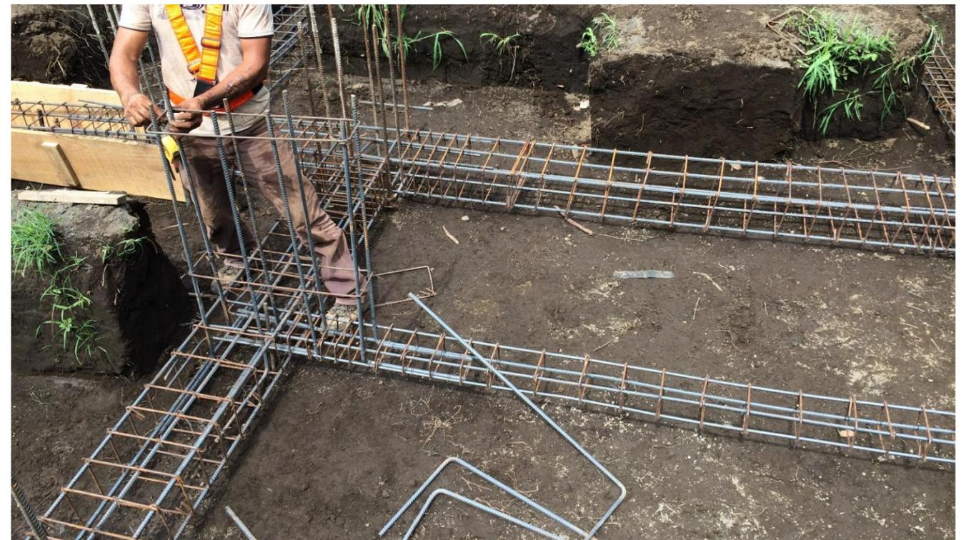
**IMAGEN No. 57** Armado de hierro. Colocación de estribos en zapata Z-4 Fuente: Autor..
