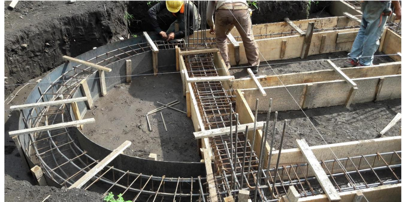
**IMAGEN No. 61** Formaletas. Colocación de formaletas para viga asísmica VA-1 semi circular. Fuente: Autor.
