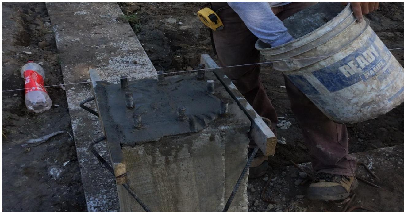
**IMAGEN No. 86** Concreto epóxico. Colocación de concreto epóxico. Fuente: Autor.
