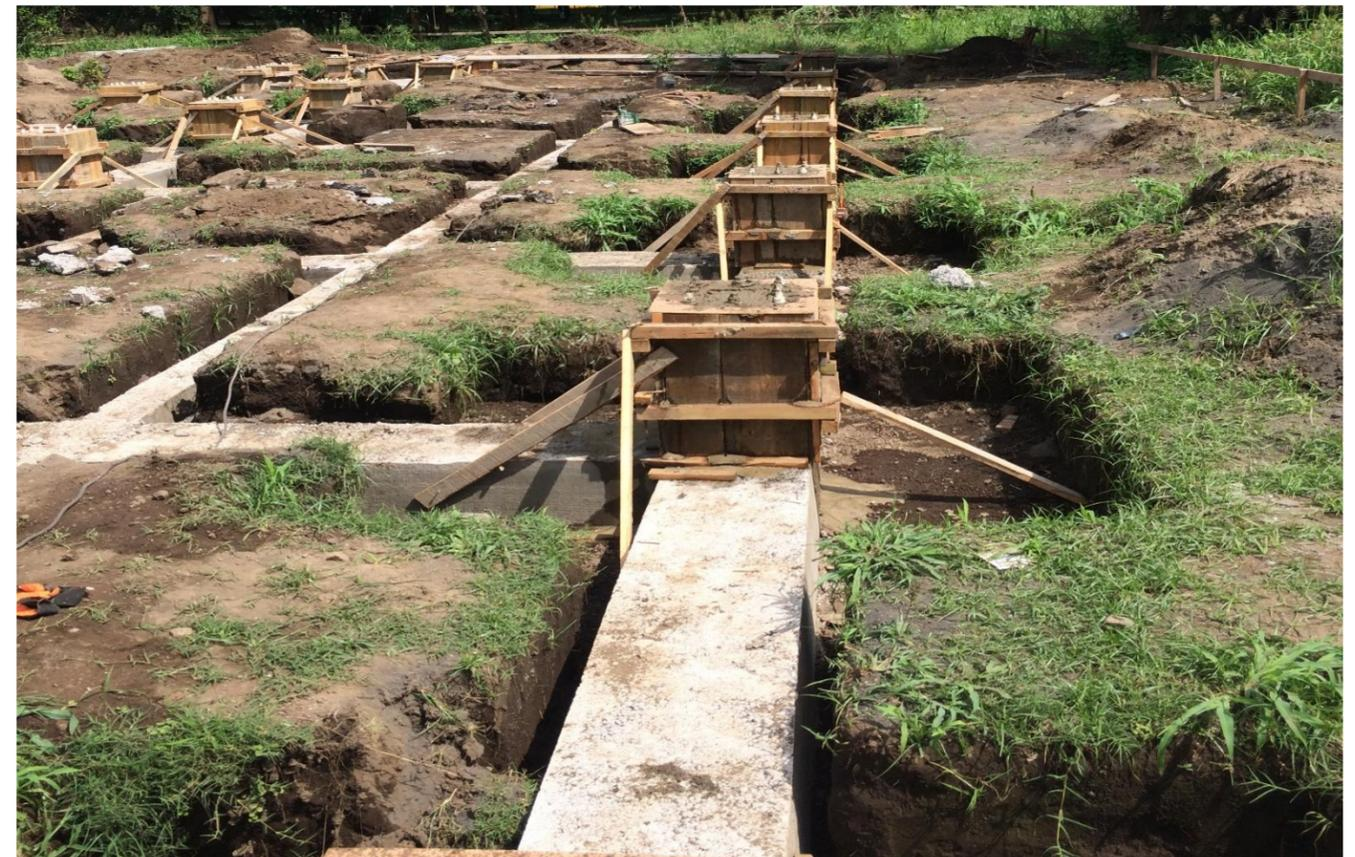
**IMAGEN No. 81** Concreto estructural 3000 Psi. Llena de pedestal PD-1. Fuente: Autor.
