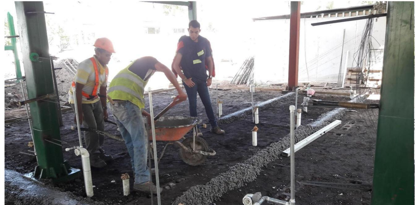
**IMAGEN No. 152** Concreto estructural 2500 Psi. Autor haciendo revisión de nivelado de concreto para losa de piso. Fuente: Autor.
