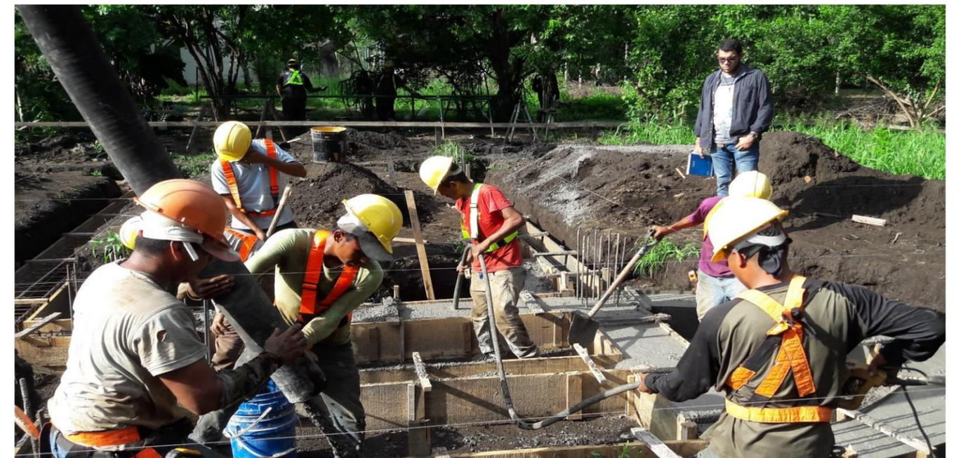
**IMAGEN No. 64** Concreto estructural 3000 Psi. Autor en revisión de llena de viga asísmica Fuente: Autor.
