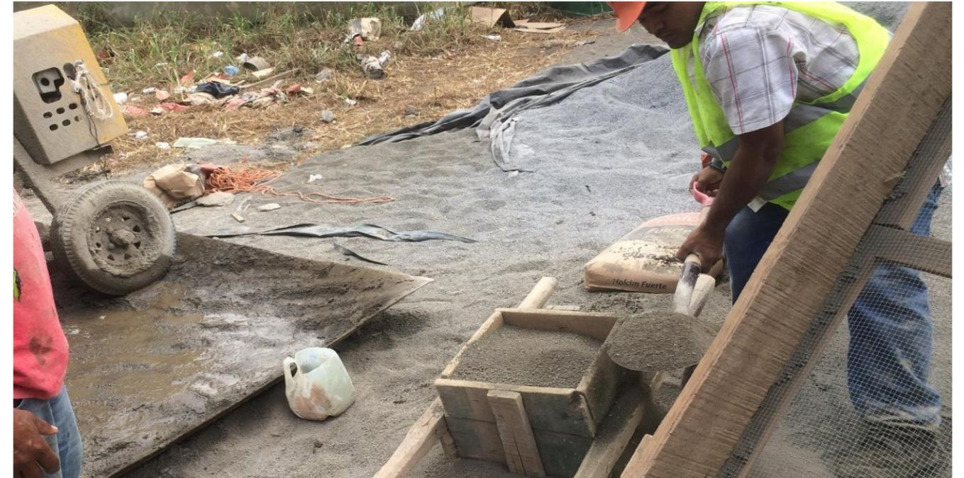
**IMAGEN No. 176** Paredes de covintec. Mezcla de mortero para chilatear. Fuente: Autor.
