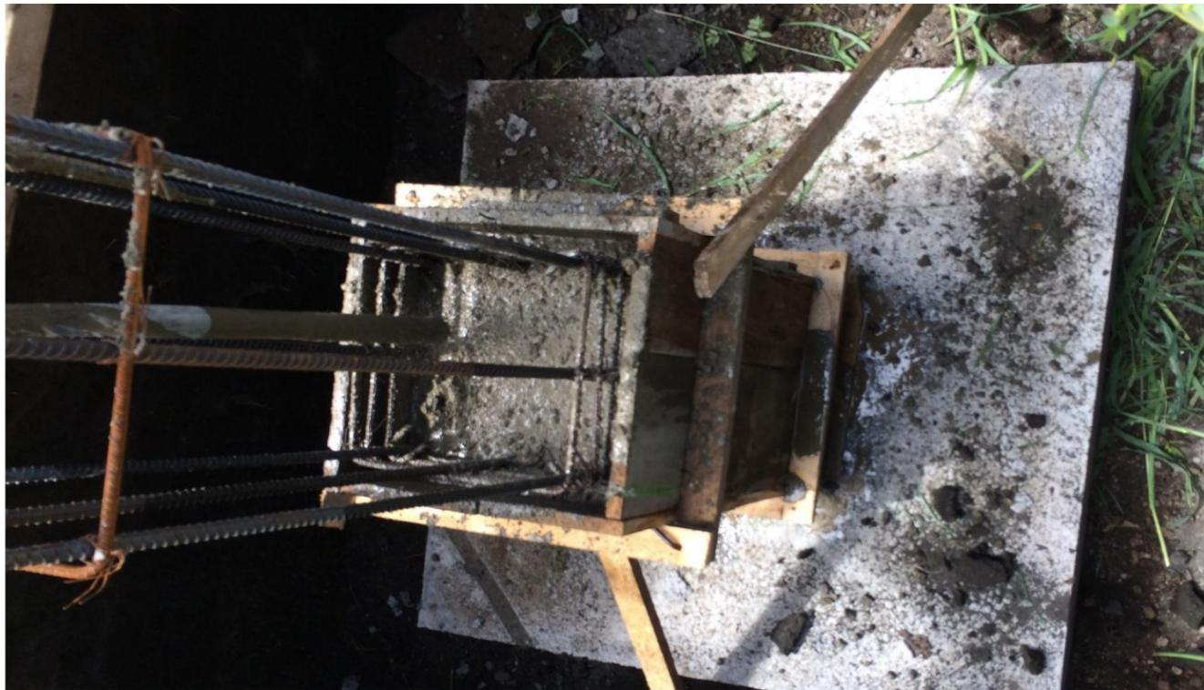
**IMAGEN No. 50** Concreto Estructural 3000 Psi. Llena de dado de cimentación. Fuente: Autor.
