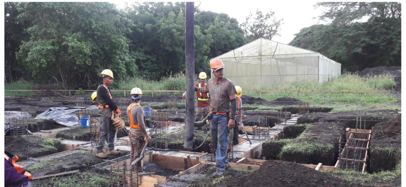
**IMAGEN No. 74** Concreto estructural 3000 Psi. Autor haciendo revisión de llena de viga asísmica y proceso de vibrado. Fuente: Autor.
