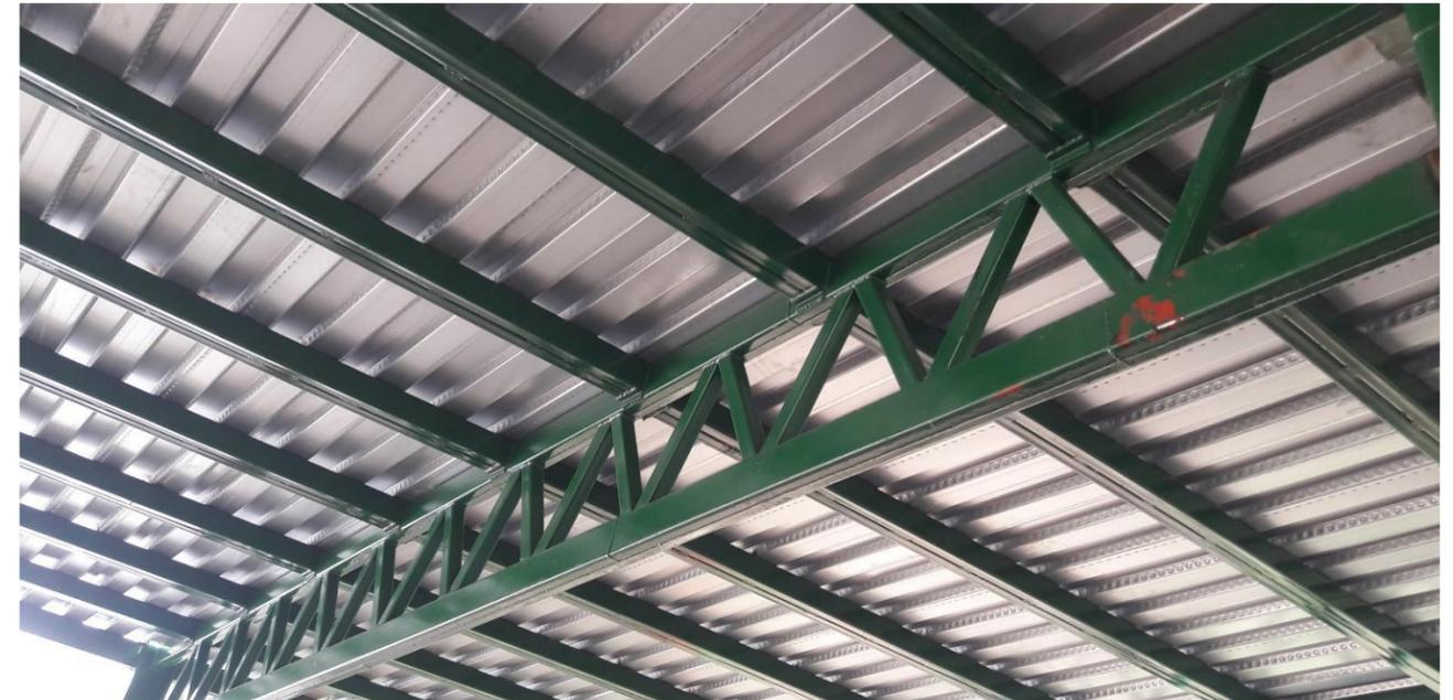
**IMAGEN No. 119** Losa de entrepiso. Cercha metálica cargando estructura de entrepiso. Fuente: Autor
