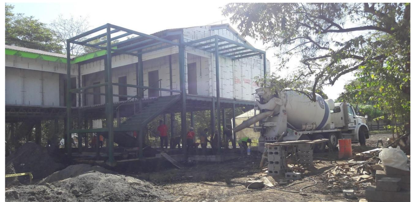
**IMAGEN No. 151** Concreto estructural 2500 Psi. Hormigonera vaciando concreto. Fuente: Autor.
