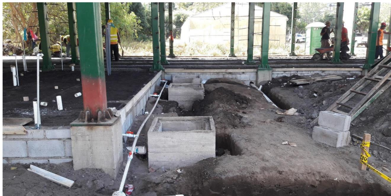
**IMAGEN No. 143** Distribución de agua potable. red de agua potable en primera planta de edificio. Fuente: Autor.
