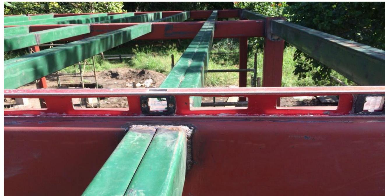
**IMAGEN No. 99** Estructura metálica. Revisión de nivel de vigas de entrepiso. Fuente: Autor.
