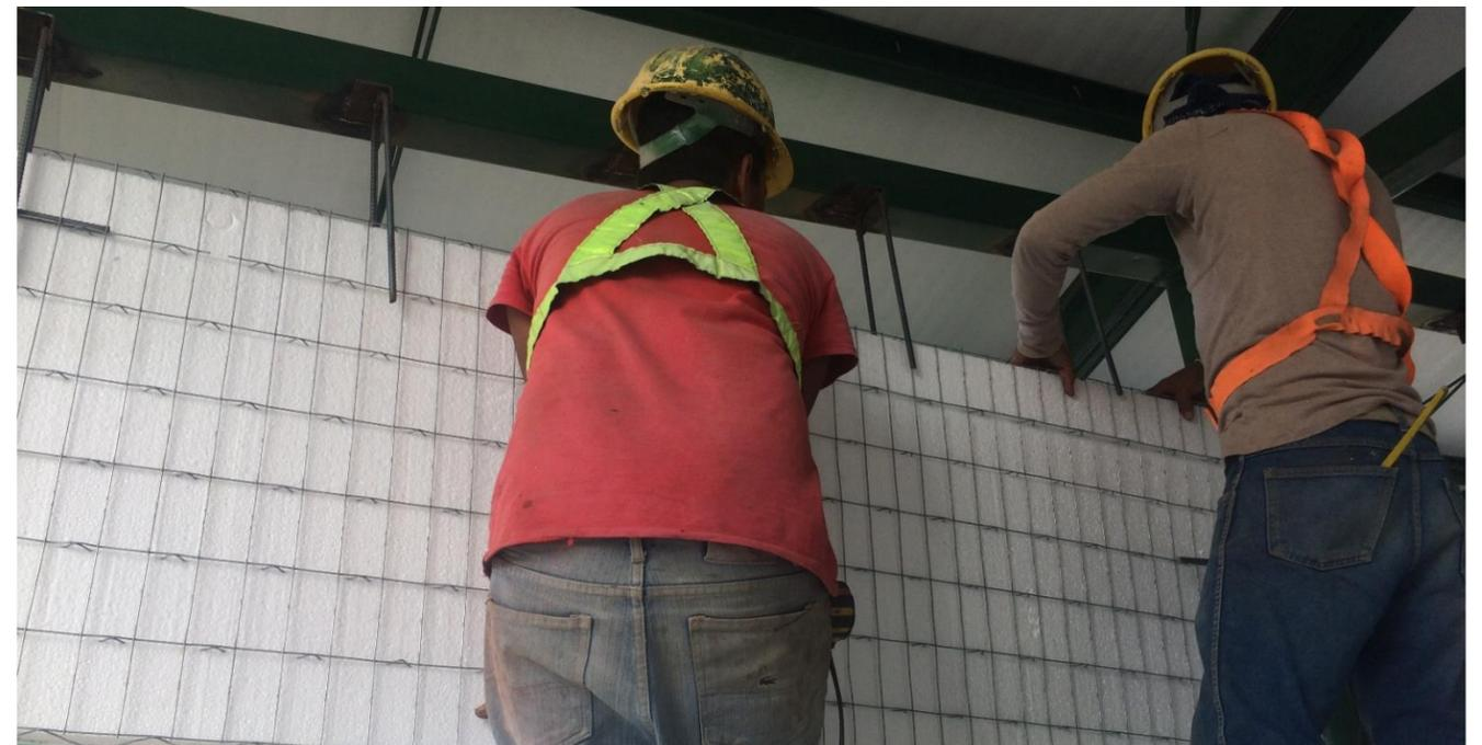
**IMAGEN No. 163** Paredes de covintec. Instalación de paneles. Fuente: Autor.
