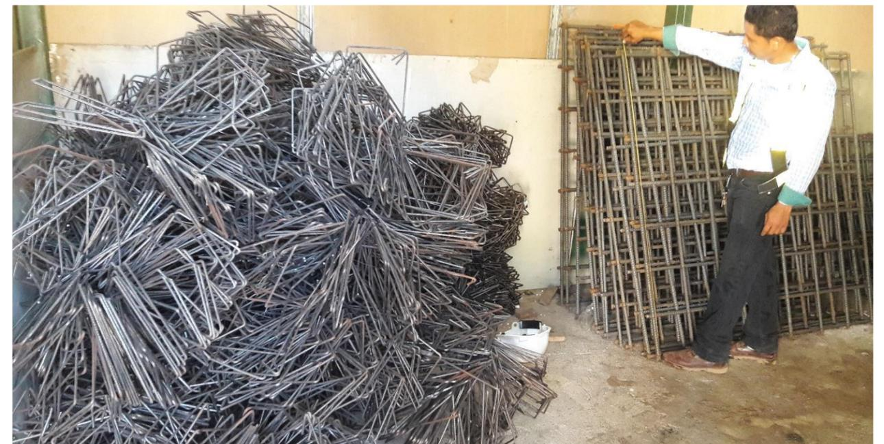
**IMAGEN No. 24** Armado de hierro y acero de refuerzo. Almacenamiento de estribos y parrillas de zapatas. Fuente: Autor.
