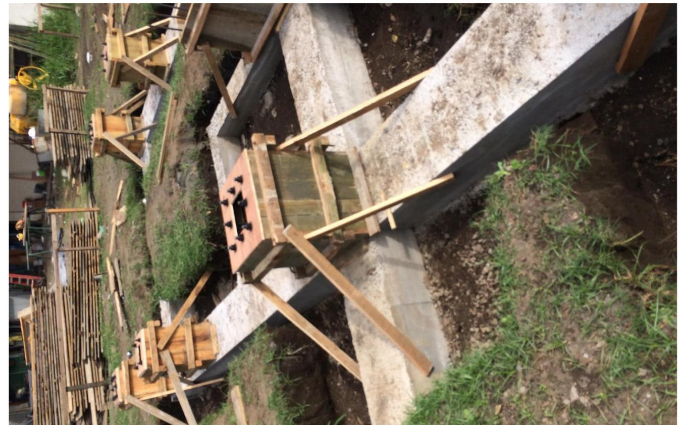
**IMAGEN No. 78** Formaletas de pedestales. PD-1 y tapa superior con pernos. Fuente: Autor.
