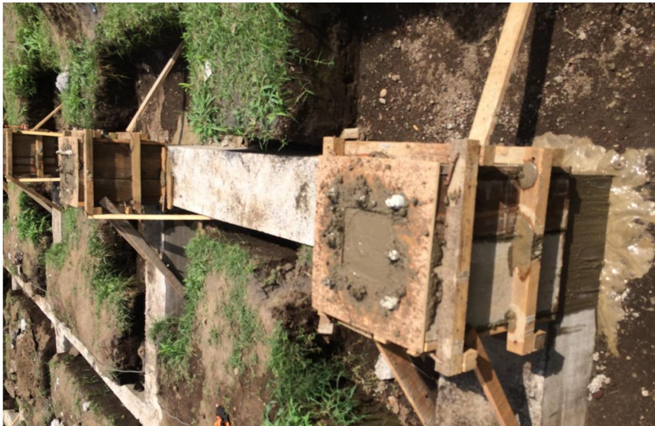
**IMAGEN No. 82** Concreto estructural 3000 Psi. Llena de pedestal PD-1. Fuente: Autor.
