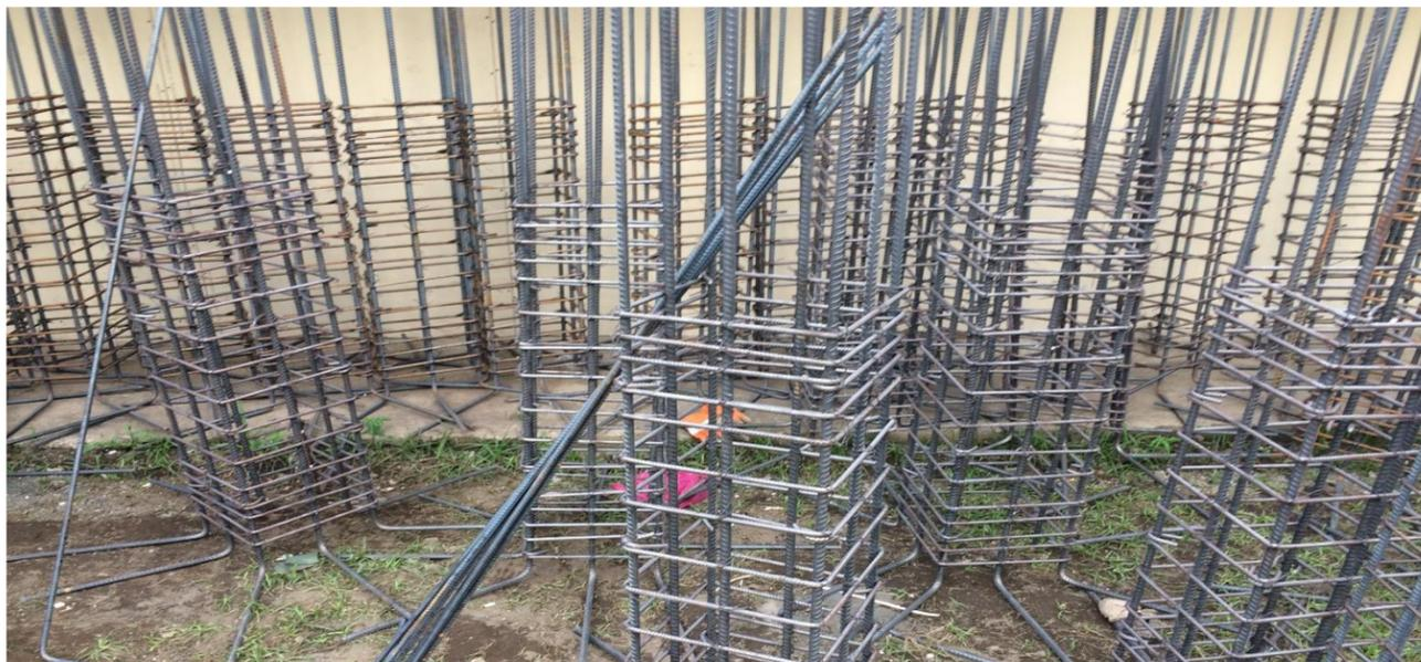
**IMAGEN No. 21** Armado de hierro. almacenamiento de hierro para zapatas. Fuente: Autor.
