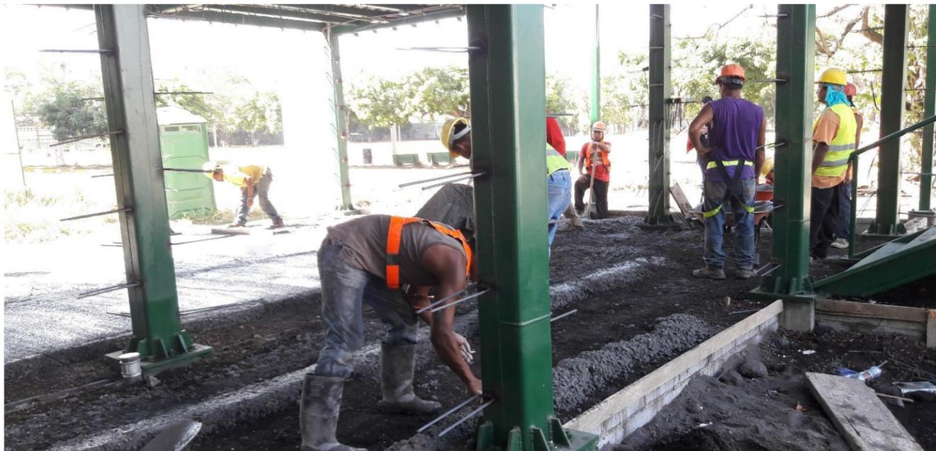
**IMAGEN No. 157** Concreto estructural 2500 Psi. Nivelado de concreto con mairras.
