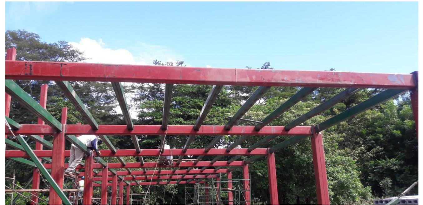
**IMAGEN No. 101** Estructura metálica. Colocación de columnas metálicas. Fuente: Autor.
