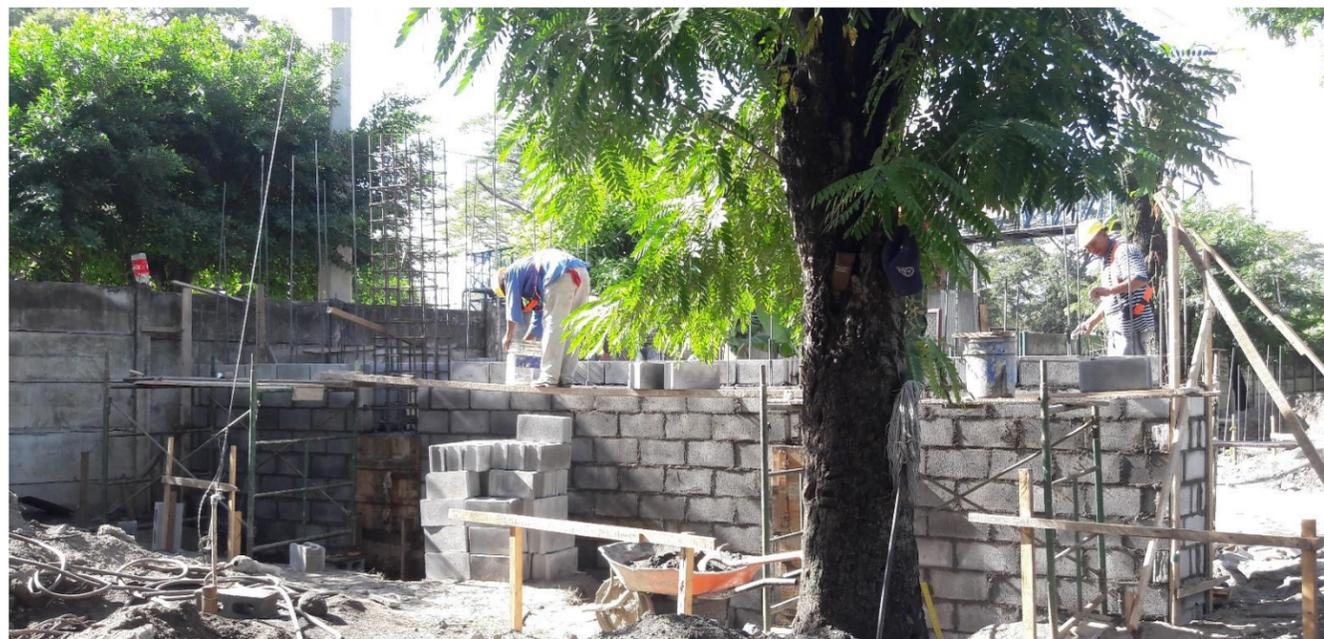
**IMAGEN No. 210** Paredes de mampostería reforzada. Construcción de paredes estructurales. Fuente: Autor.
