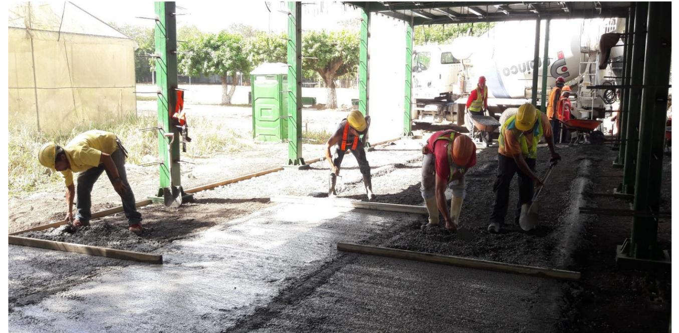
**IMAGEN No. 158** Concreto estructural 2500 Psi. Nivelado de concreto con mairras.
