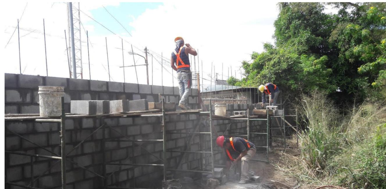
**IMAGEN No. 223** Paredes de mampostería. Construcción de paredes de mampostería con bastones instalados. Fuente: Autor.
