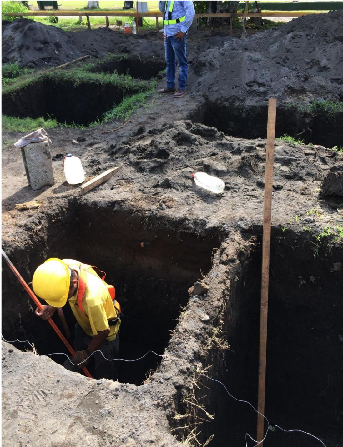
**IMAGEN No. 9** Movimiento de tierra. Excavación para zapatas. Fuente: Autor.
