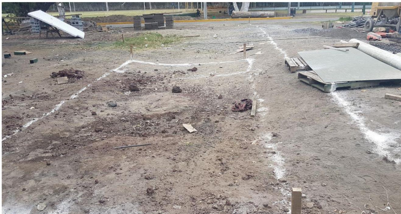
IMAGEN No. 148 Pozo séptico. Trazado de área. Fuente: Autor
