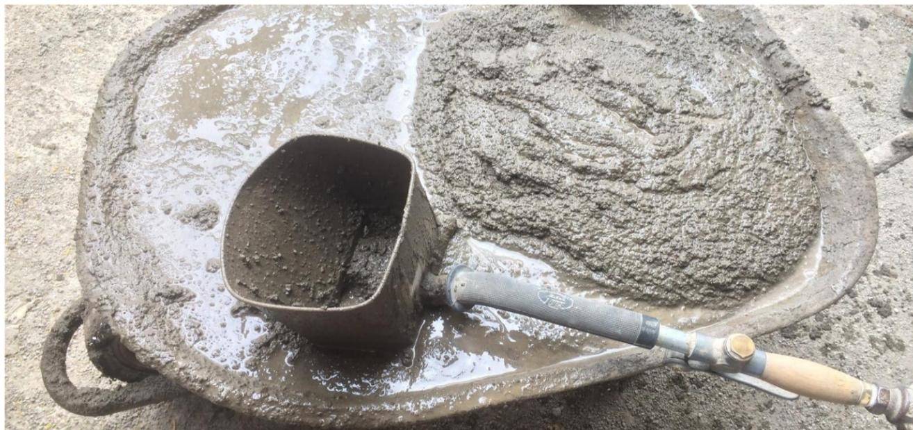
**IMAGEN No. 177** Paredes de covintec. Mezcla de mortero para chilatear. Fuente: Autor
