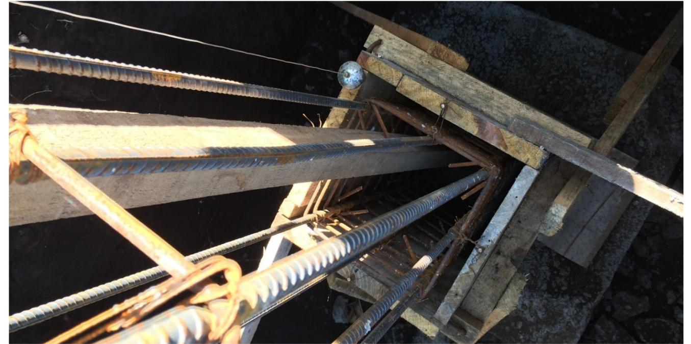
**IMAGEN No. 43** Formaletas. Nivelación a plomo de formaletas para zapata Z-1 Fuente: Autor.
