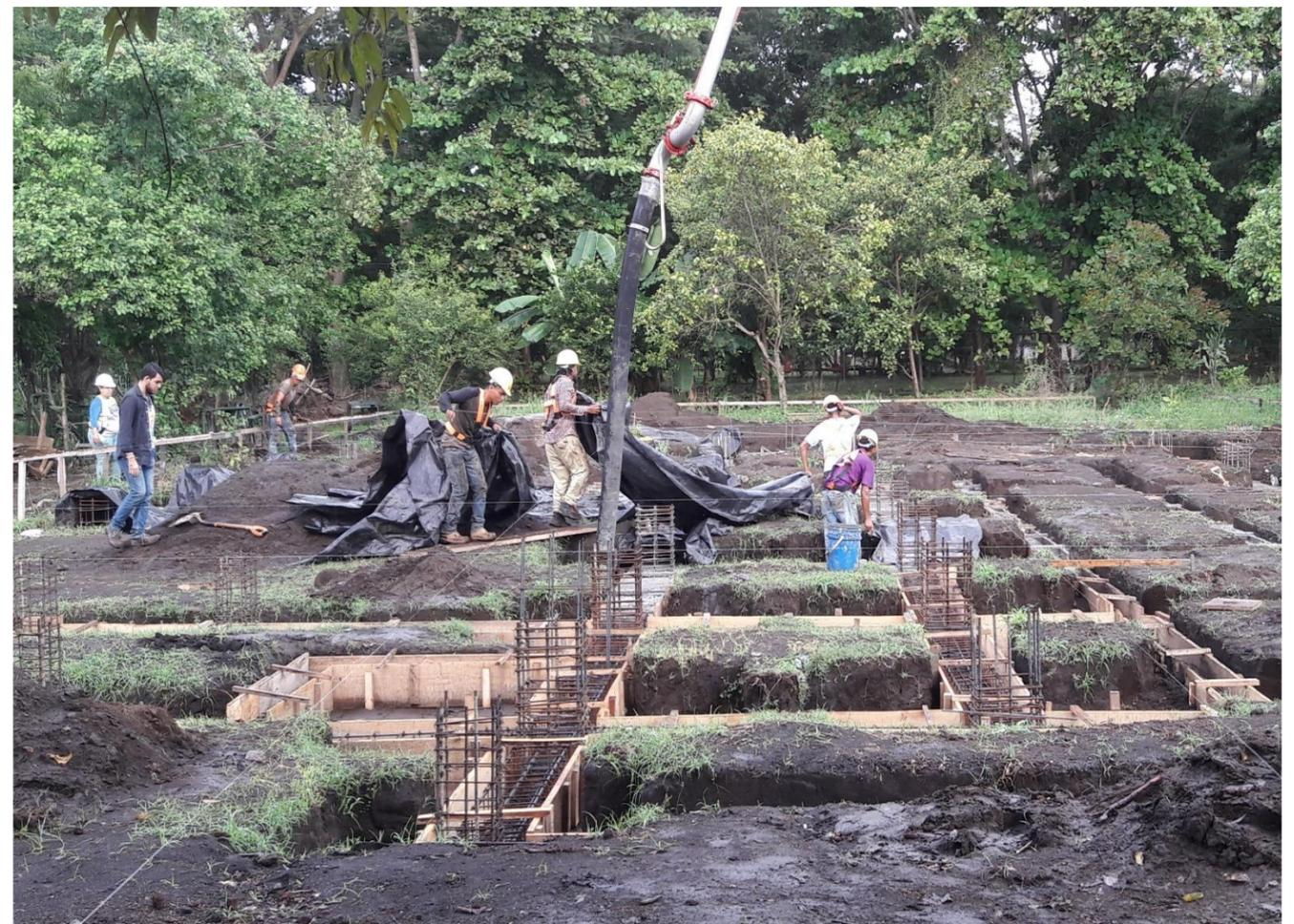
**IMAGEN No. 66** Concreto estructural 3000 Psi. Autor haciendo revisión de llena de vigas asísmica. Fuente: Autor.
