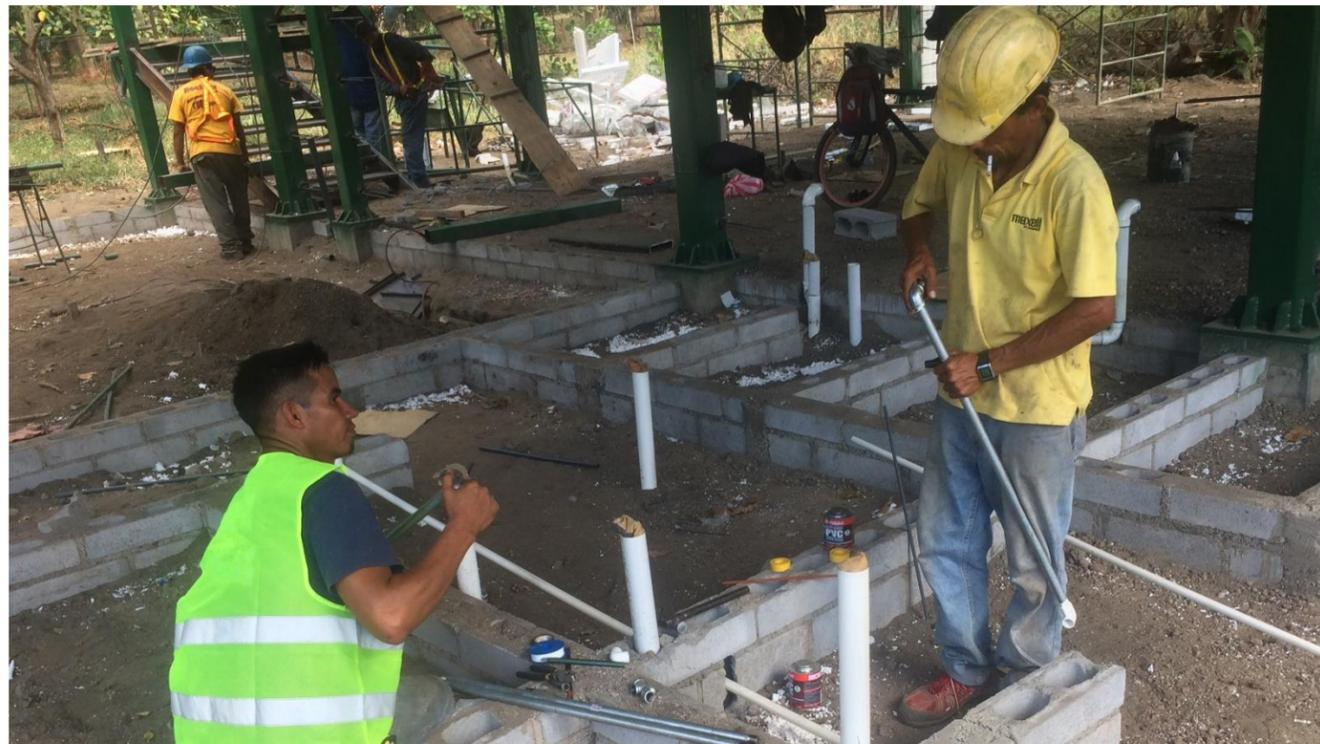
**IMAGEN No. 145** Tubería y accesorios de aguas negras. Instalación de tragantes de inodoro. Fuente: Autor.
