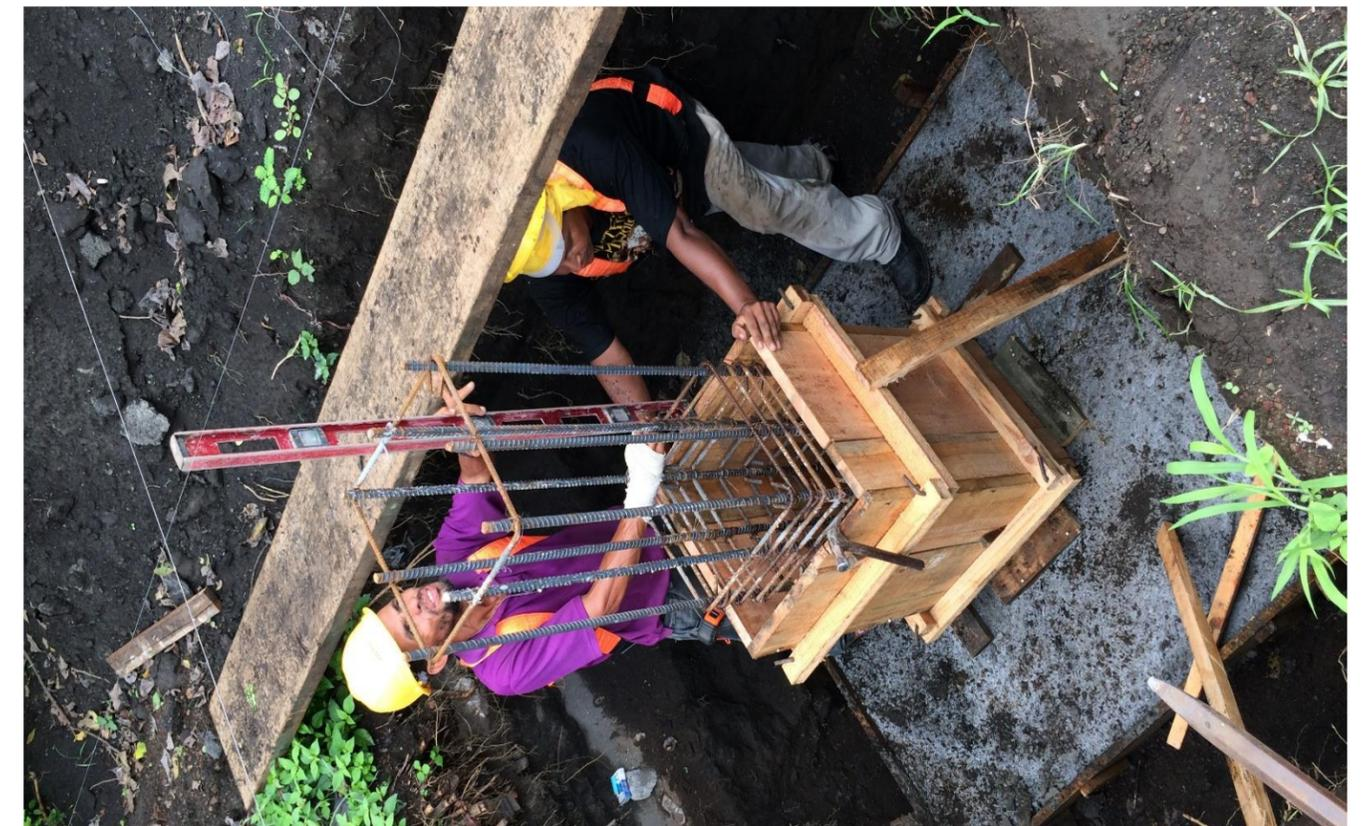
**IMAGEN No. 41** Formaletas. Nivelación de formaleta para zapata Z1. Fuente: Autor.
