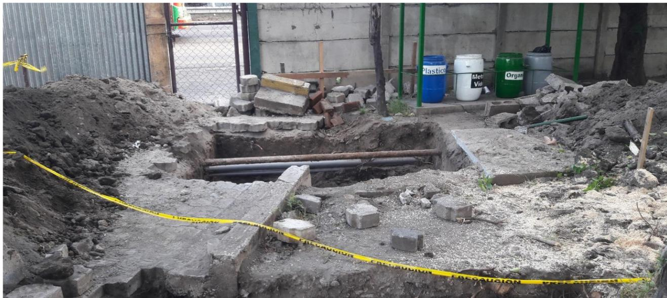
**IMAGEN No. 197** Excavación con tubería de redes expuesta. Fuente: Autor.
