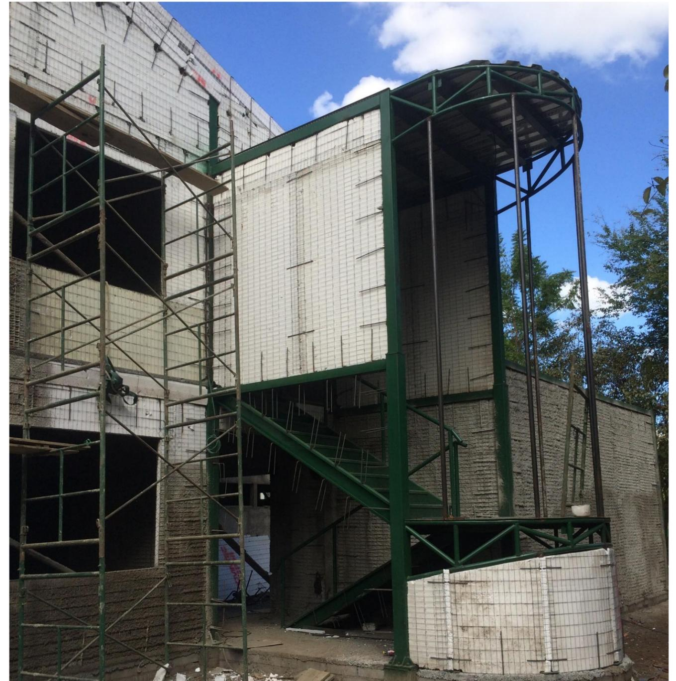
**IMAGEN No. 170** Paredes de covintec. Perspectiva trasera con paneles instalados. Fuente: Autor.
