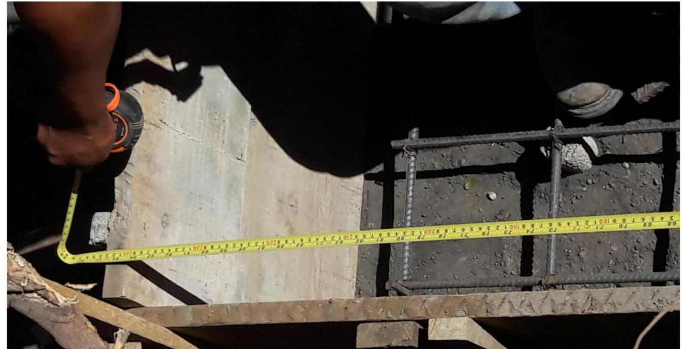
**IMAGEN No. 200** Formaletas. Instalación de formaletas en zapata Z-1 Excavación con tubería de redes expuesta. Fuente: Autor.
