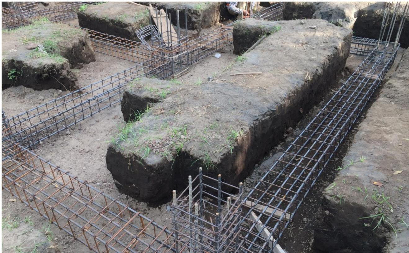
**IMAGEN No. 55** Armado de hierro. armado y colocación de viga asísmica. Fuente: Autor.
