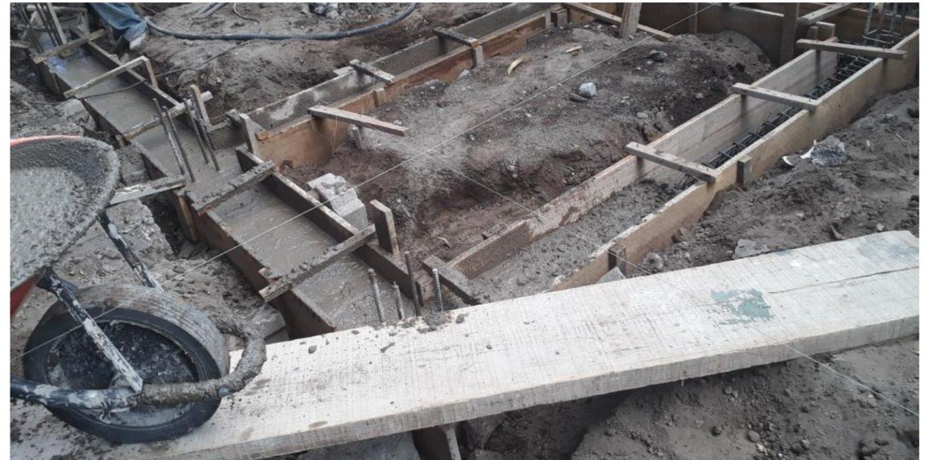
**IMAGEN No. 207** llena de concreto para viga asísmica. Fuente: Autor
