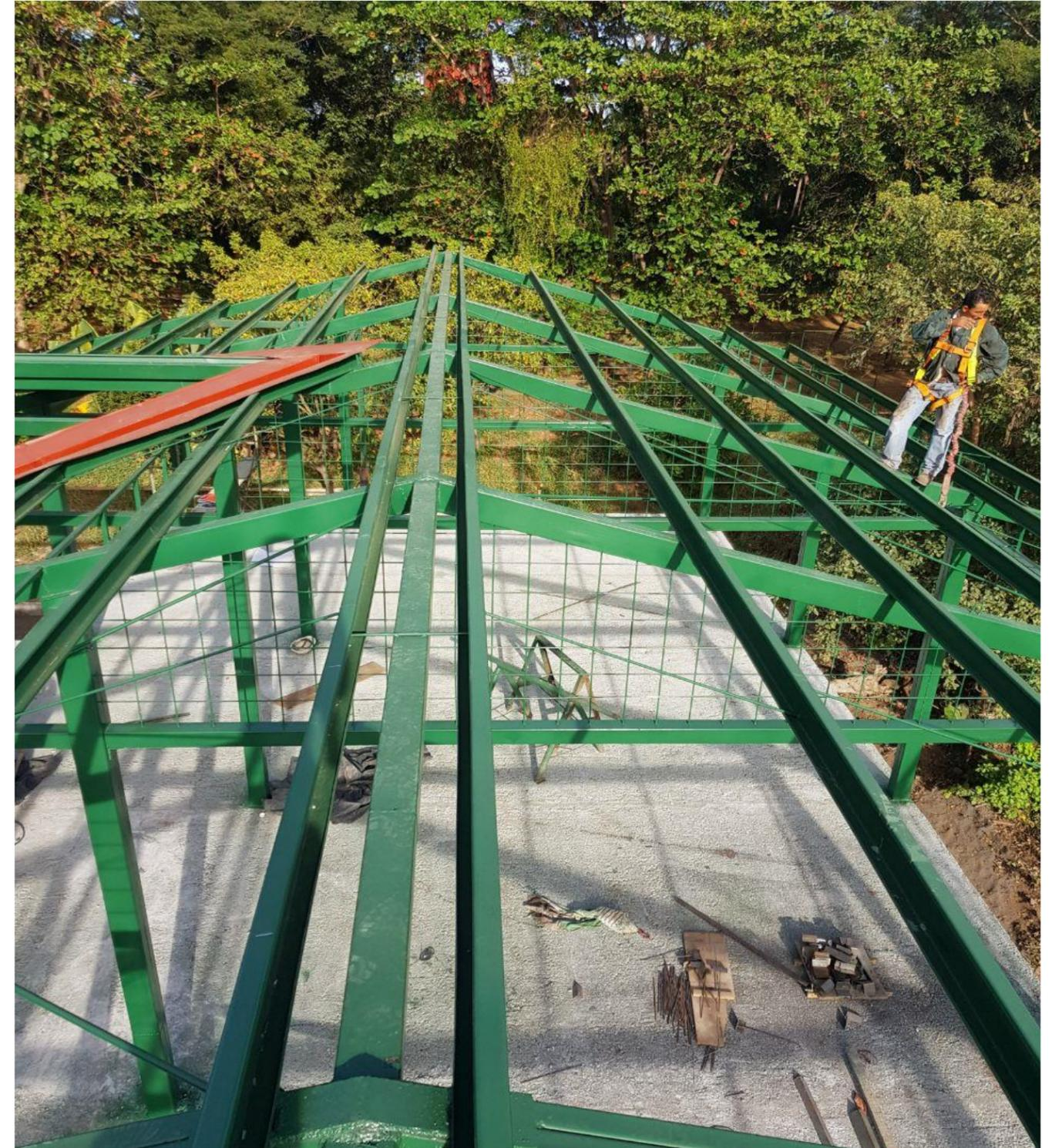
**IMAGEN No. 133** Estructura metálica de techos. Vista aérea de clavadores. Fuente: Autor.
