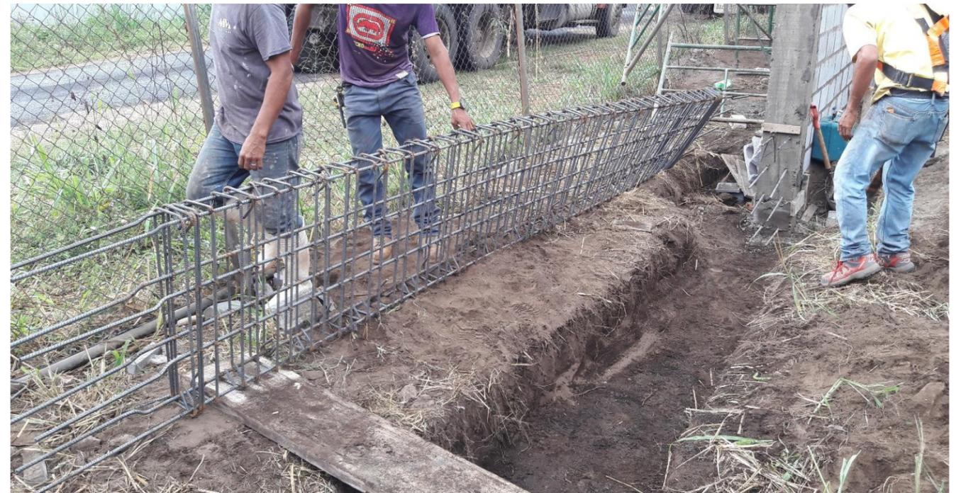
**IMAGEN No. 217** Armado de hierro. Instalación de viga asísmica especial. Fuente: Autor.
