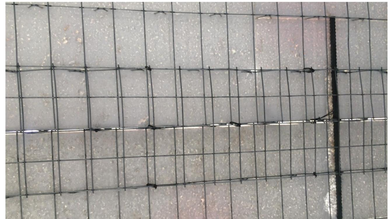
**IMAGEN No. 165** Paredes de covintec. unión entre paneles. Fuente: Autor.
