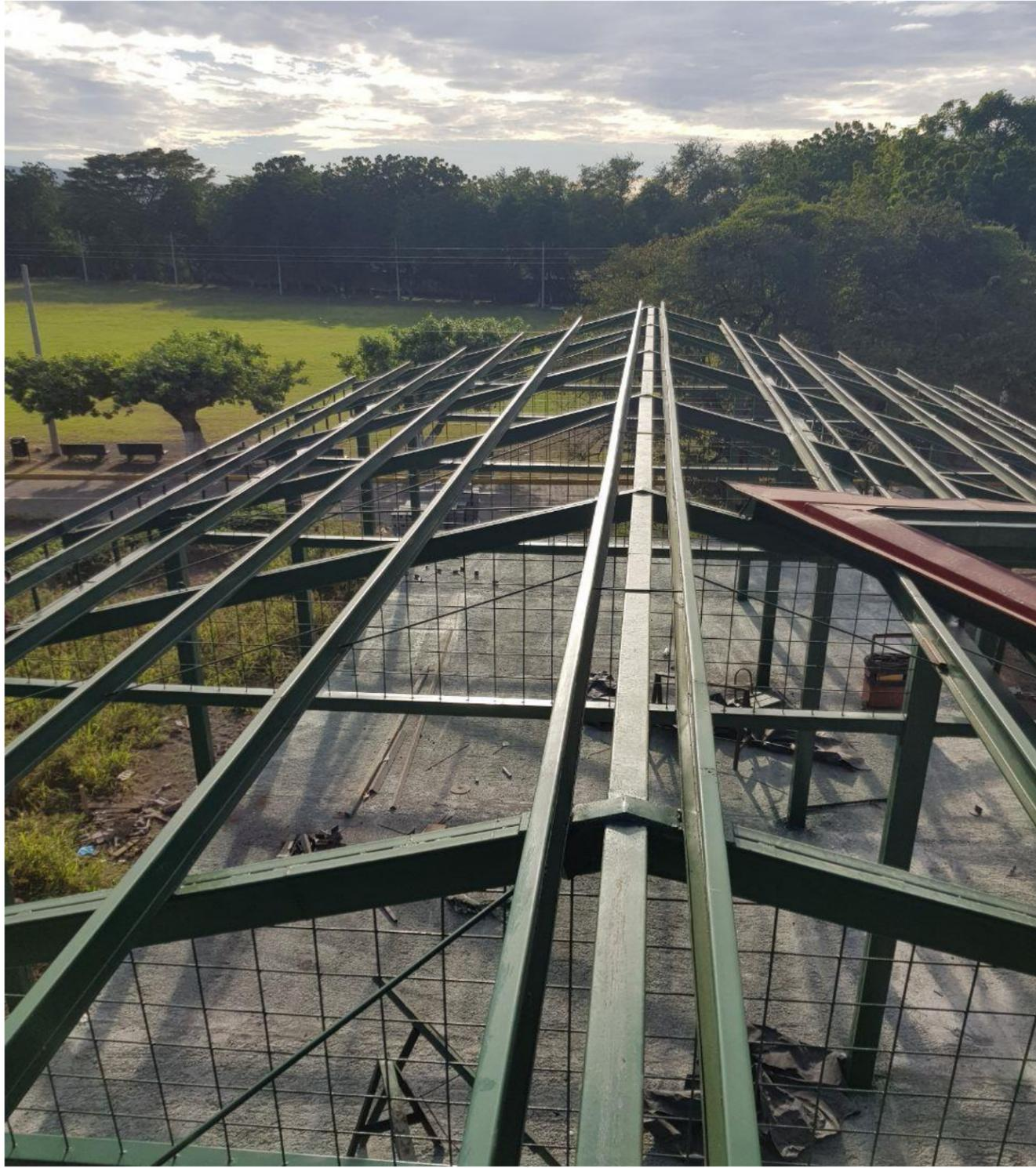
**IMAGEN No. 134** Estructura metálica de techos. Vista aérea de clavadores. Fuente: Autor.
