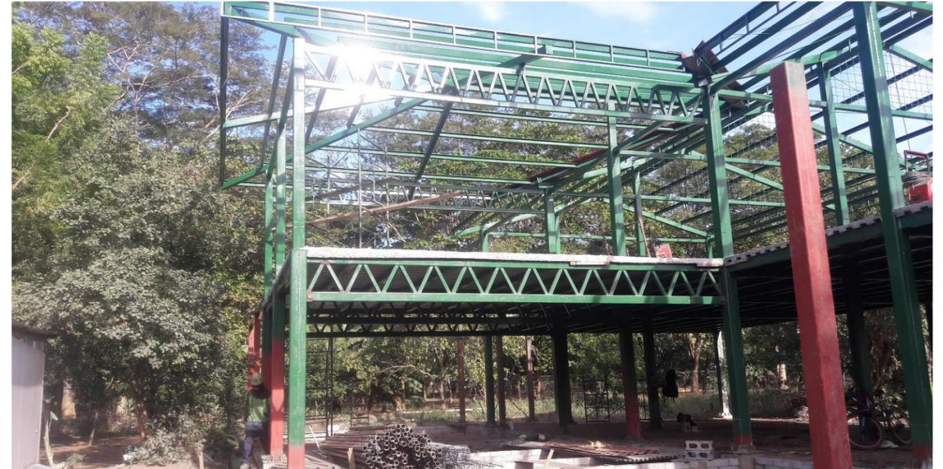
**IMAGEN No. 110** Estructura metálica. Colocación de cercha metálica. Fuente: Autor.
