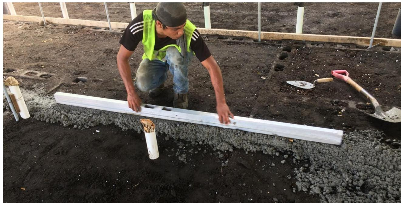
**IMAGEN No. 153** estructural 2500 Psi. Nivelado de concreto con maitras. Fuente: Autor
