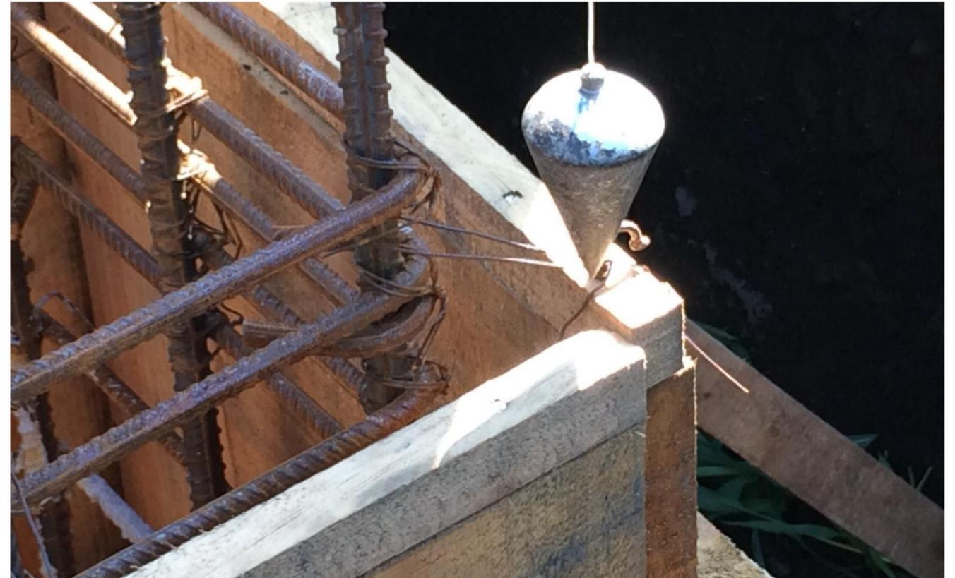
**IMAGEN No. 30** Formaletas. colocación y centralización de formaletas. Fuente: Autor.
