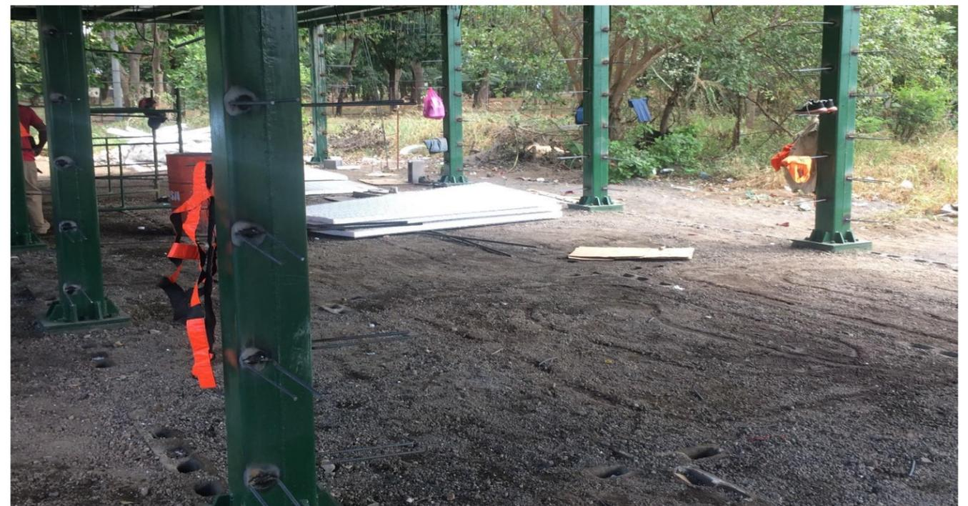
**IMAGEN No. 160** Paredes de covintec. Anclas para paneles de covintec. Fuente: Autor.
