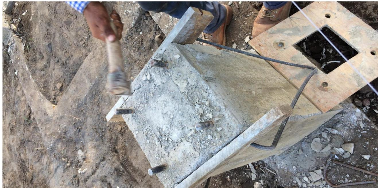
**IMAGEN No. 84** Formaletas. Desencofrado de pedestal PD-2 Y limpieza de borde superior. Fuente: Autor.
