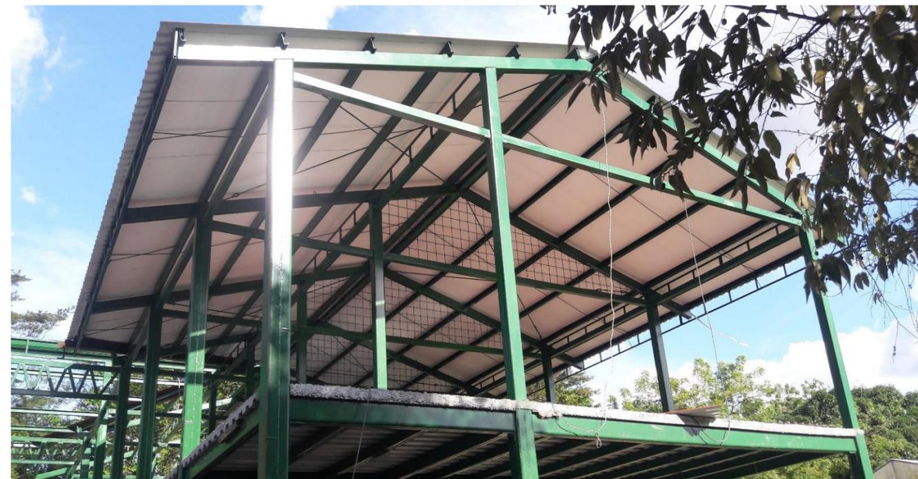
IMAGEN No. 136 Cubierta de techo. Perspectiva frontal de instalación de aislante de techo. Fuente: Autor.
