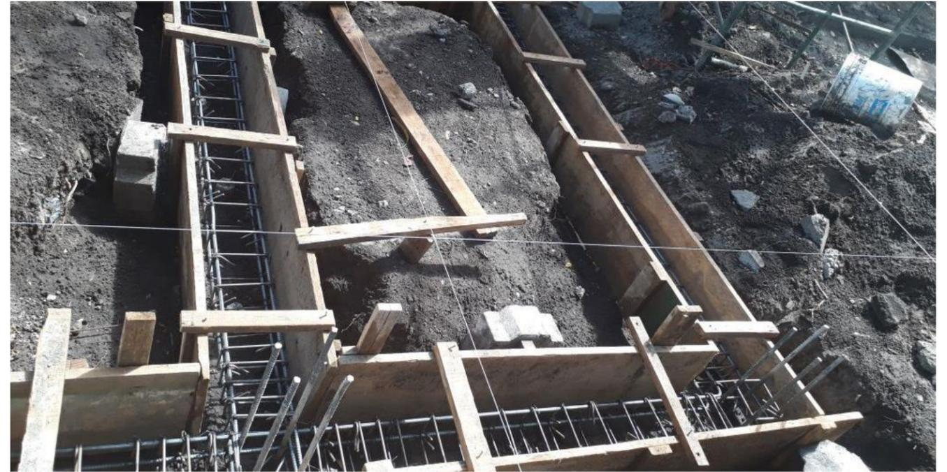
**IMAGEN No. 205** Armado de hierro. instalación de viga asísmica con bastones para mampostería. Fuente: Autor
