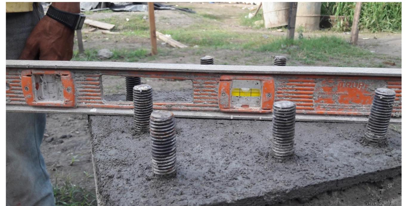
**IMAGEN No. 87** Concreto epóxico. Nivelación de concreto epóxico. Fuente: Autor.
