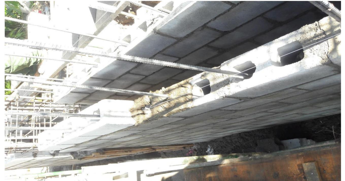
**IMAGEN No. 208** Vista superior de mampostería reforzada con bastones instalados. Fuente: Autor.
