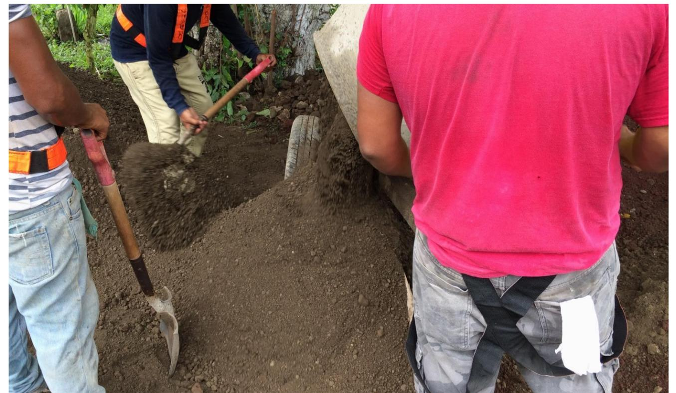
**IMAGEN No. 11** Movimiento de tierra. Mezcla de hormigón con tierra excavada.
