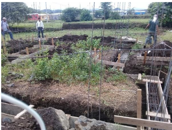
Ilustración 4. Colocación de formaleta y bastones para fundir el concreto
