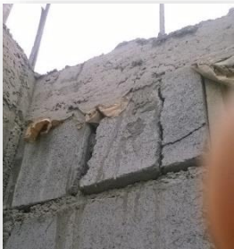
Ilustración 11. Bloque dañado
