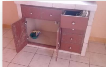
Ilustración 15. Reparación de Pantry.
