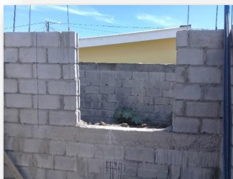
Ilustración 21. Porción de pared a demoler
