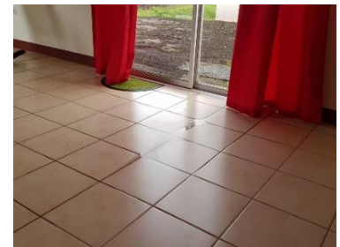
Ilustración 16. Filtración por la puerta de la terraza.
