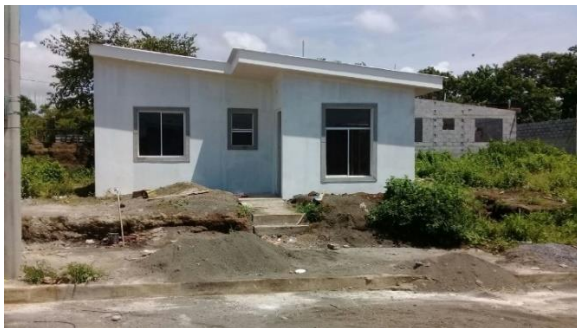
Ilustración 6. Vivienda con pintura base en etapa acabados
