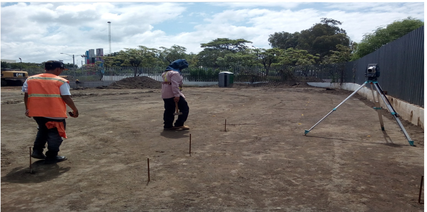
Imagen 14-Supervisión de replanteo de bombas de calor/Fuente: Álvaro Bosques
