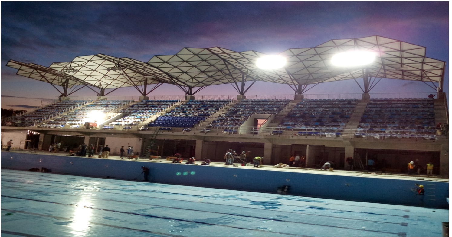
Complejo de Piscinas Michelle Richardson en construcción /Fuente: Álvaro Bosques
