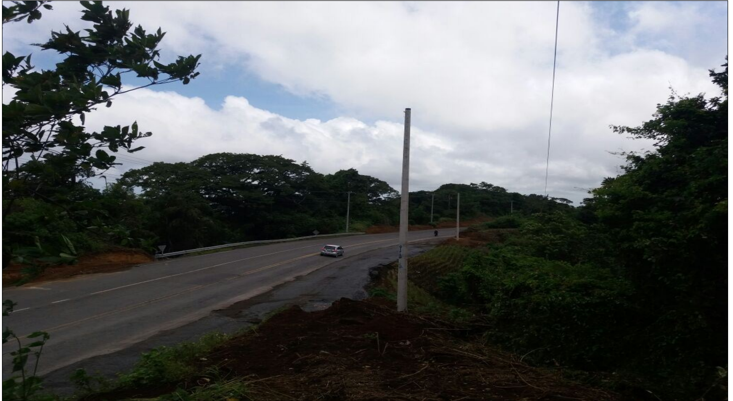
Imagen 26-Colocación de poste eléctrico en Carretera Nejapa-Diriamba/Fuente: Álva-
