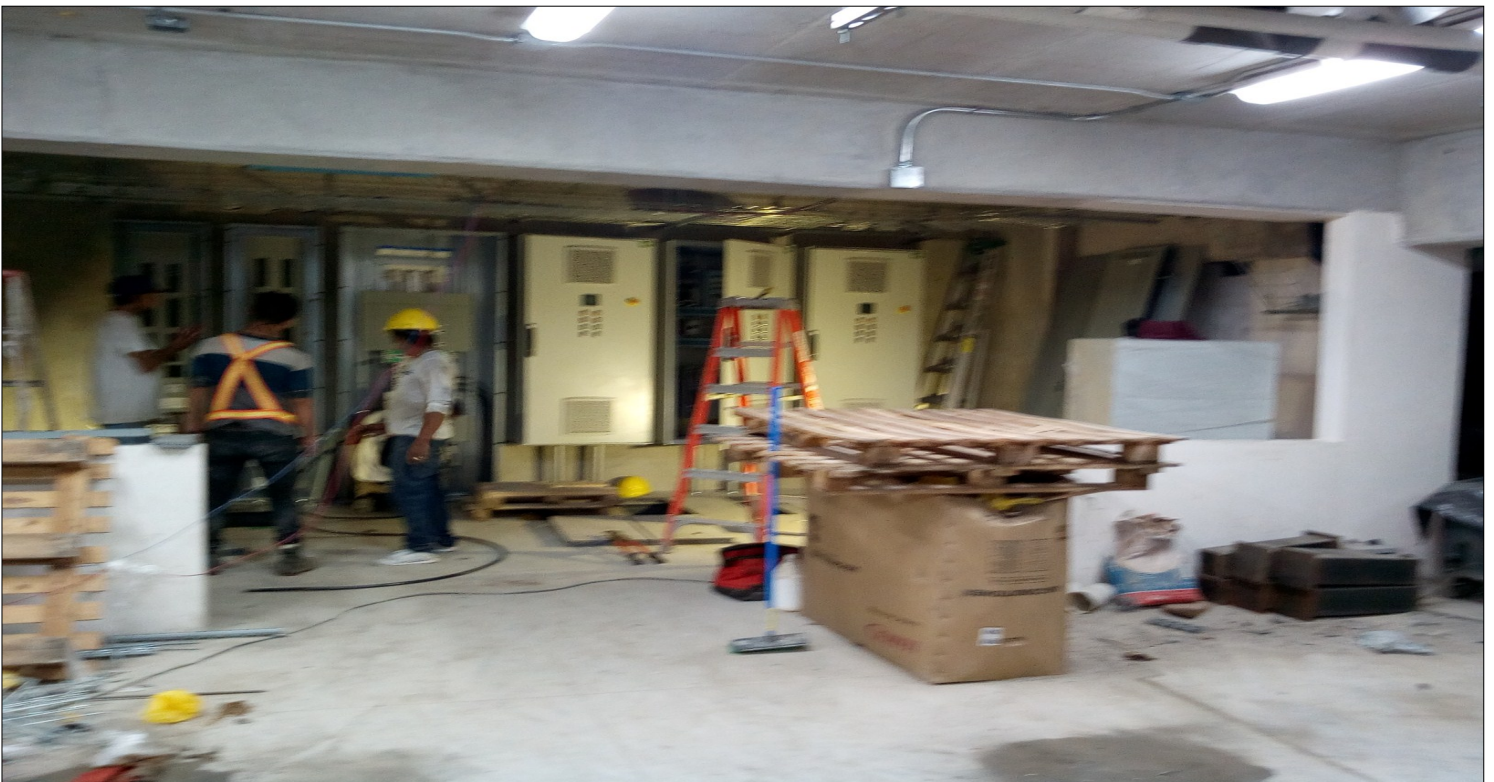
Cuarto de paneles en sótano del Complejo de Piscinas Michelle Richardson en construcción/ Fuente: Álvaro Bosques
