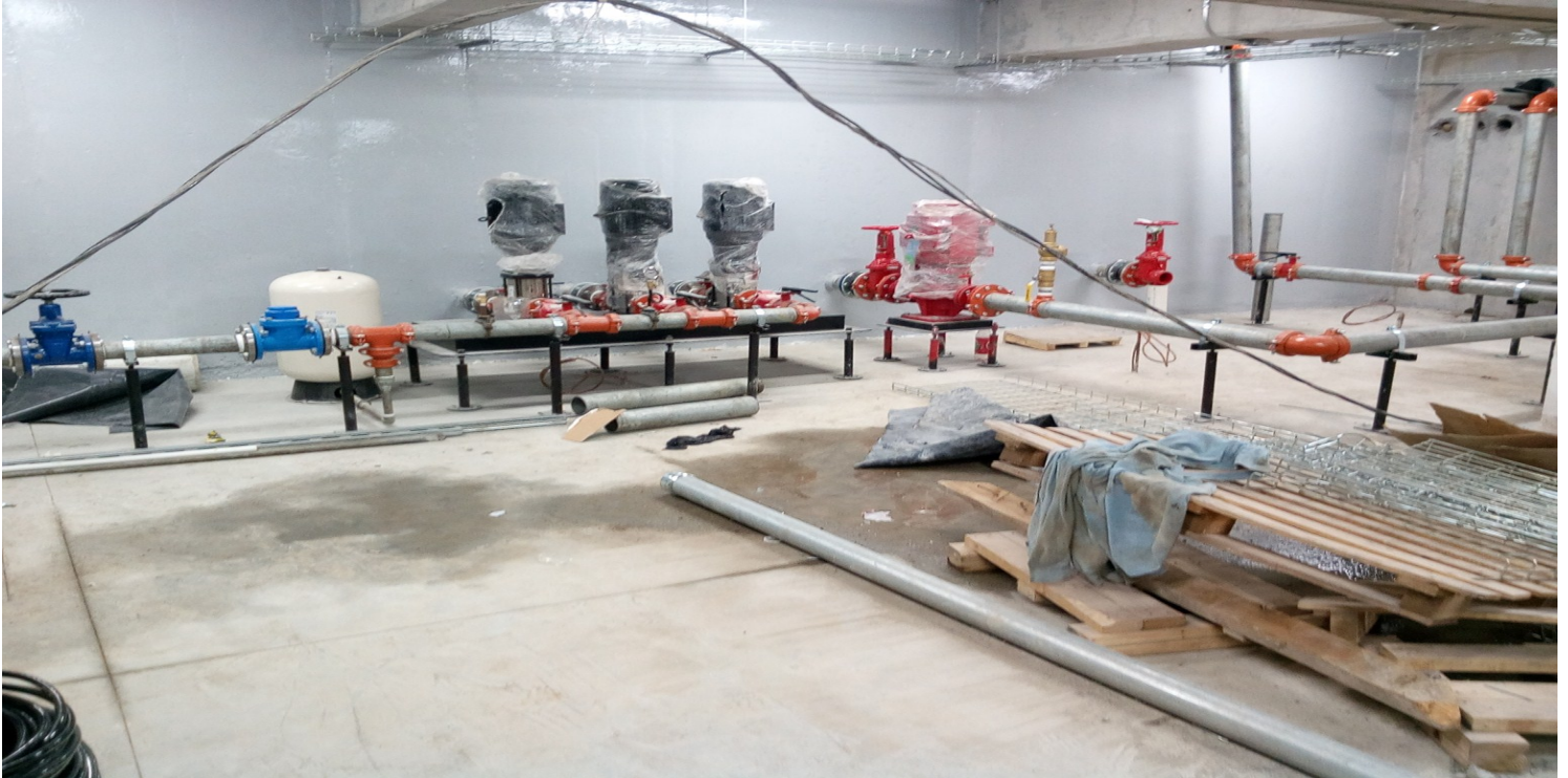
Imagen 13- Bombas de presurización de limpieza de piscinas Michelle Richardson/Fuente: Álvaro Bosques
