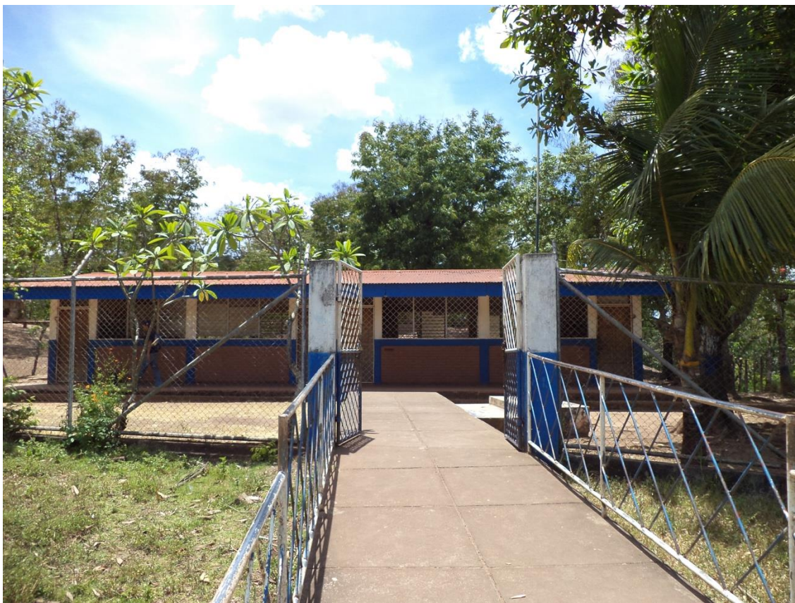
Figura 12: Vista frontal del pabellón de 2 aulas, Centro Escolar San Pablo de Kubaly Fuente: elaboración propia, municipio de Waslala, Región Autónoma Costa Caribe Norte.
