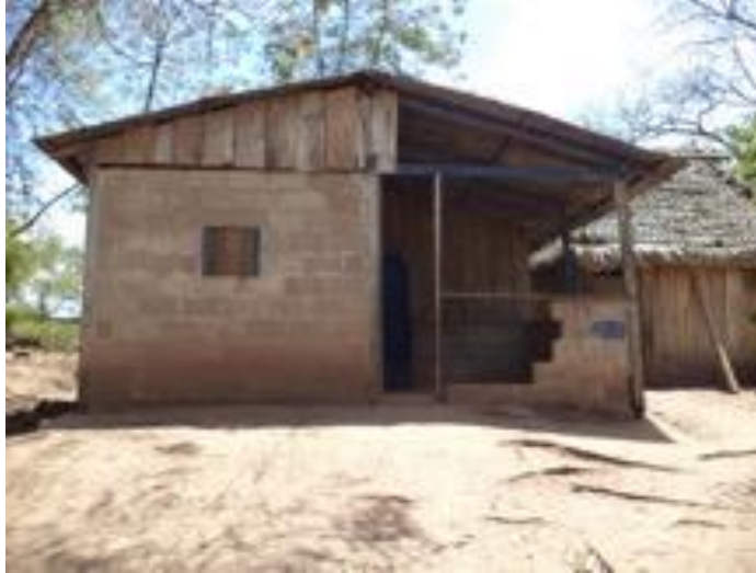
Figura 13: vista frontal del aula provisional de Preescolar del Centro Escolar San Pablo de Kubaly, municipio de Waslala, Región Autónoma Costa Caribe Norte. Fuente: elaboración propia.
