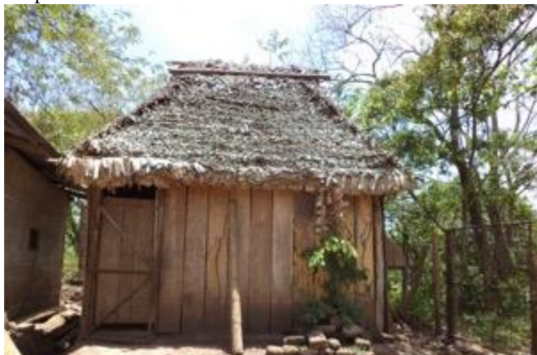
Figura 15 Vista frontal de la cocina del Centro Escolar San Pablo de Kubaly, Fuente: elaboración propia, municipio de Waslala, Región Autónoma Costa Caribe Norte.
