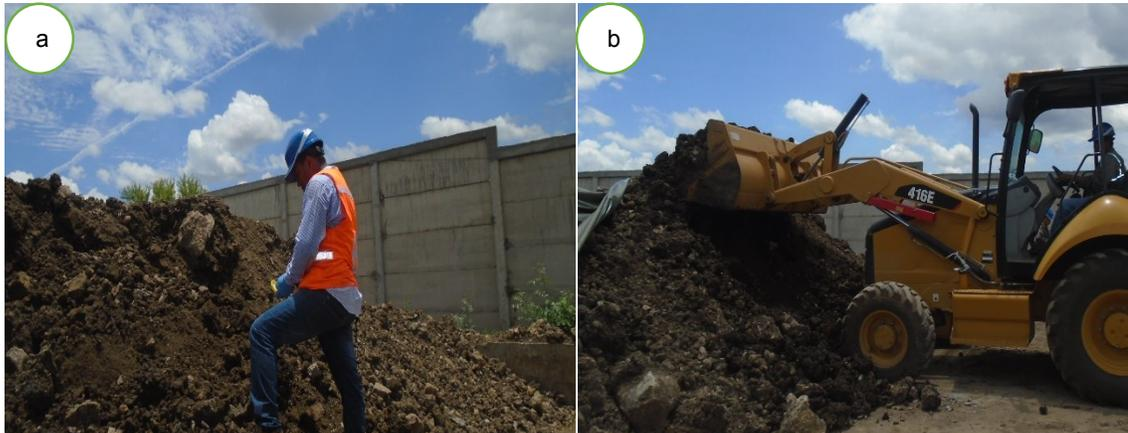
**Figura 4.1** a) Selección de lote de suelo b) Homogenización mecánica del lote de suelo
