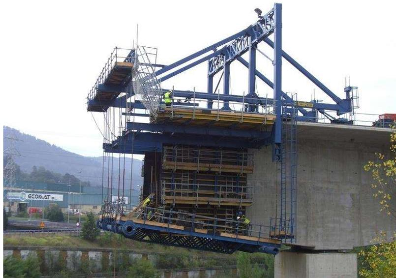
**Ilustración 31 (Vista de un sistema con los carros de avance)**
