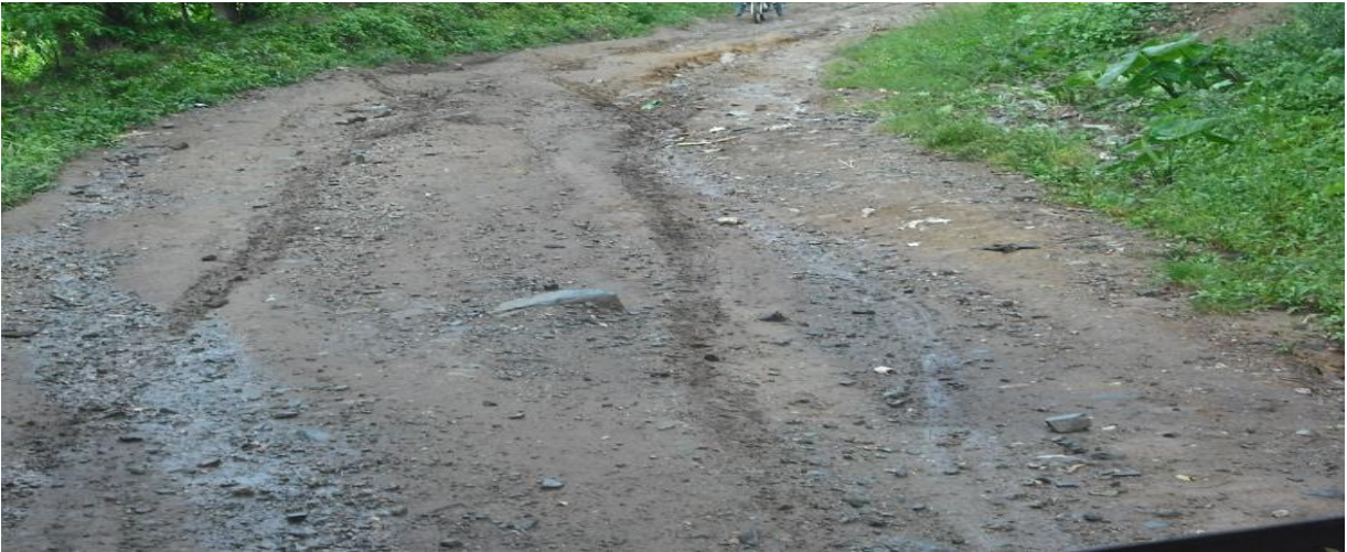
Foto N° 1: Tramo en invierno
