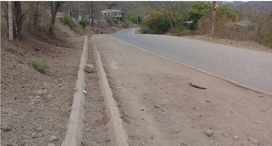
Foto N° 6: La calzada donde finaliza el Adoquinado
