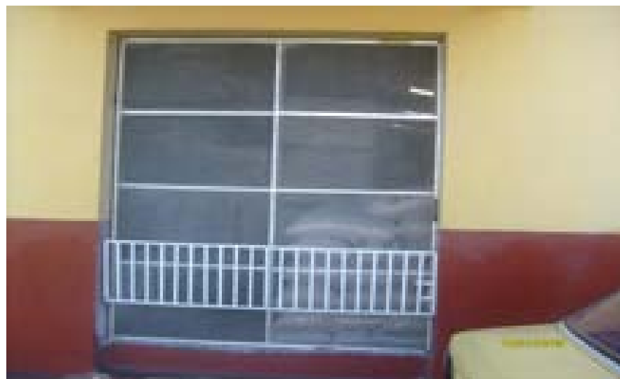
Fig. No. 7.26 Ventanas con Cedazo
