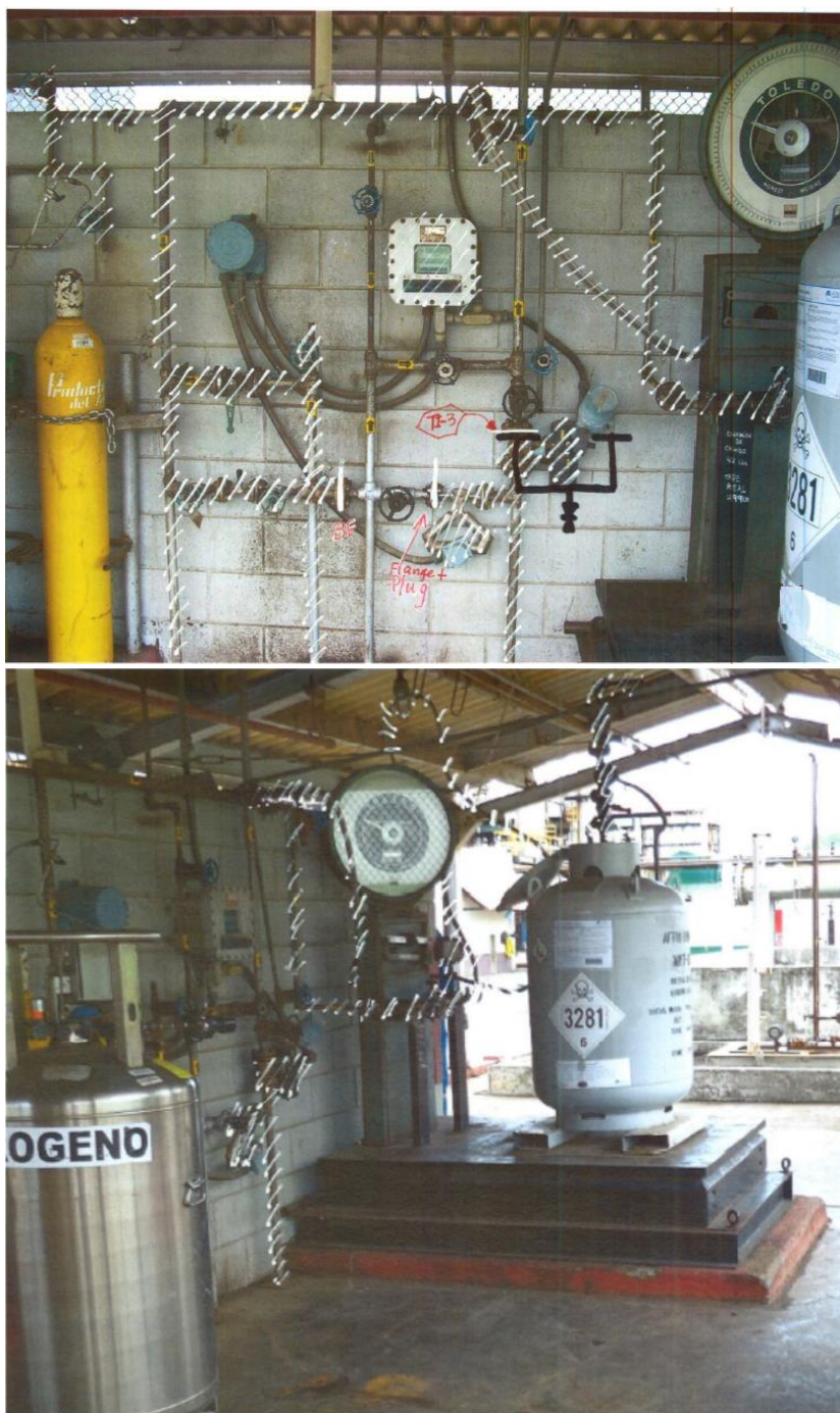
Ilustración 18: Sistema actual - Líneas trazadas a ser eliminadas
