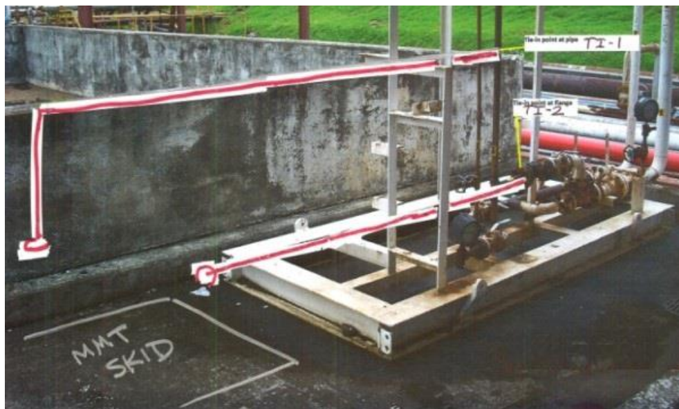
Ilustración 20: Localización de Tie-In 1 y 2 (esperas para plataforma)
