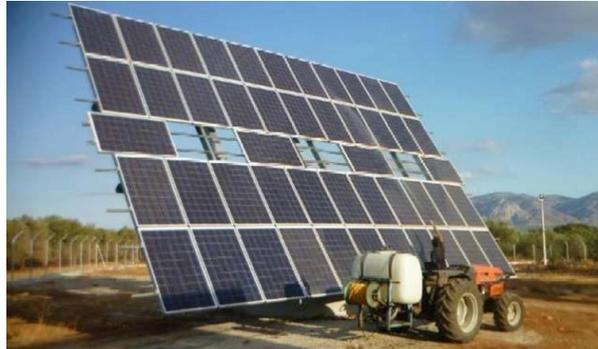
*Figura 27: Sistema de una instalación fotovoltaica en limpieza por chorro de agua.*
