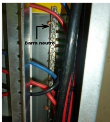
Figura 38: Línea Neutro del Panel de alimentación.
