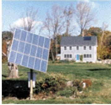
*Figura 13: Emplazamiento de paneles a través de poste vertical.*
