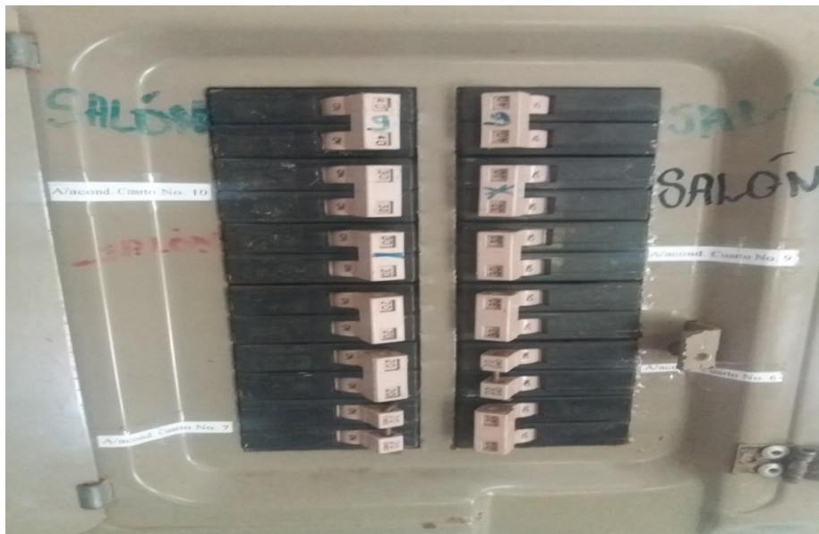
Ilustracion19 Caja de brackest de las luminarias del salón de evento del hotel
