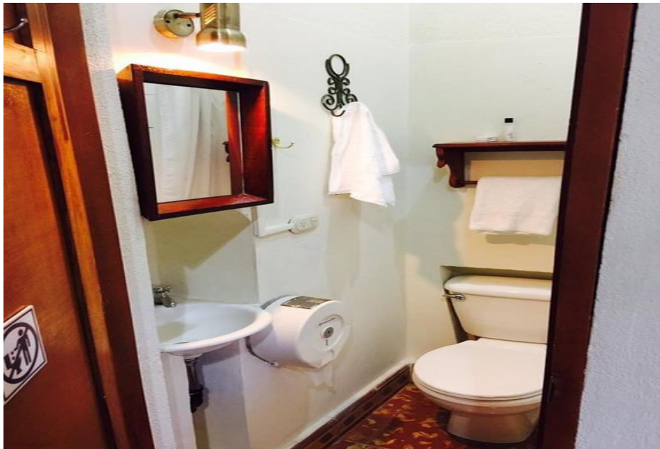
Ilustracion11 luminaria utilizadas en los baños de las habitaciones del hotel
