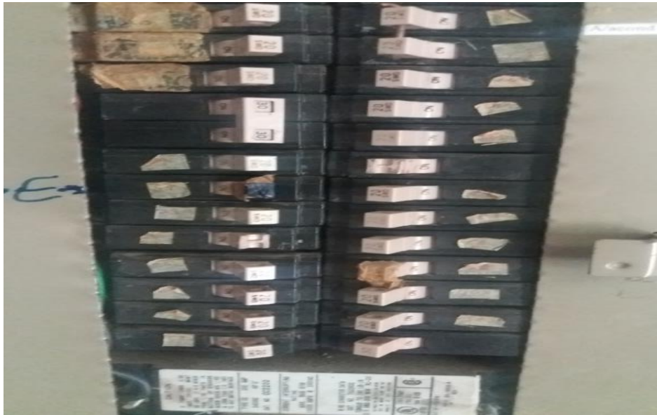
Ilustracion16 Caja de brackest de las luces instaladas en los pasillos del hotel
