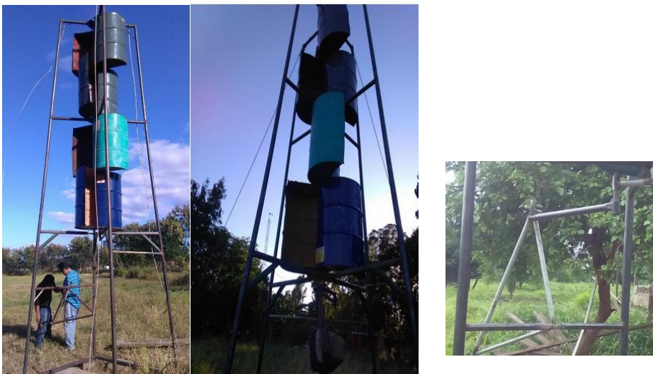
Figura 35. Sistema de bombeo eólico construido e instalado en el Recinto Simón Bolívar
