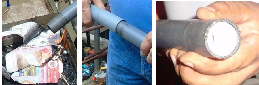
Figura 30. Válvula de pie construida
