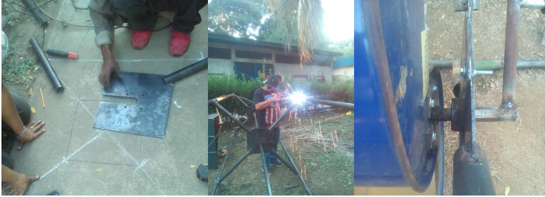
Figura 34. Proceso constructivo de la torre y el rotor
