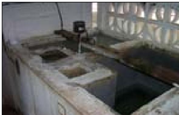
Figura 4.19 Dosificador de Sulfato de Aluminio.
