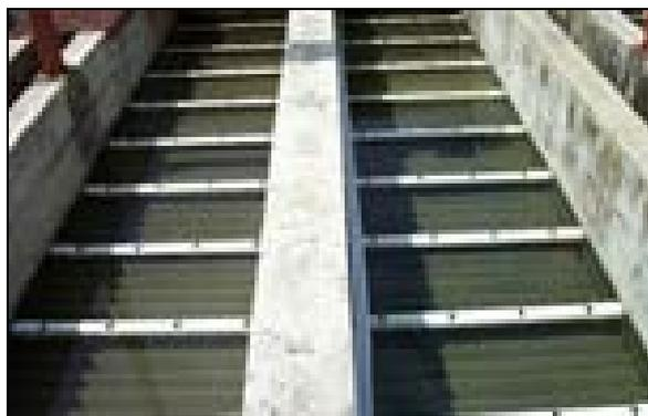
Figura 4.16 Decantadores de alta tasa a Flujo Laminar.
