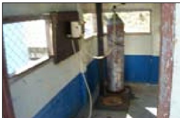
Figura 4.10 Tanque de Almacenamiento de Cloro.
