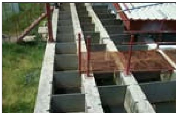
Figura 4.15 Floculador Hidráulico de Flujo Vertical.
