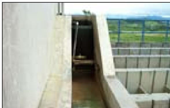
Figura 4.21 Cámara de Llegada y Proceso de Coagulación.
