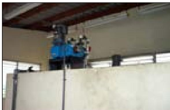
Figura 4.26 Dosificador de Sulfato de Aluminio.
