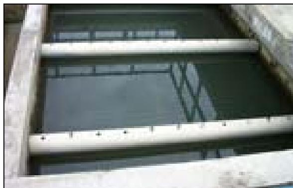
Figura 4.23 Sedimentador.
