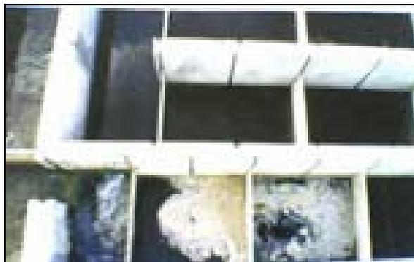
Figura 4.29 Cámara de Entrada de Agua y Flocladores Hidráulicos.
