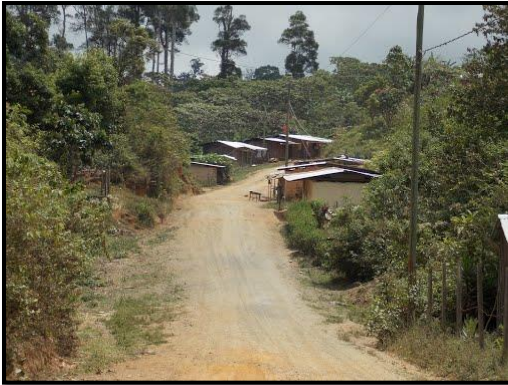
Imagen No. 20: Fin del tramo entrada a la comunidad (Est. 1+400).
